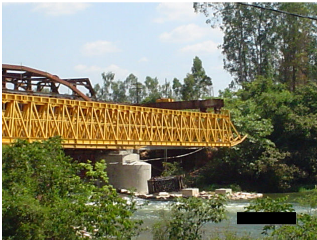
Foto 1 – De jusante, observamos detalhe do par de treliças sinistrado.
