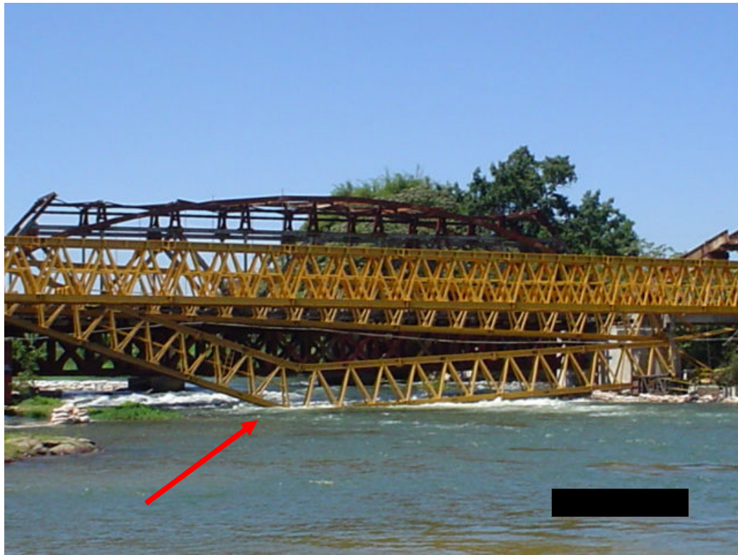
Foto 2 – Vista geral do acidente, mostrando treliça rompida e evidenciando o não rompimento de treliça similar.
