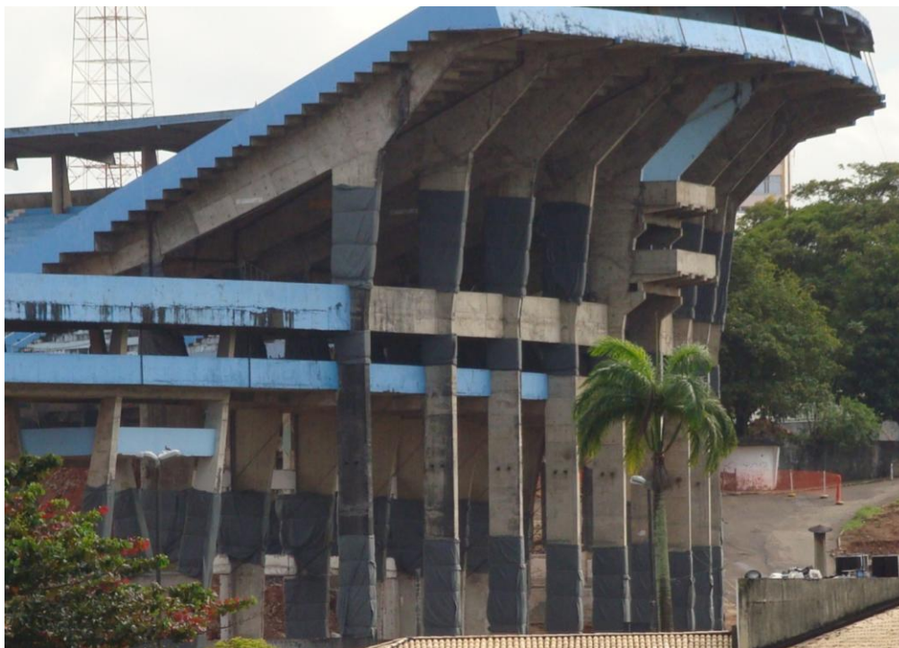
Figura 2 – Detalhes da proteção de pilares do estádio momentos antes da implosão
