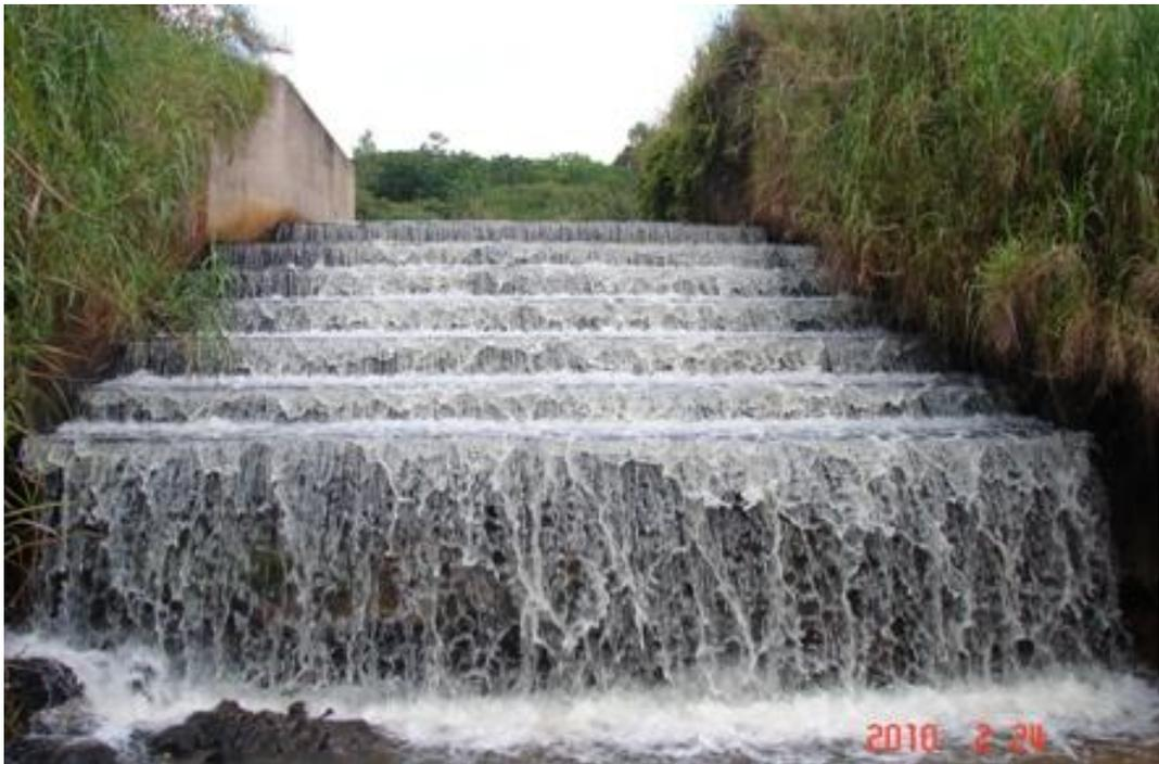
**Foto 12.** Escada de dissipação de energia do vertedouro vista de jusante.
