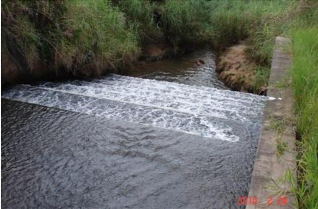
**Foto 11.** Escada de dissipação de energia do vertedouro, vista de montante.
