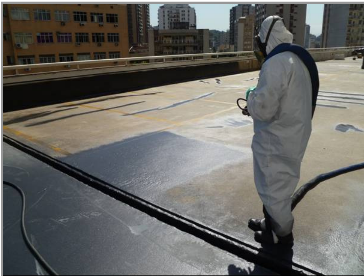
Foto nº 10: Aplicação do produto no piso do estacionamento
