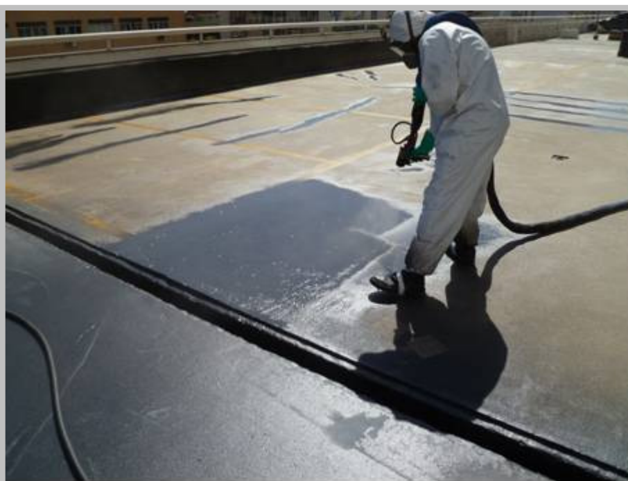
Foto nº 9: Aplicação do produto no piso do estacionamento
