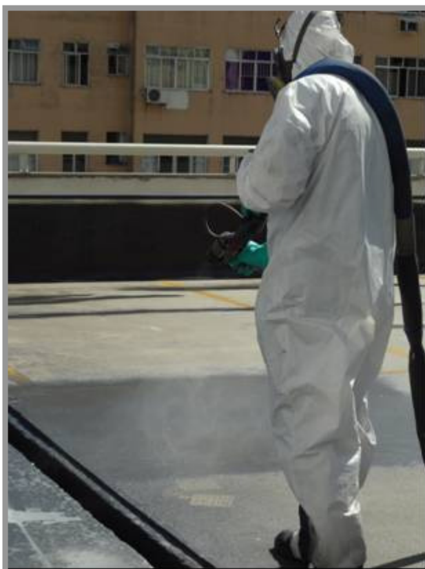
Foto nº 8: Aplicação do produto no piso do estacionamento
