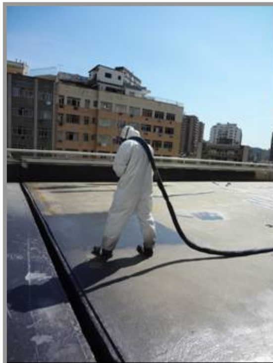
Foto n o 7: Aplicação do produto no piso do estacionamento
