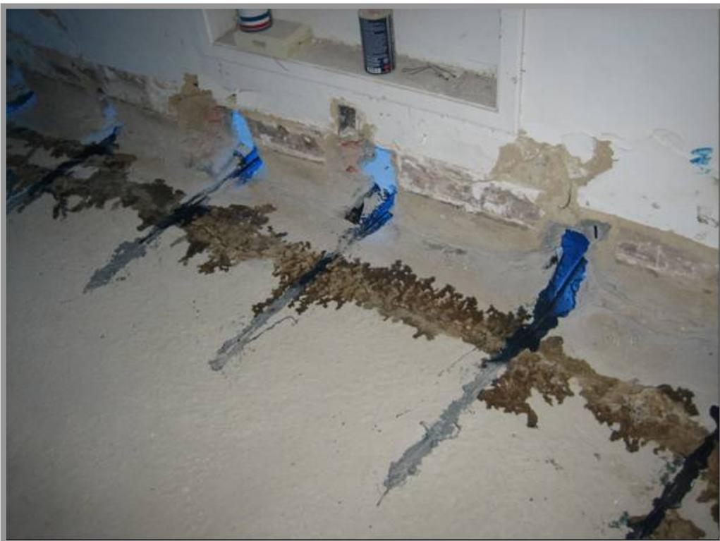
Fotos n<sup>os</sup> 38 e 39: Fita instalada e fechamento dos sulcos.
