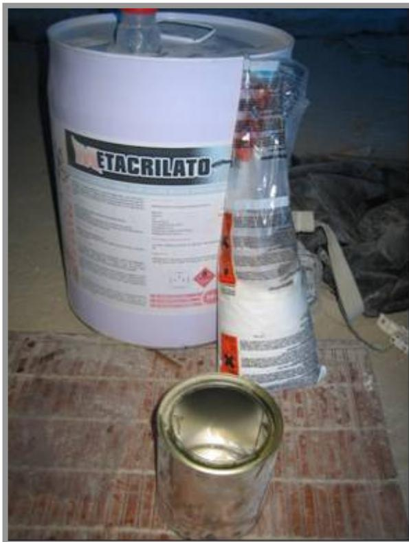
Fotos n<sup>os</sup> 30 e 31: Aplicação de metacrilato nas fissuras do piso.
