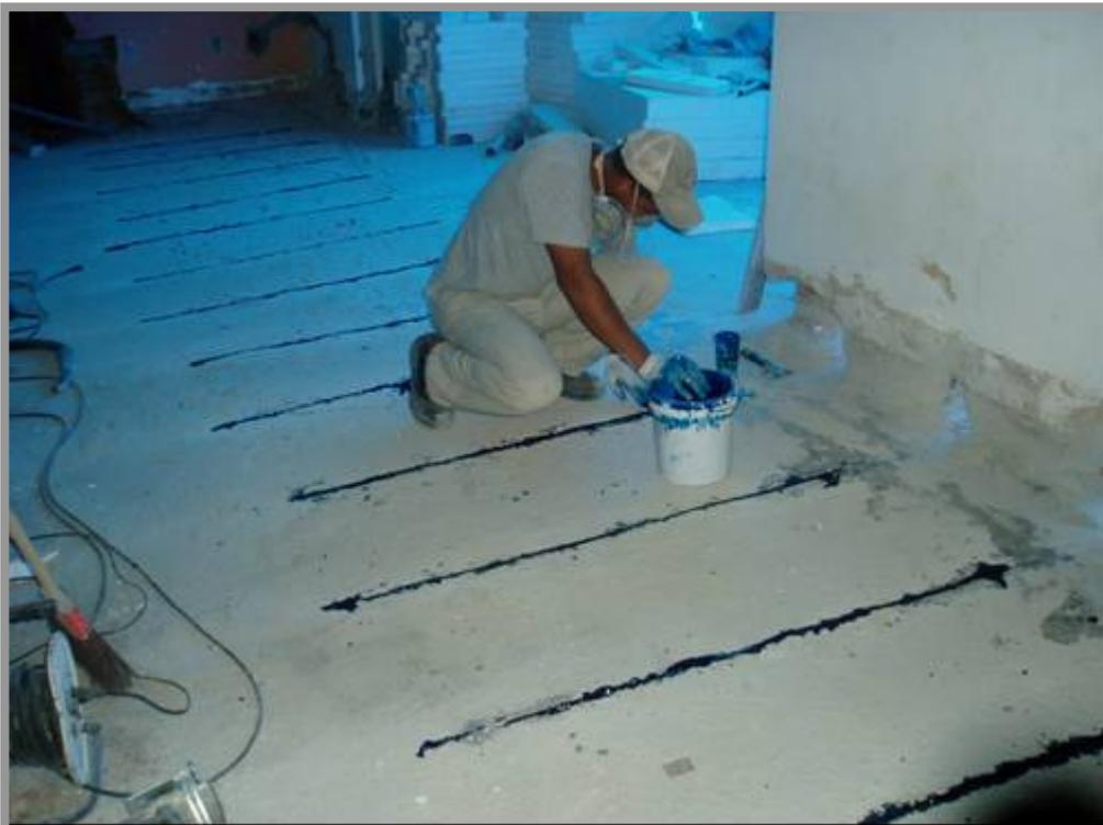
Fotos nºs 34 e 35: Abertura dos sulcos na superfície nos locais para colocação da fita com aplicação de epoxi.
