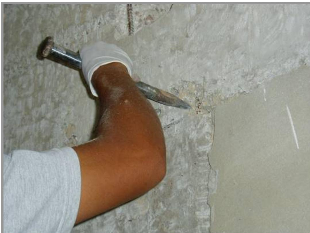
Foto nº 16: Parede sendo apicoada para aplicação de material.
