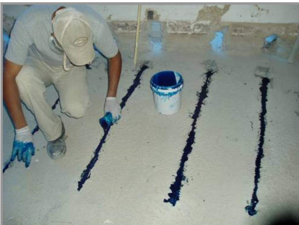
Fotos nºs 36 e 37: Aplicação do epóxi nos sulcos executados para colocação da fita de carbono.
