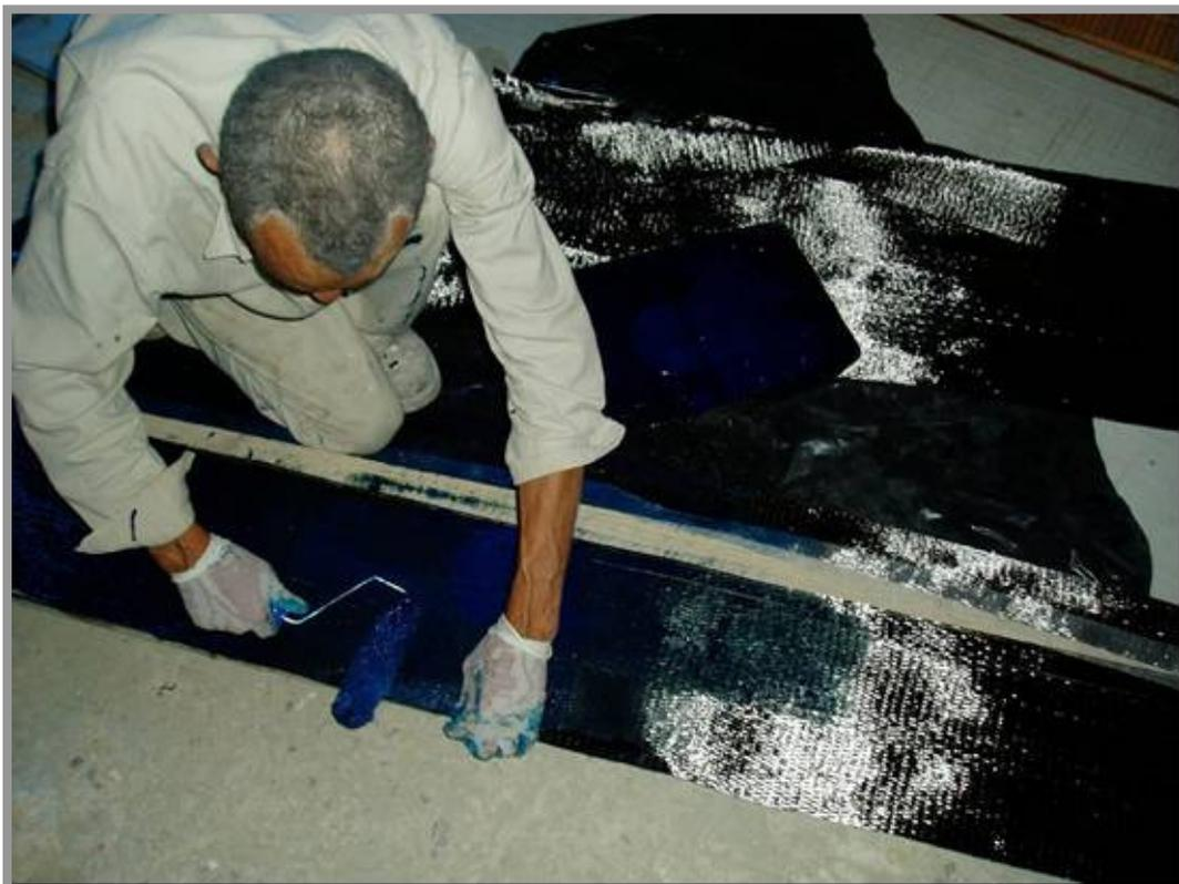
Fotos nºs 26 e 27: Preparo da viga para receber a fibra de carbono e a fibra recortada recebendo cola para ser aplicada.
