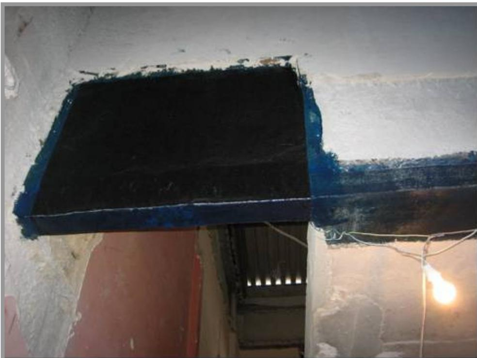
Fotos nºs 28 e 29: Viga reforçada com fibra de carbono
