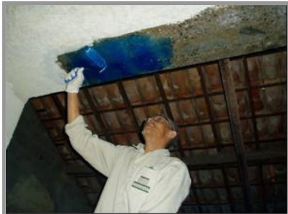
Fotos n<sup>os</sup> 24 e 25: Preparo da viga para receber o reforço em fibra de carbono.
