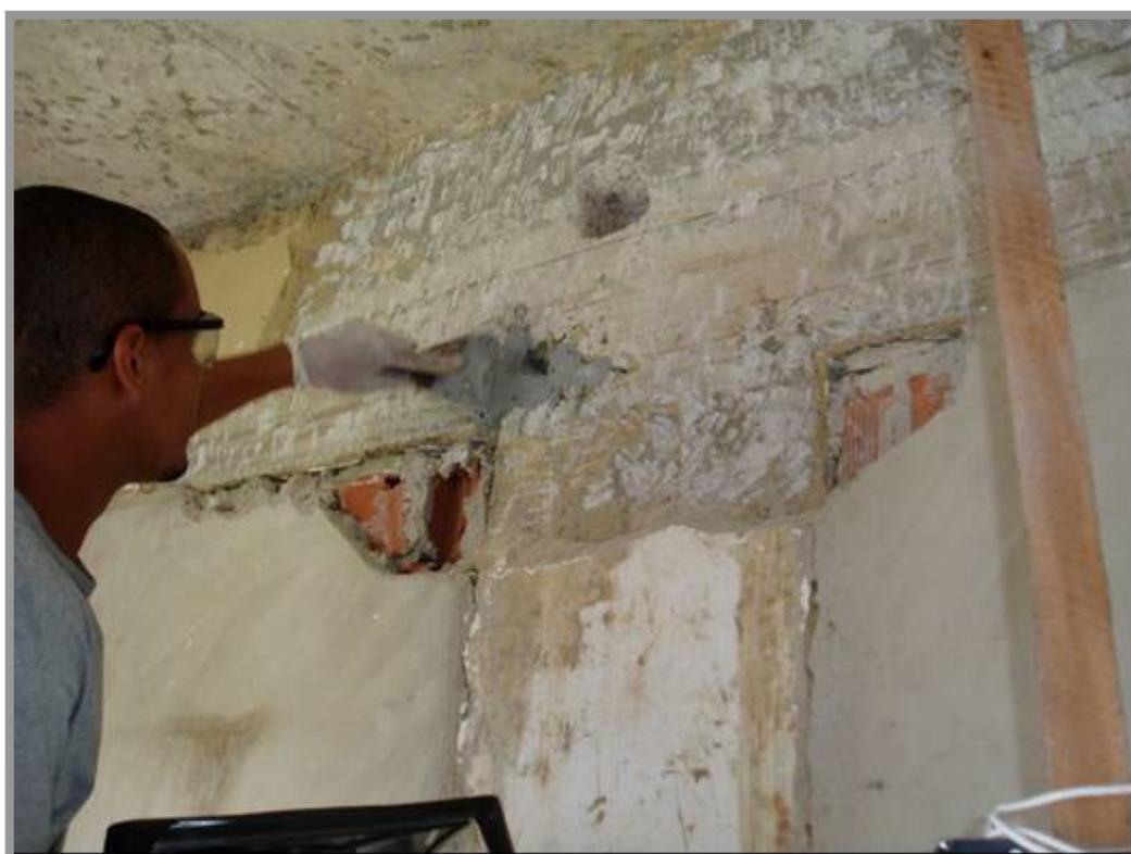
Fotos n<sup>os</sup> 17 e 18: Pilar sendo reforçado.
