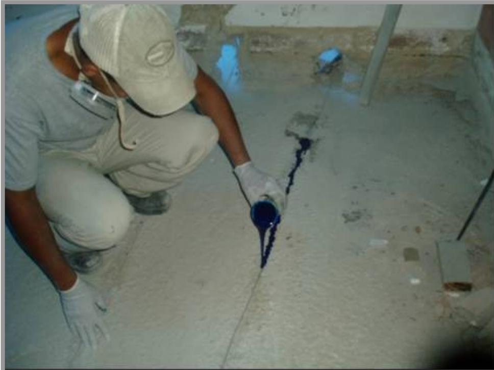
Fotos n<sup>os</sup> 32 e 33: Abertura dos sulcos na superfície nos locais para colocação da fita com aplicação de epoxi.
