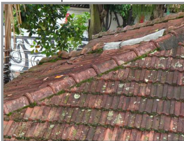
Foto nº 17: Telhado deteriorado com presença de musgo e escurecimento das telhas. Verificação de telhas soltas e danificadas
