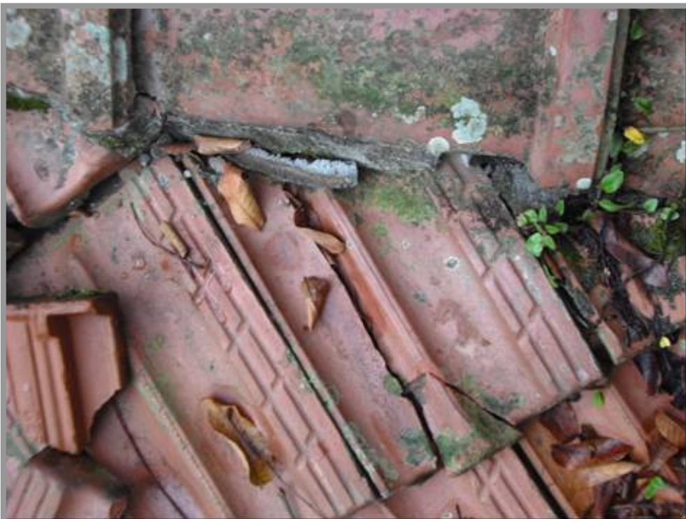
Fotos nºs 24 e 25: Telhado deteriorado sem manutenção.
