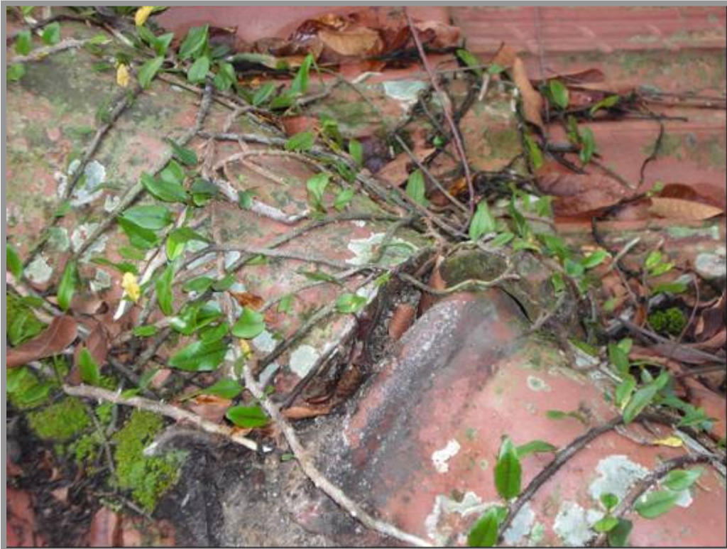
Foto nº 20: Telhado deteriorado com presença de musgo e brotamento de vegetação. Total perda de vitrificação.
