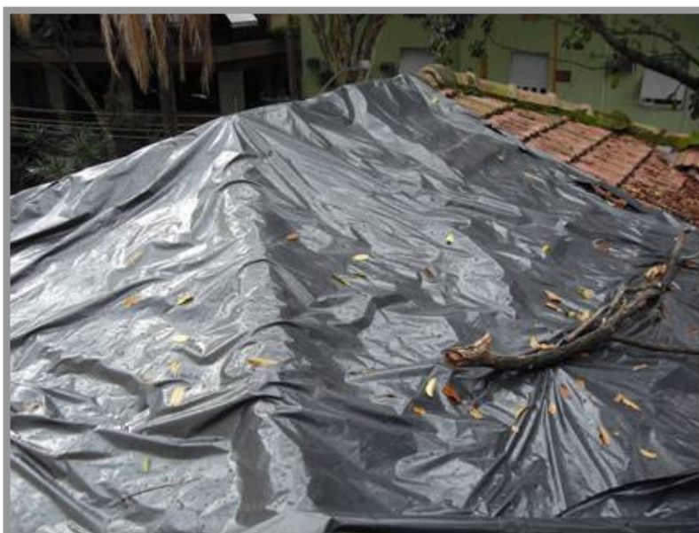
Foto nº 16: Telhado deteriorado, com lona plástica colocada para evitar a passagem das águas de chuva.
