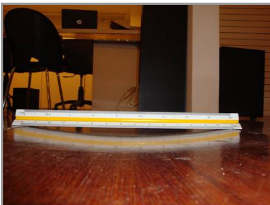
Foto nº 8: Tábuas de revestimento do piso da sala frontal, com empenamento em função da umidade existente.
