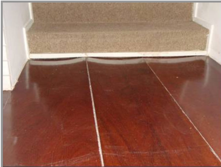
Foto nº 9: Tábuas de revestimento do piso da sala frontal, com empenamento em função da umidade existente.
