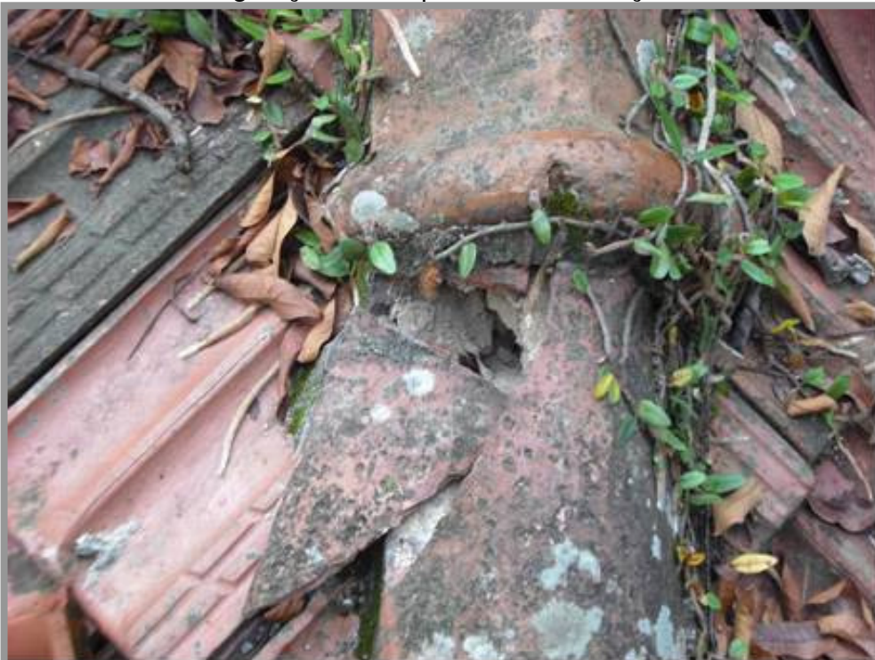
Foto nº 21: Telhado deteriorado com presença de musgo e brotamento de vegetação. Total perda de vitrificação
