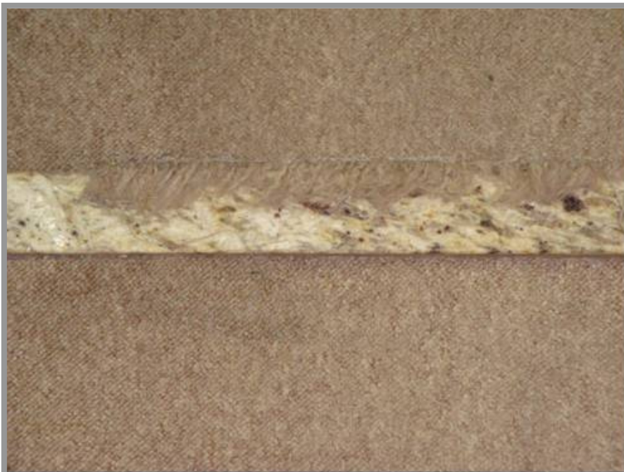
Foto nº 10: Carpete instalado no 2º pavimento, deteriorado em função das constantes infiltrações.
