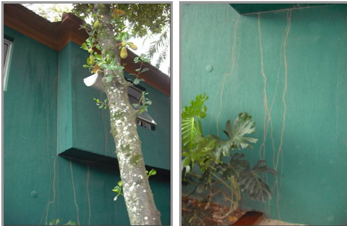
Fotos nºs 11 e 12: Fachada externa com sinais de caminhos percorridos pelos “cupins” já eliminados.
