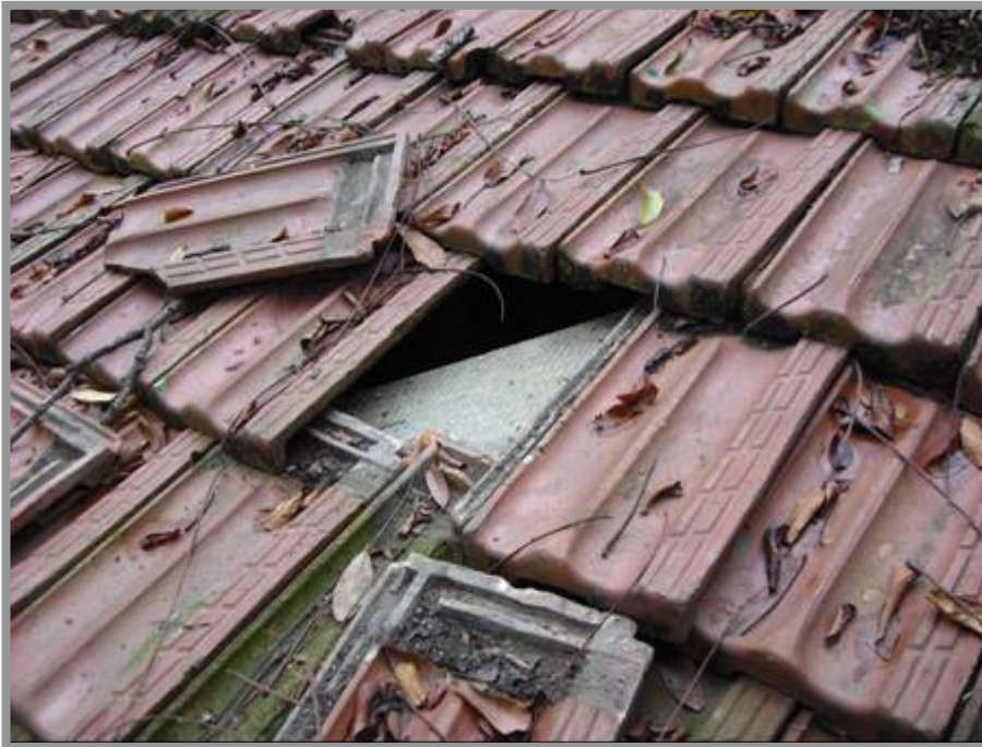
Fotos nºs 26 e 27: Telhado deteriorado sem manutenção.
