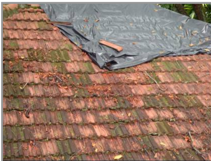
Fotos nºs 14 e 15: Telhado deteriorado, com lona plástica colocada para evitar a passagem das águas de chuva.
