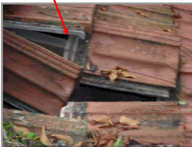
Fotos nºs 22 e 23: Telhado deteriorado sem manutenção.
