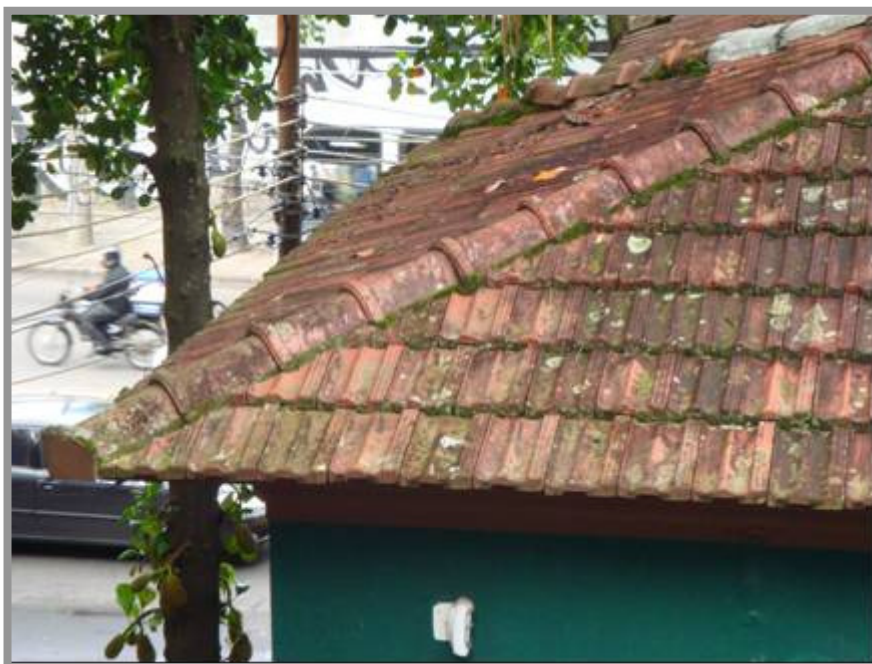
Fotos n os 18 e 19: Telhado deteriorado com presença de musgo e escurecimento das telhas. Verificação de telhas soltas e danificadas
