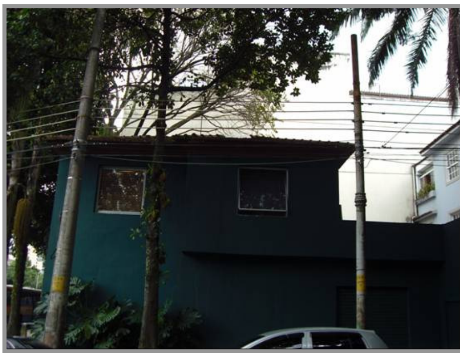
Foto n° 6: Fachada da edificação
