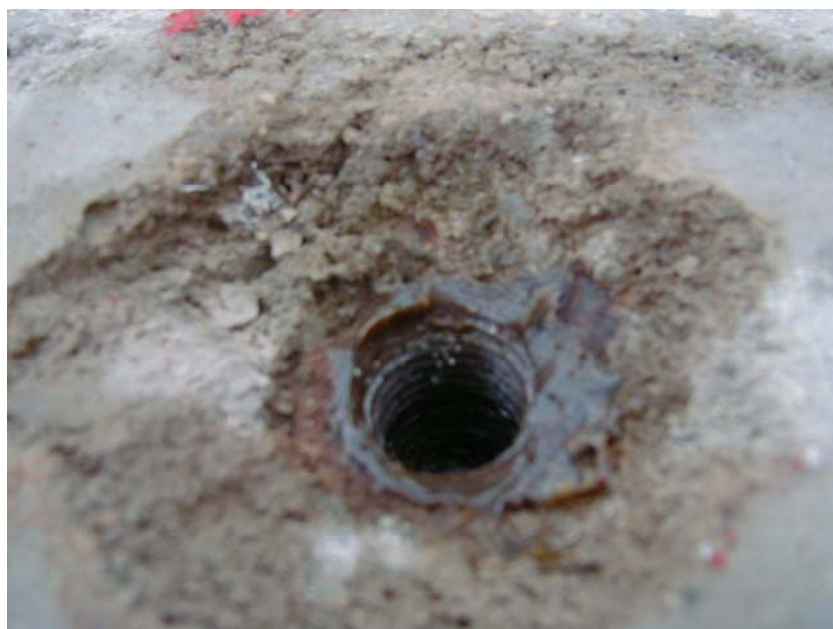
Figura 10 – Luva em rosca fêmea inserida na peça de concreto, na qual é rosqueada o parafuso da alça de içamento.
