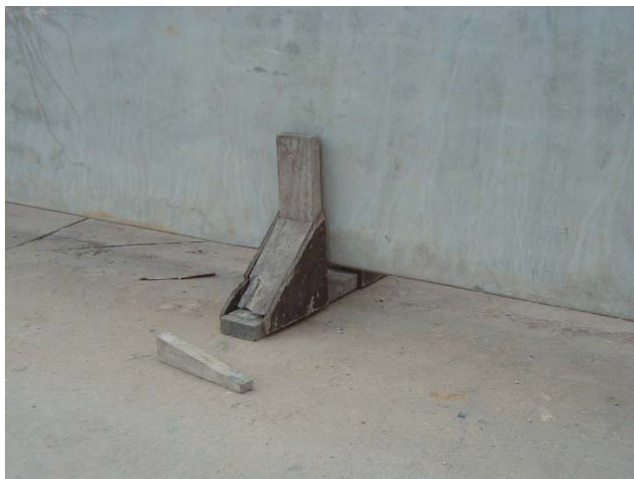
Figura 02 – Acessório utilizado para deixar a peça na vertical, posição em que deve ser içada.
