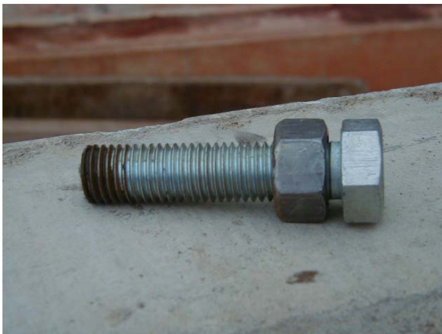
Figura 09 – Parafuso de ancoragem da alça de içamento ao painel de concreto.
