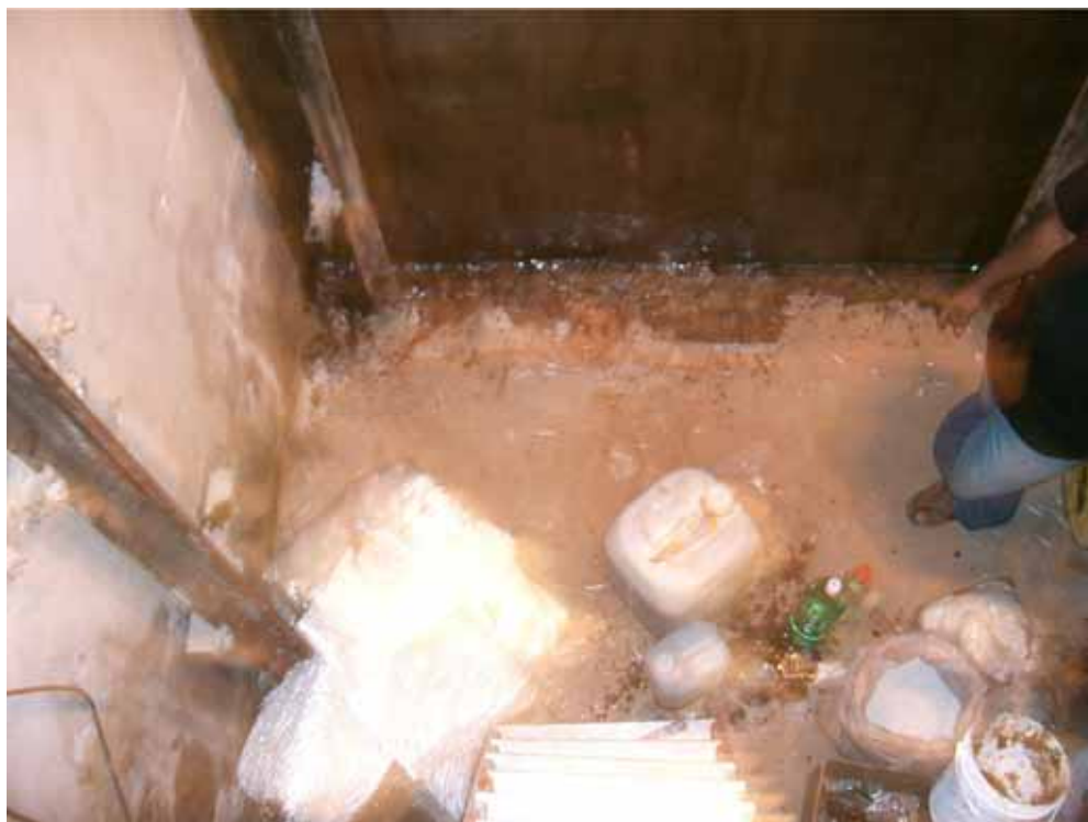
Foto 5 – Vista dos trabalhos de impermeabilização com fibra de vidro
