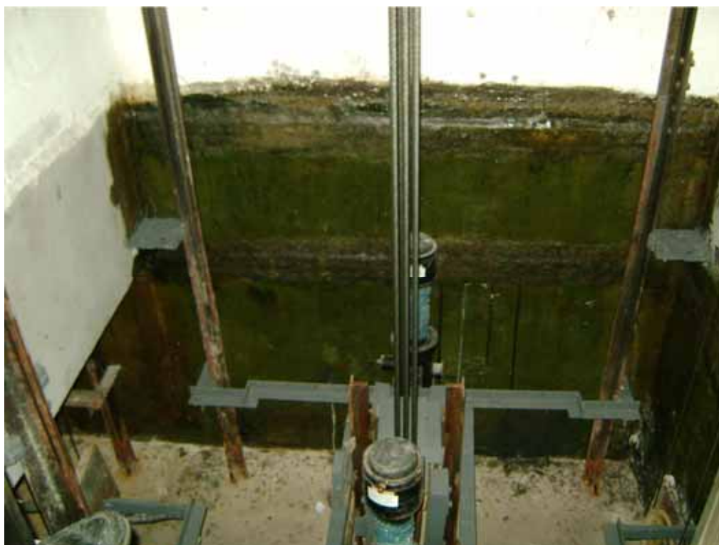
Foto 7 – Vista do poço de elevador com o serviço de fibra acabado
