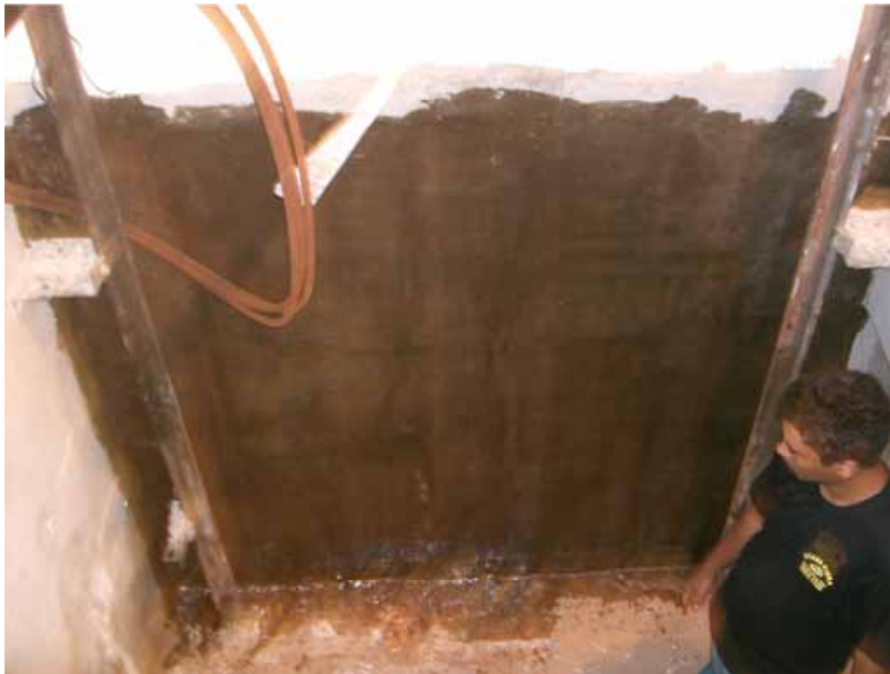
Foto 5 - Foto do trabalho de impermeabilização com fibra de vidro
