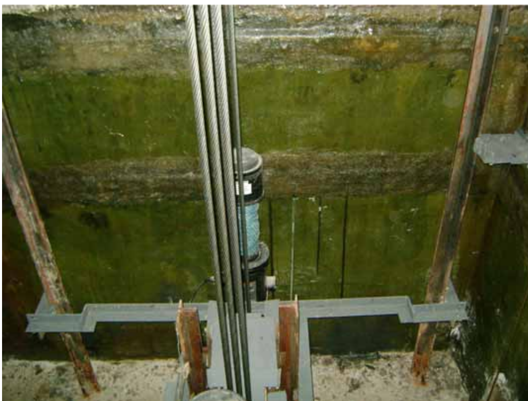
Foto 6 – Vista do poço de elevador com o serviço de fibra acabado
