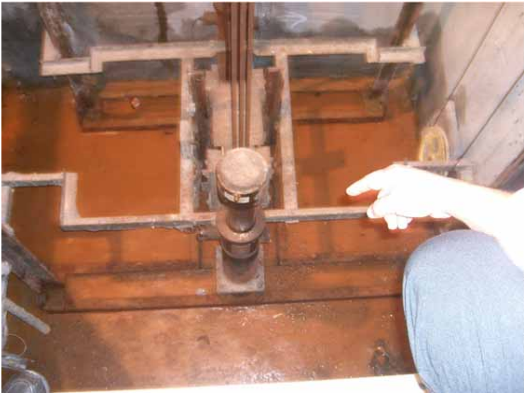
Foto 3 – Vista das máquinas do elevador enferrujadas
