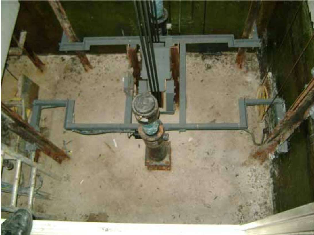
Foto 8 – Vista do poço de elevador com o serviço de fibra acabado
