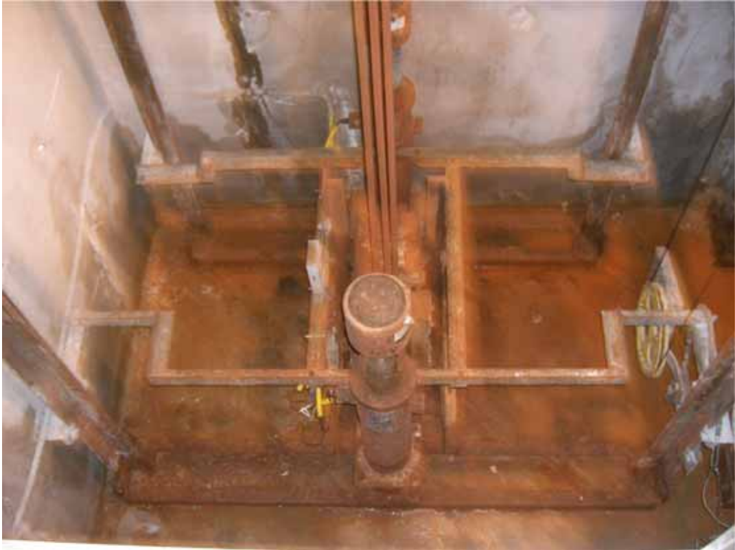
Foto 2 - Vista do poço de elevador com infiltração
