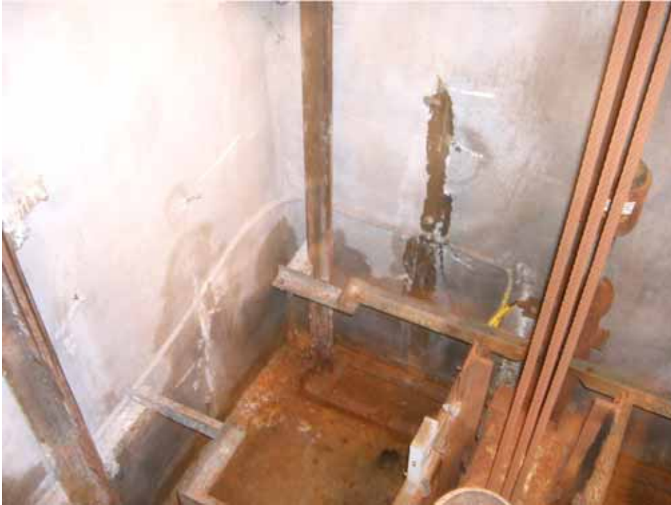
Foto 4 - Vista dos bicos de injeção de espuma de poliuretano
