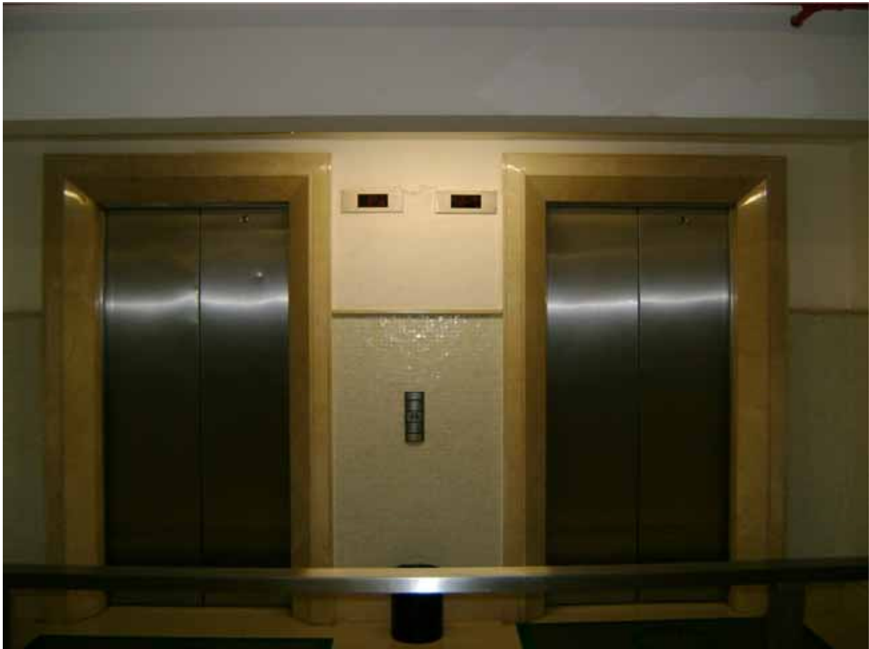
Foto 1 – Vista externa dos elevadores onde se vê os portais em mármore crema marfil, pastilhas de vidro brancas e portas em aço inoxidável.
