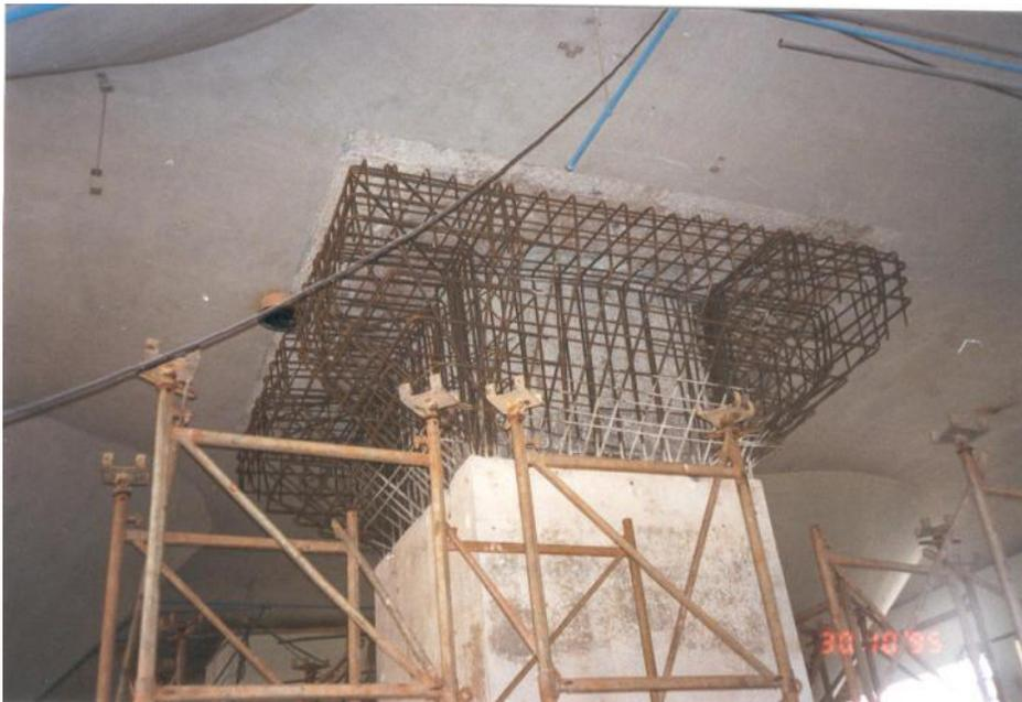
Fig. 18 – Detalhe da Armadura do Console de Reforço de Pilar Central
