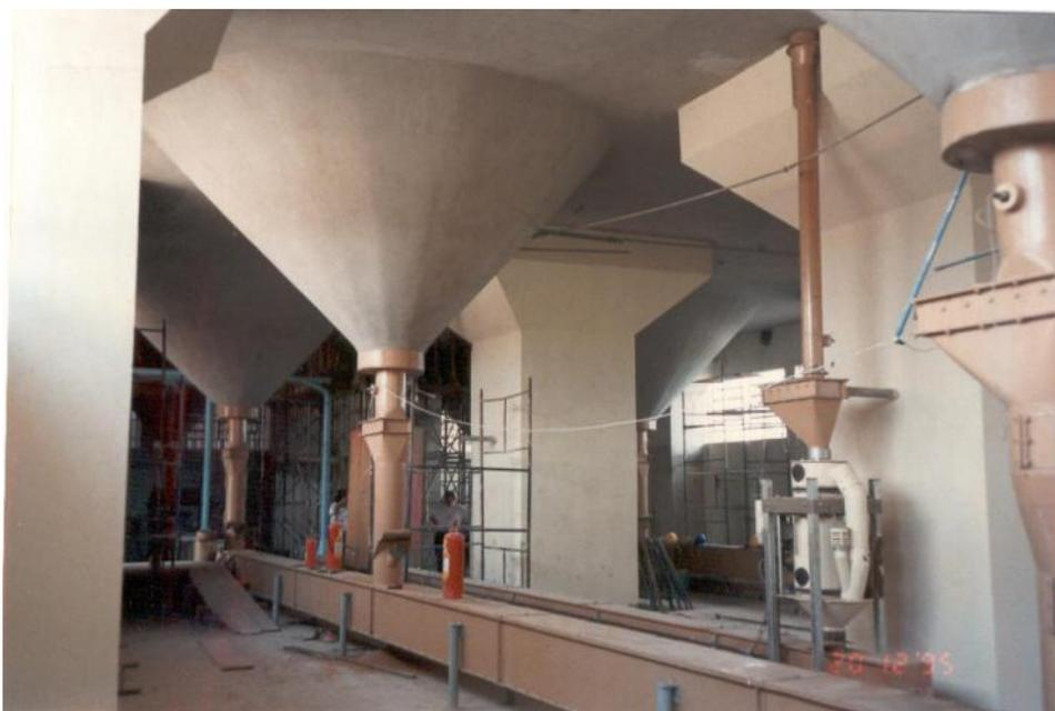
Fig. 19 – Aspecto do reforço e consoles executados na linha de pilares centrais
