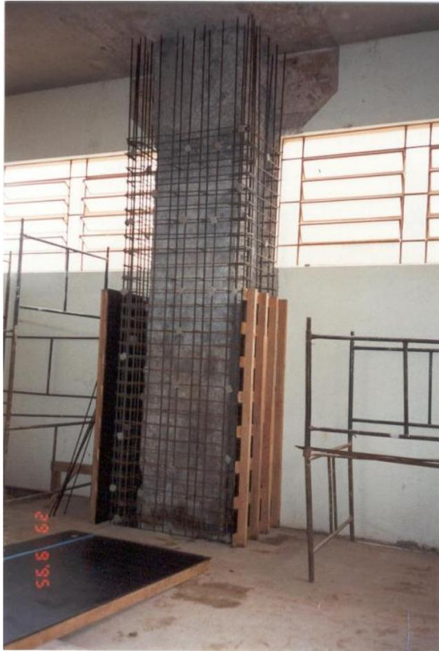
Fig. 16 – Armadura de Reforço de Pilar Periférico
