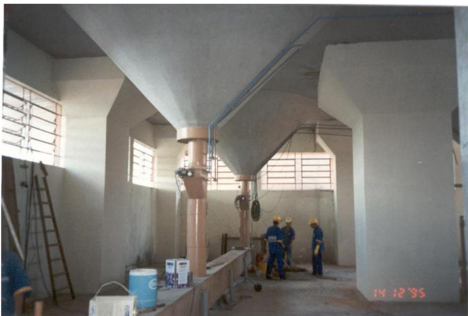
Fig. 20 – Aspecto do reforço e consoles executados na linha de pilares centrais e periféricos
