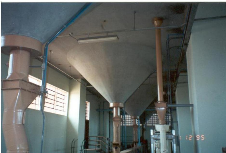
Fig. 3 – Laje de Transição, Cones e Tubulação de Descarga
