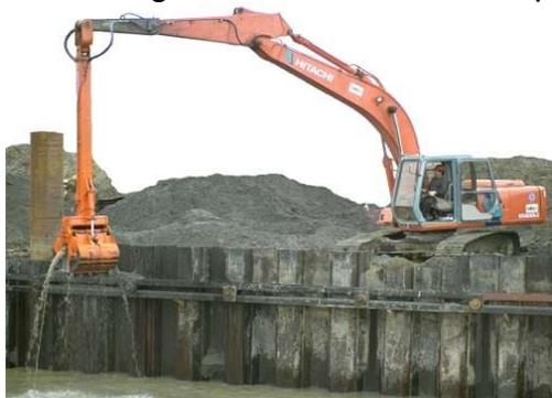
**DOC. N° 6-A:** “DRAGAGEM MARÍTIMA - É a drenagem realizada nos canais de acesso, bacia de evolução e faixa de acostagem do cais com despejo dos solos dragados no próprio mar, geralmente fora da barra. Esta dragagem é realizada através de equipamentos flutuantes, tais como dragas de alcatruzes ou escavadeiras sobre flutuantes, com transporte dos solos através de batelões lameiros, e também por meio de dragas de sucção autotransportadoras que além de executarem o trabalho de remoção
