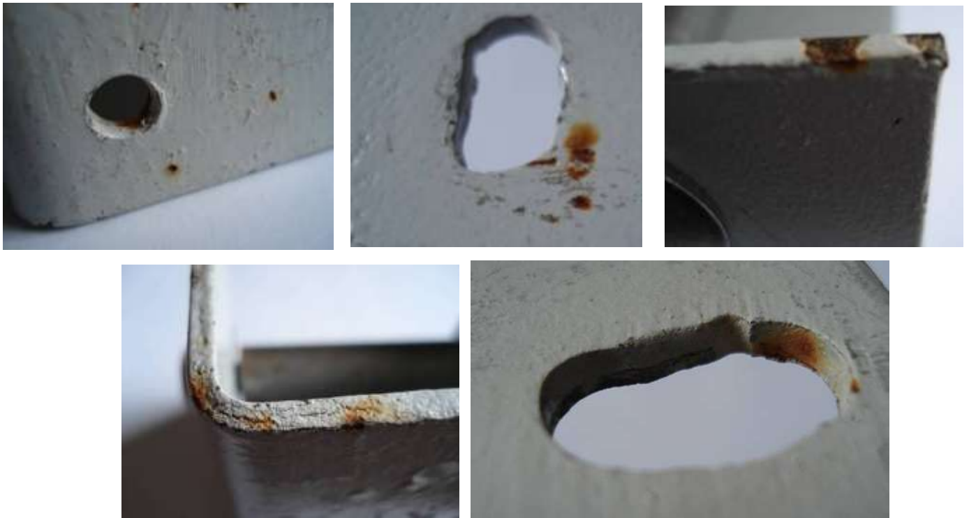
Figura 7 – Pontos de corrosão observados no Perfil “U”.
