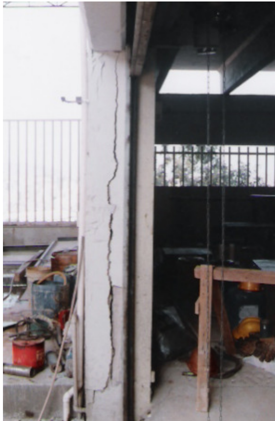
Foto 09 Vista da trinca existente na estrutura do prédio.
