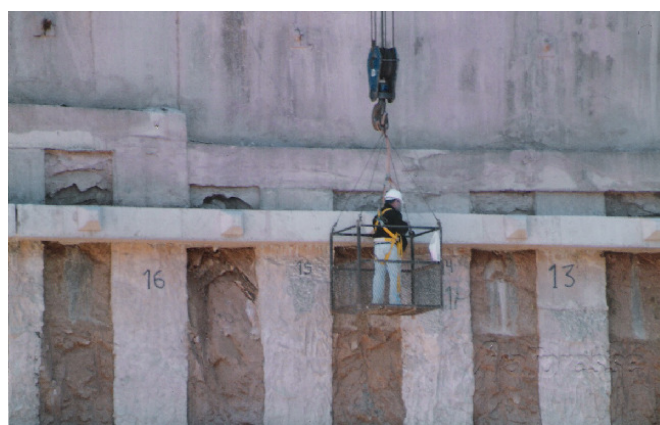
Foto 03 Colocação de 240 refletores nas cabeças dos tirantes.
