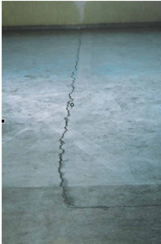
Foto 07 Vista da rachadura no piso do prédio da Empresa Agência de Automóvel
