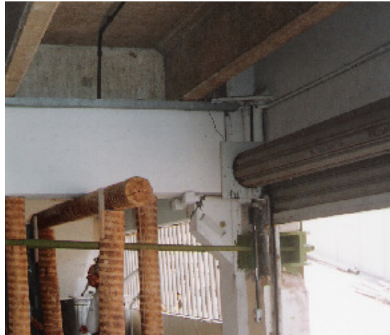
Foto 05 Vista de trincas verticais e horizontais
