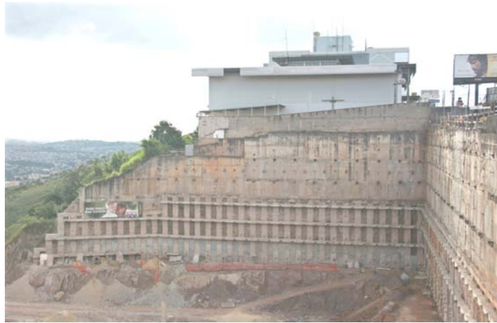
Foto 06 Vista da Cortina Atirantada e parte do prédio da Empresa Agência de Automóvel.
