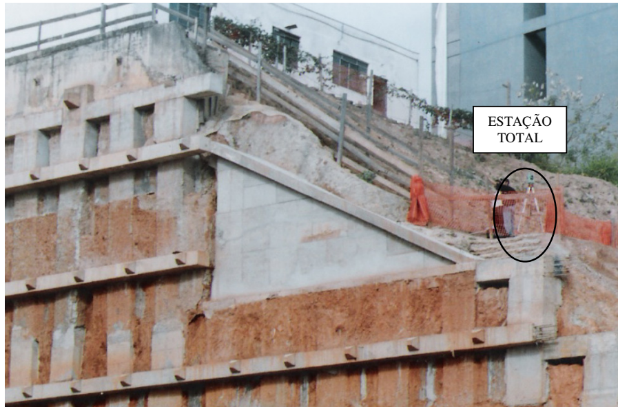
Foto 02 Posicionamento da Base Geodésica
