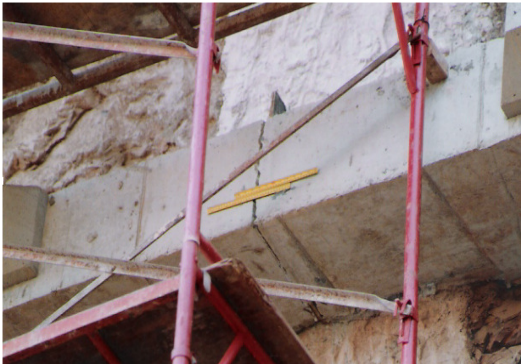
Foto 08 Vista da rachadura no piso do prédio da Agência de Automóvel
