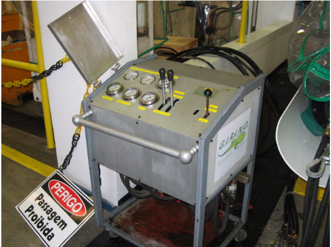
FOTO 04: PAINEL DE COMANDO DO MÓDULO HIDRÁULICO.
