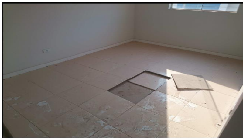
Foto 01: patologia precoce em um edifício residencial. Desplacamento de piso cerâmico. Desempenho inadequado ao uso - quando as manifestações patológicas detectadas prejudicam a segurança e/ou saúde dos usuários
