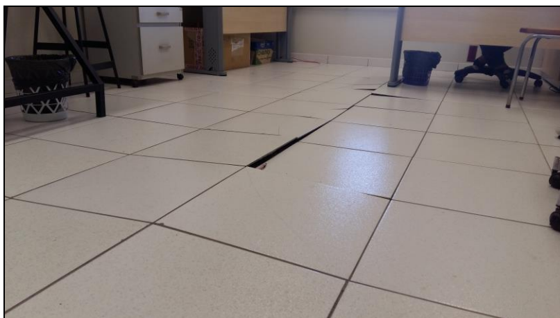
Foto 02: patologia precoce em um edifício público. Deslocamento de piso cerâmico. Desempenho inadequado ao uso - quando as manifestações patológicas detectadas prejudicam a segurança e/ou saúde dos usuários
