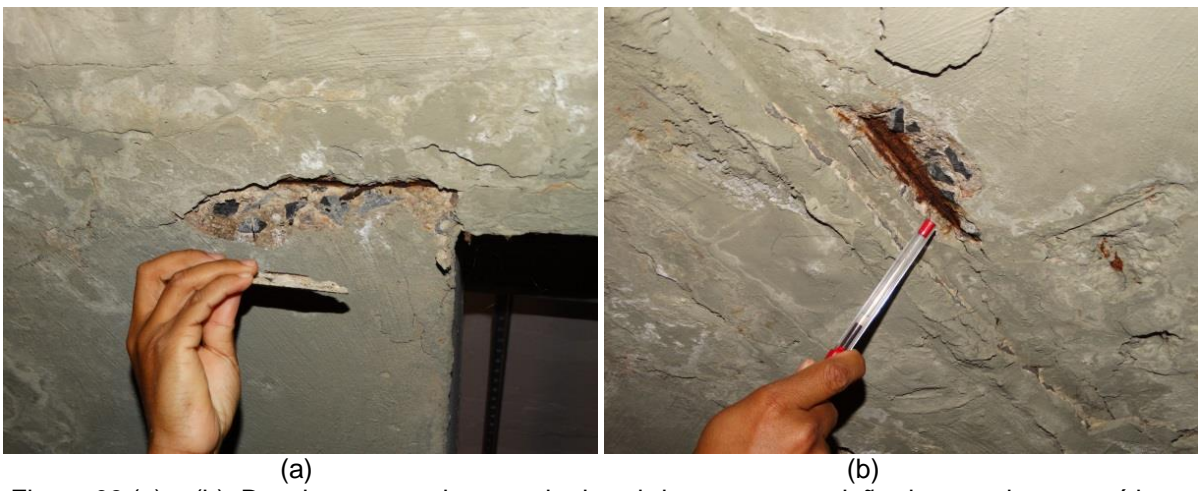
(a) (b) Figura 02 (a) e (b): Deslocamento da camada de cobrimento e exposição de armadura corroída na viga de bordo na vaga 607.
