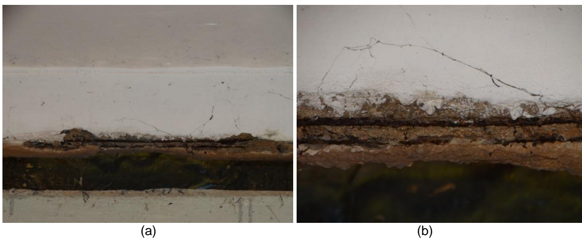
Figura 04: Deslocamento da camada de cobrimento e exposição de armadura corroída. (a) Laje de avanço na vaga 405; (b) Viga de bordo na vaga 405
