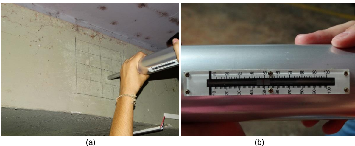
Figura 24: Ensaio de pacometria para detecção da posição da armadura. (a) laje de avanço da vaga 301; (b) Aparelho esclerômetro de Schimidt utilizado no ensaio
