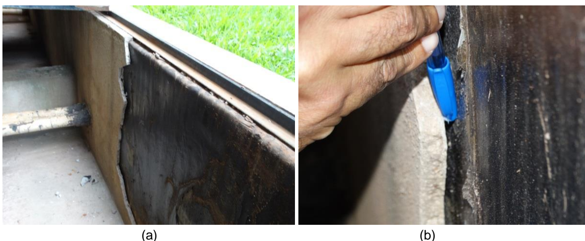
Figura 19 (a) e (b): Deslocamento do revestimento de argamassa aplicado sobre a manta de impermeabilização no poço de ventilação da vaga 503.
