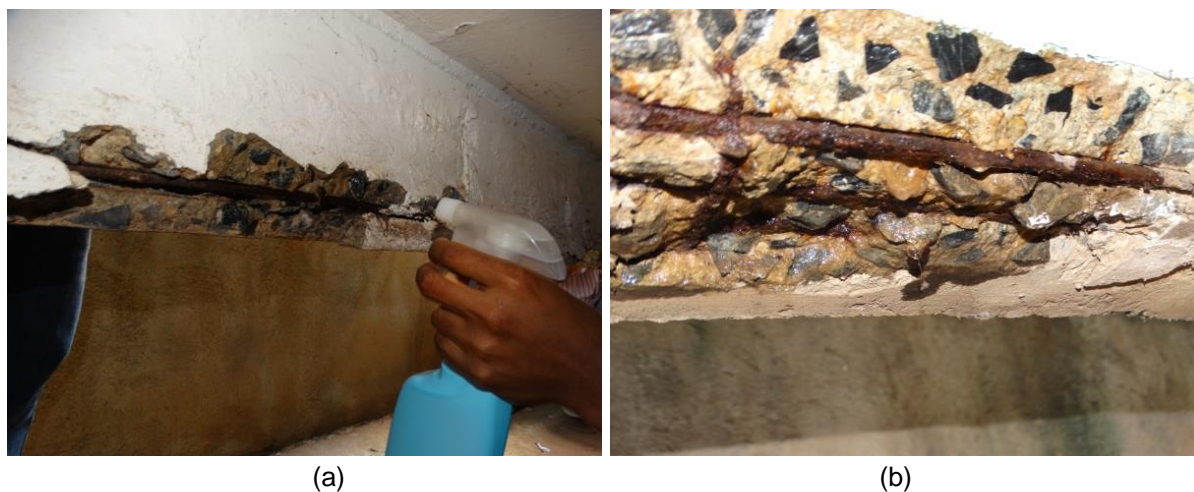
Figura 25: Ensaio de determinação da penetração de frente de carbonatação na viga de bordo da vaga 608; (a) Aspersão de fenolftaleína na superfície de ensaio; (b) Área ensaiada sem alteração na coloração.
