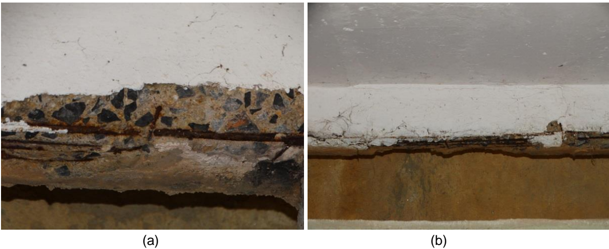
(a) (b) Figura 01: Deslocamento da camada de cobrimento e exposição de armadura corroída. (a) Laje de avanço na vaga 407; (b) Viga de bordo na vaga 406.
