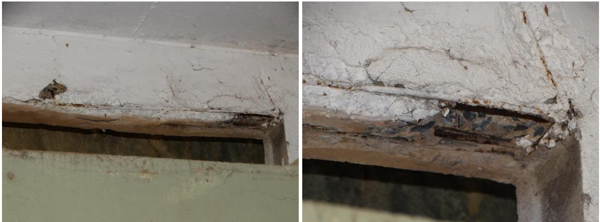
(a) (b) Figura 07 (a) e (b): Deslocamento da camada de cobrimento e exposição de armadura corroída da viga de bordo na vaga 504.
