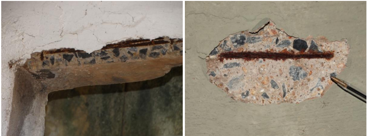
(a) (b) Figura 08: Deslocamento da camada de cobrimento e exposição de armadura corroída. (a) Viga de bordo na vaga 404; (b) Laje de avanço na vaga 404.
