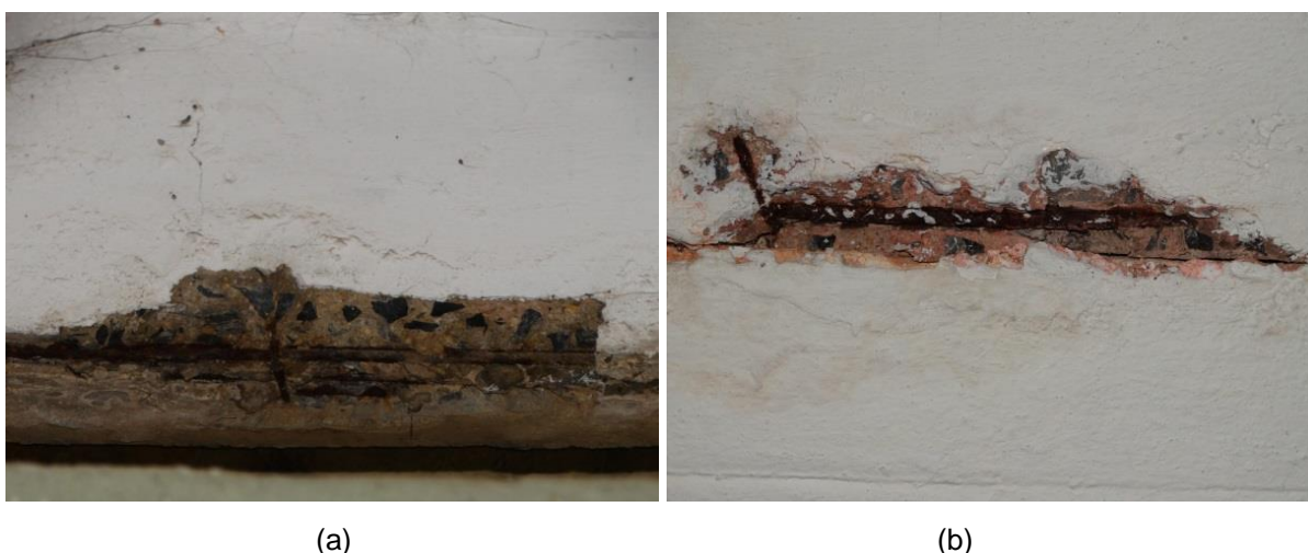
Figura 05 (a) e (b): Deslocamento da camada de cobrimento e exposição de armadura corroída na vaga 305.
