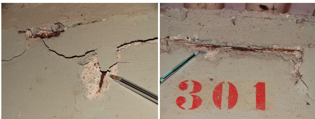
Figura 12: Desplacimento da camada de cobrimento e exposição de armadura corroída. (a) Laje de avanço na vaga 302; (b) Laje de avanço na vaga 301
