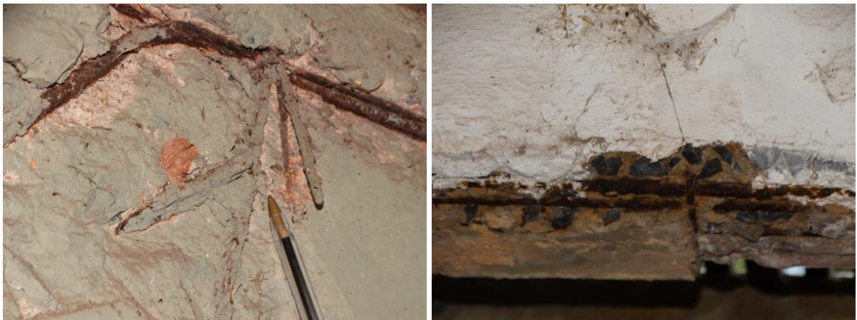
Figura 14 :Desplacamento da camada de cobrimento e exposição de armadura corroída (a) laje de avanço na vaga 401; (b) viga de bordo na vaga 401.
