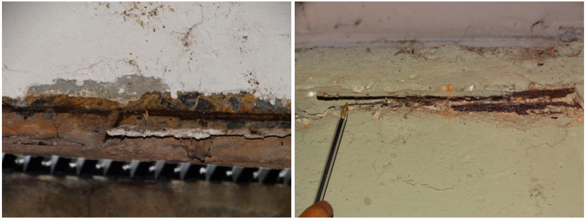
Figura 13 :Desplacamento da camada de cobrimento e exposição de armadura corroída (a) viga de bordo na vaga 401; (b) laje de avanço na vaga 401.
