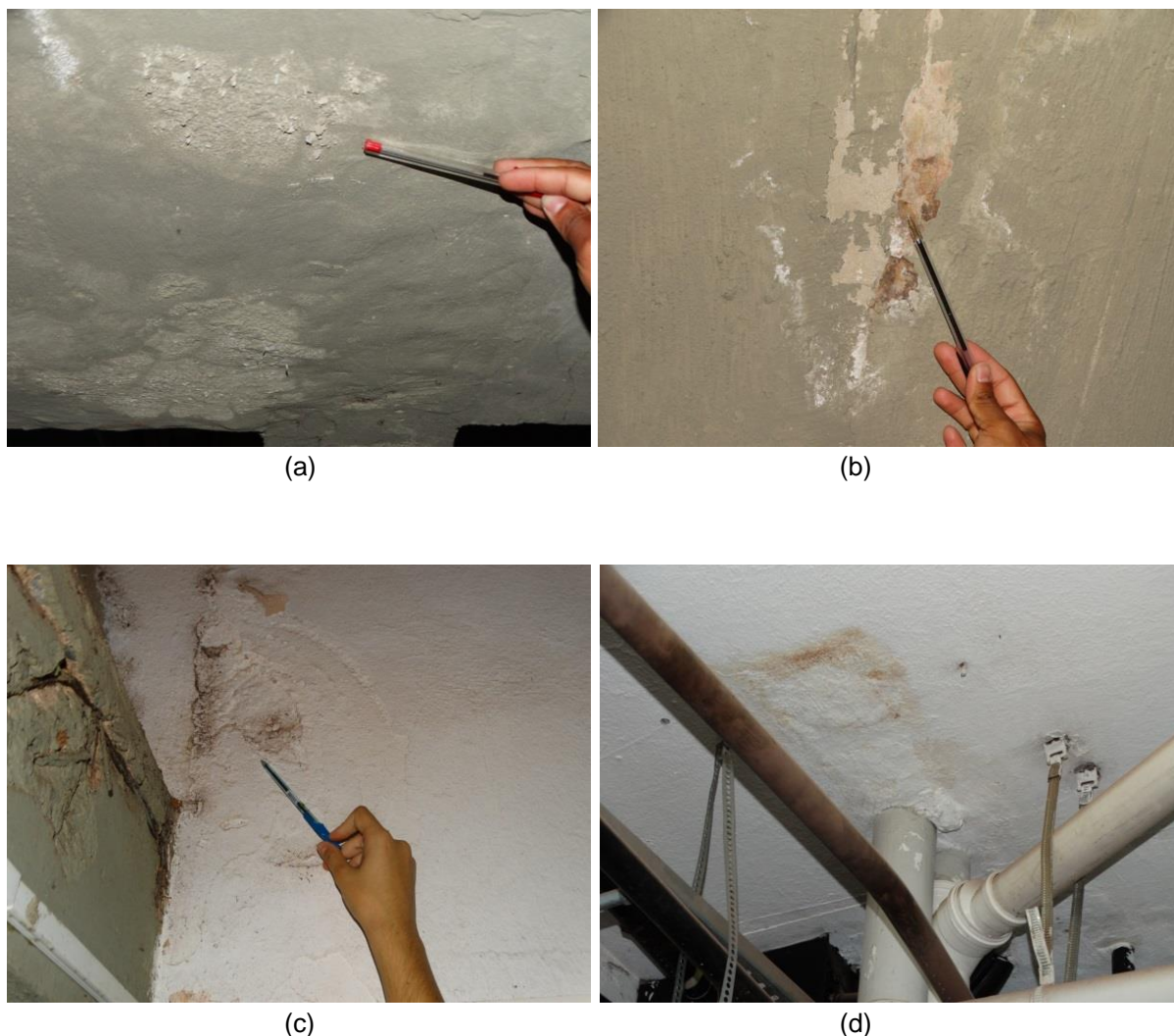
Figura 17: Sinais de infiltração detectados na estrutura do subsolo. (a) laje de avanço da vaga 305; (b) laje de avanço da vaga 608; (c) laje do subsolo na região próxima à saída da garagem (d) laje do subsolo na região próxima à vaga 602
