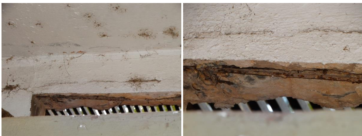
Figura 11 (a) e (b): Desplacimento da camada de cobrimento e exposição de armadura corroída da viga de bordo na vaga 402.
