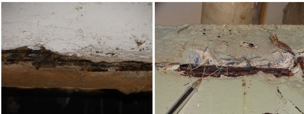
Figura 10: Desplacimento da camada de cobrimento e exposição de armadura corroída. (a) viga de bordo na vaga 503; (b) laje de avanço na vaga 603.
