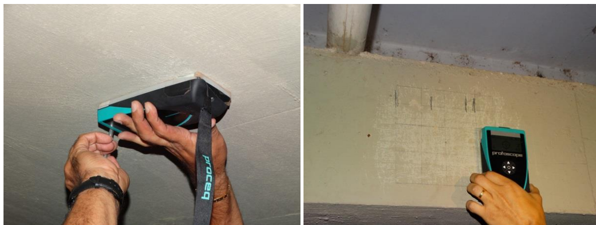
(a) (b) Figura 22 (a) e (b): Ensaio de pacometria para detecção da posição da armadura
