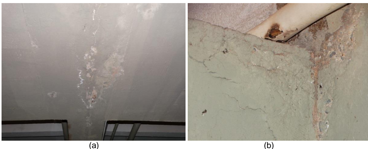
Figura 18 (a) e (b): Sinais de infiltração detectados na laje de avanço entre as vagas 603 e 602
