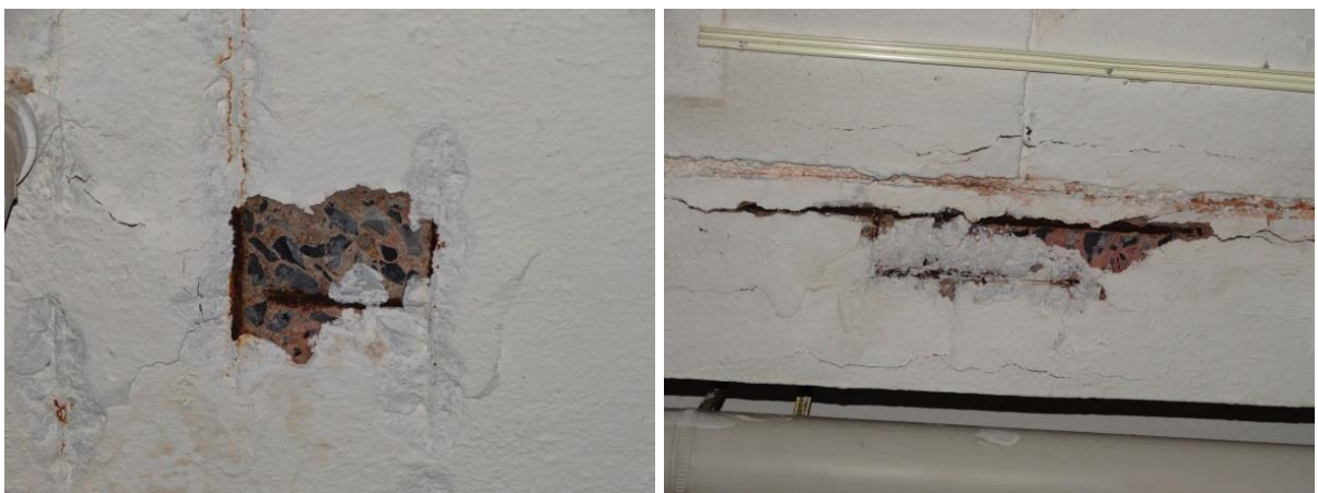
Figura 15 :Desplacamento da camada de cobrimento e exposição de armadura corroída da laje do subsolo (a) região próxima à vaga 201; (b) região entre as vagas 202 e 203.
