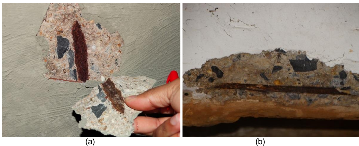
Figura 04: Deslocamento da camada de cobrimento e exposição de armadura corroída. (a) Laje de avanço na vaga 405; (b) Viga de bordo na vaga 405
