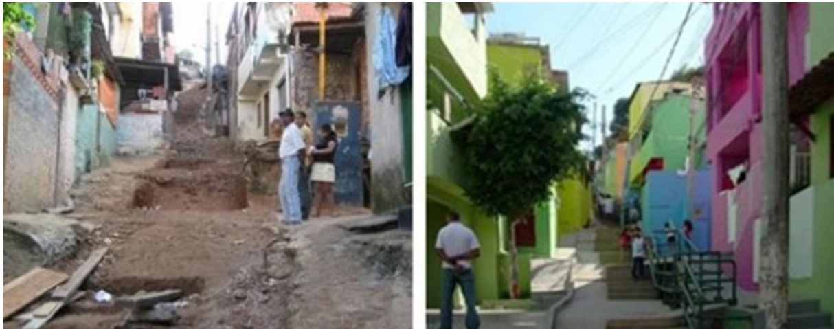
Figura 13 – Obra em escadaria, antes e depois Fonte: SILVA et al, 2016
