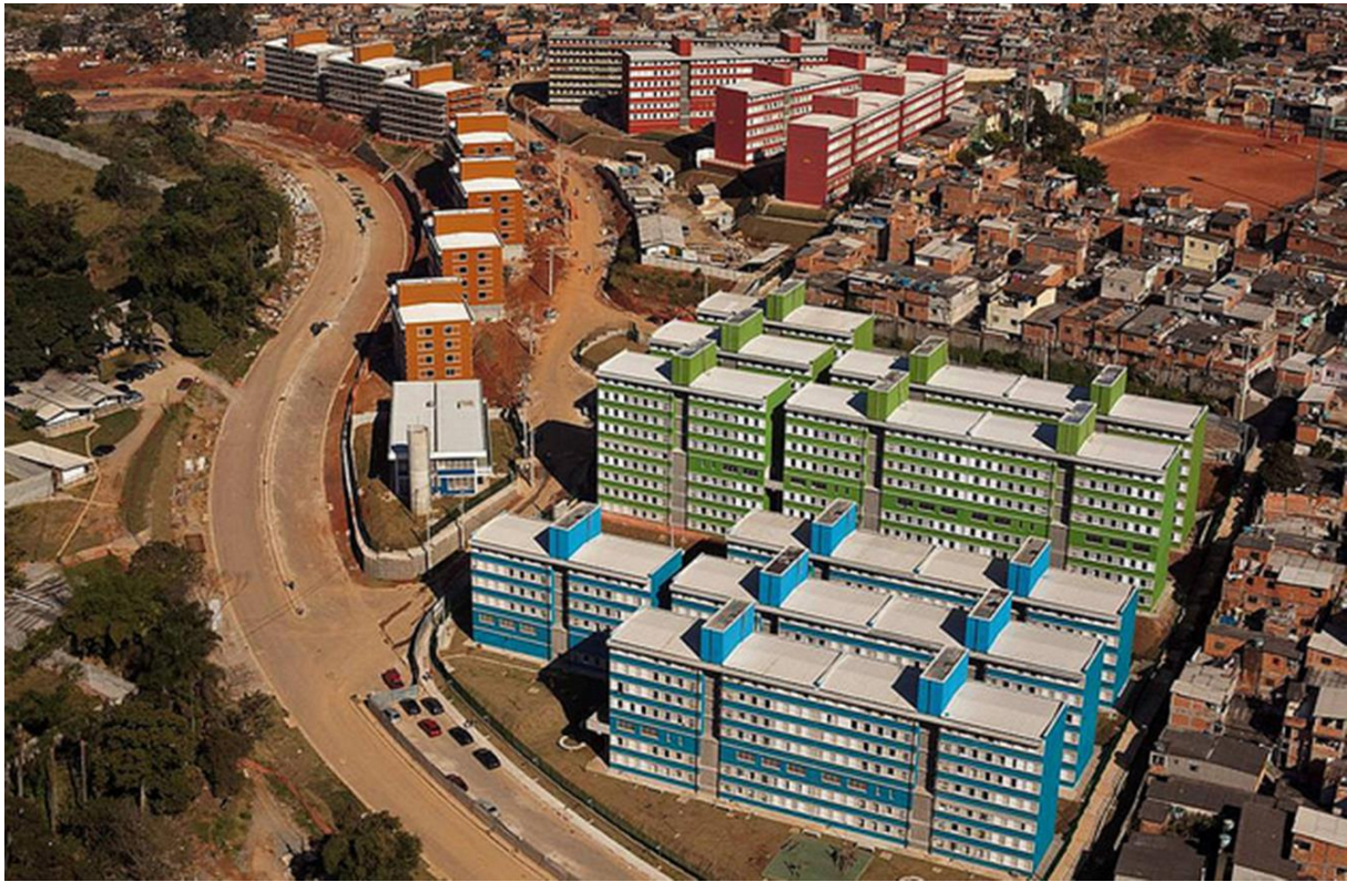
Figura 15 – Construção de conjuntos habitacionais ao longo da Avenida Perimetral (Hebe Camargo)
