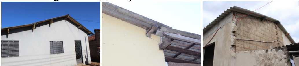
Figura 6 - Modificações realizadas nos telhados.
