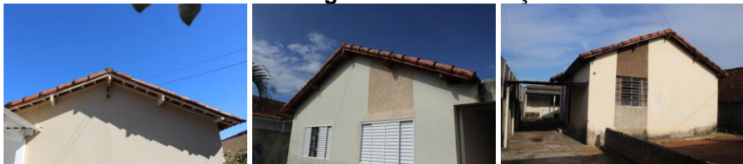
Figura 1 - Telhados originais que puderam ser considerados como bom estado geral de conservação.
