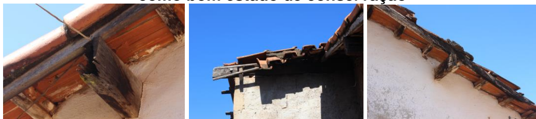
Figura 3 - Telhados originais que não puderam ser considerados como bom estado de conservação
