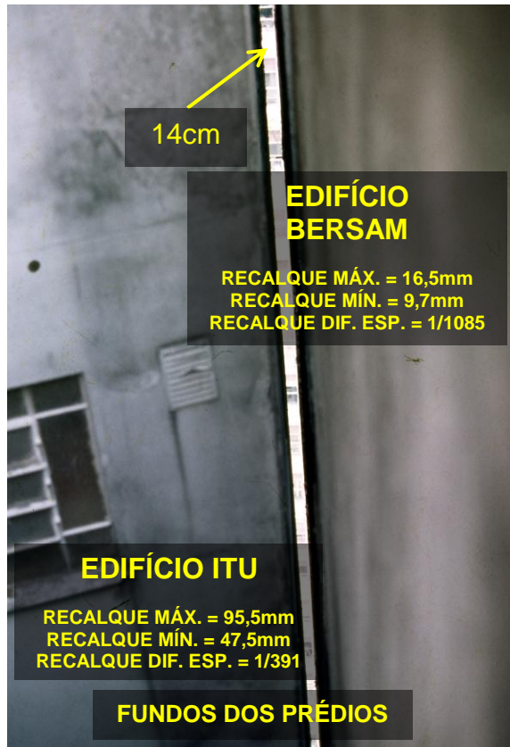
ABERTURA DA JUNTA DE DIVISA DO ED. ITU COM O ED. BERSAM VARIANDO DO TÉRREO AO TOPO DE 3cm A 14cm DEVIDO À INCLINAÇÃO DO ED. ITU
