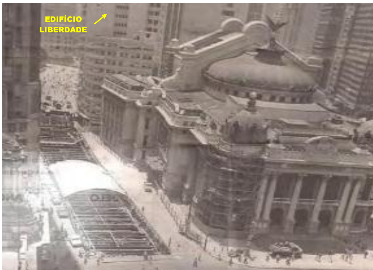
OBRA DO LOTE 05 DO METRÔ-RJ – RUA 13 DE MAIO – ANO DE 1973/1975
