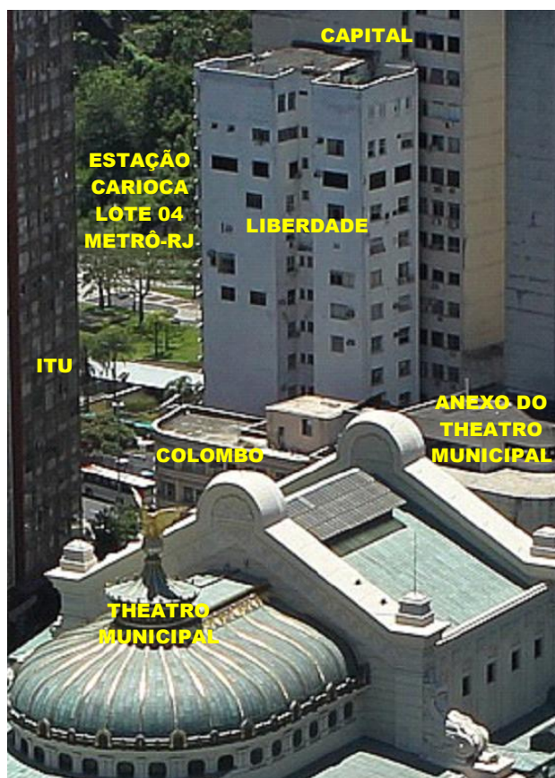
VISTA POSTERIOR – SITUAÇÃO DA ÁREA ANTES DA RUÍNA – 2011
