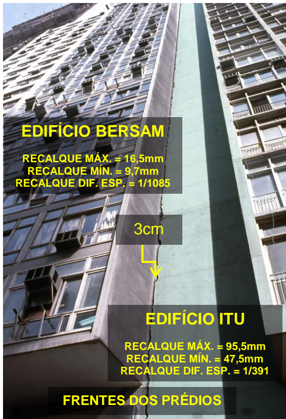
ABERTURA DA JUNTA DE DIVISA DO ED. ITU COM O ED. BERSAM VARIANDO DO TÉRREO AO TOPO DE 3cm A 14cm DEVIDO À INCLINAÇÃO DO ED. ITU
