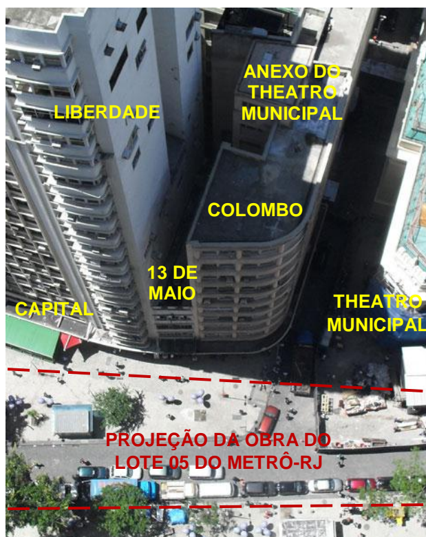
VISTA ANTERIOR – SITUAÇÃO DA ÁREA ANTES DA RUÍNA – 2011
