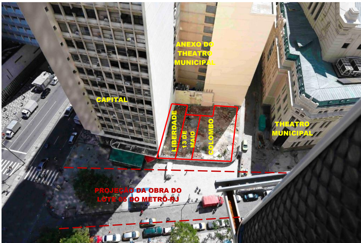
SITUAÇÃO DA ÁREA APÓS A LIMPEZA DA RUÍNA – MEADOS DE 2012
