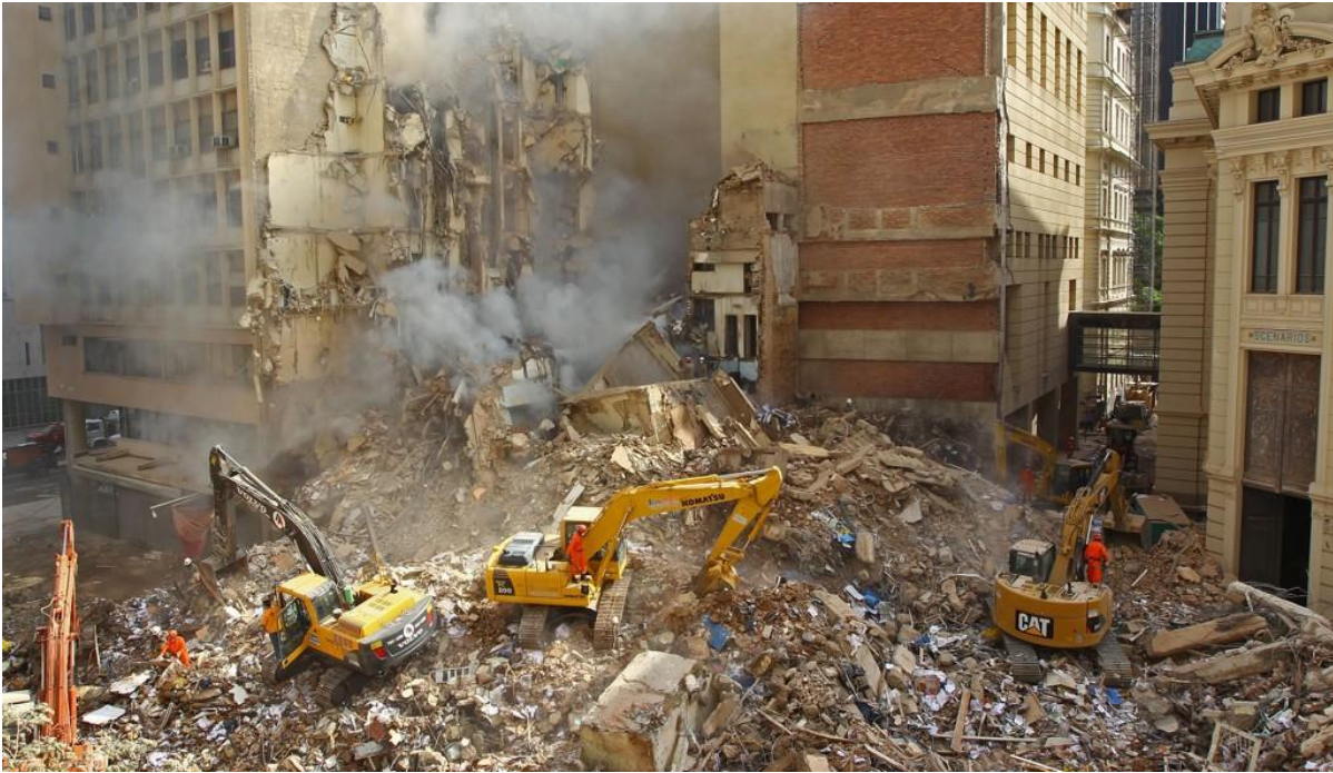
SITUAÇÃO DA ÁREA NA MANHÃ APÓS A NOITE DA RUÍNA – 26/01/2012 FORAM CONTABILIZADAS NO ACIDENTE 23 VÍTIMAS FATAIS 18 CORPOS ENCONTRADOS – CONSTAM 05 CORPOS DESAPARECIDOS
