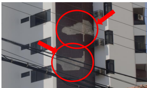
Figura 03: Destacamento do revestimento cerâmico em prédio vizinho ao analisado
