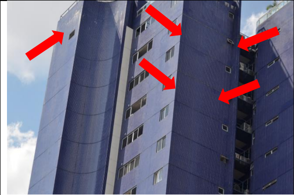
Figura 09: Pontos da fachada com manchas, eflorescências e calcinação. Alguns segmentos já apresentam a manifestação patológica de expansão por umidade, que ocorre por vício de origem na aplicação indevida da argamassa colante no tardo da cerâmica.
