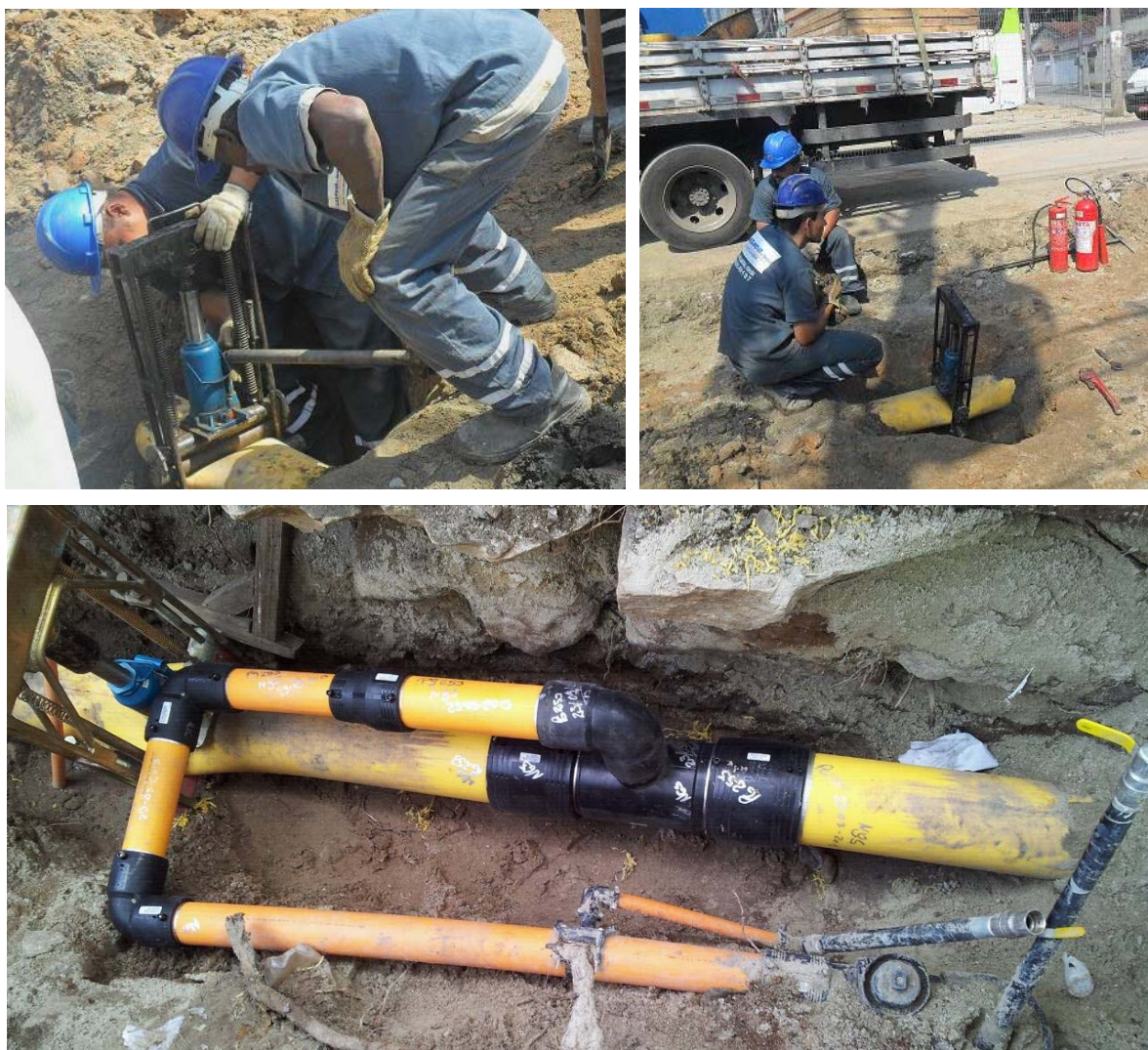
Ilustrações 3, 4 e 5 - Isolamento, com "pinças" de tubulação de gás, para drenagem e reparo de trecho afetado pela entrada de água, em decorrência de instalação incorreta de aquecedor a gás em unidade residencial.
