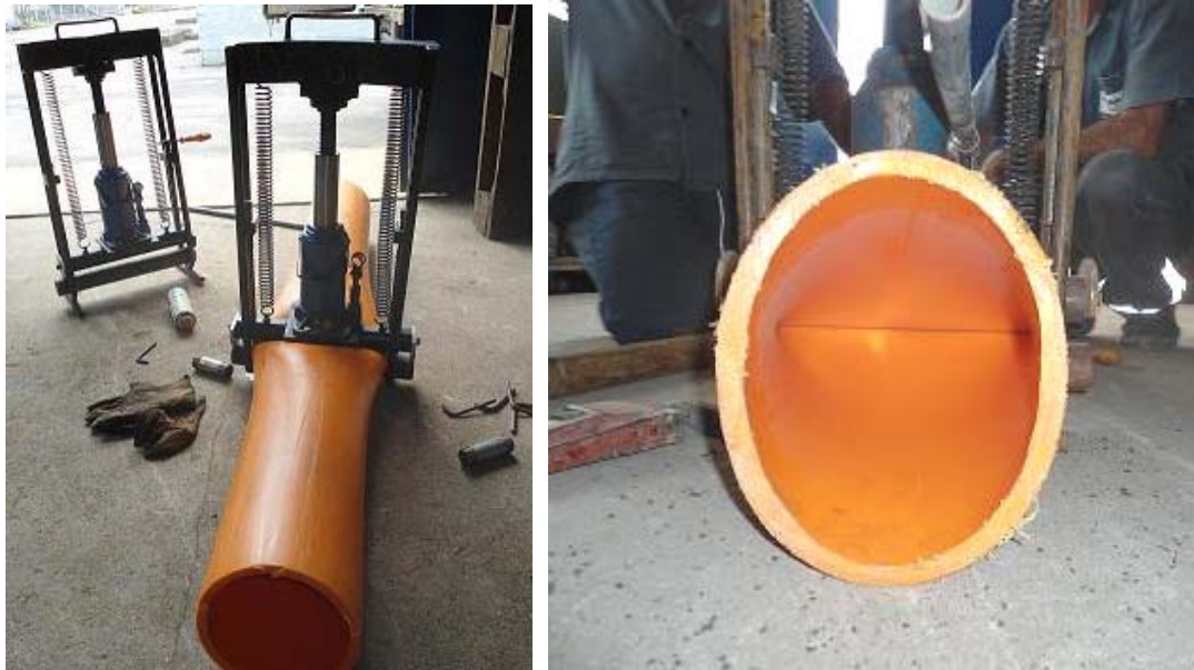
Ilustrações 6 e 7 - "Pinçamento" de tubulação de gás em oficina da Concessionária.
