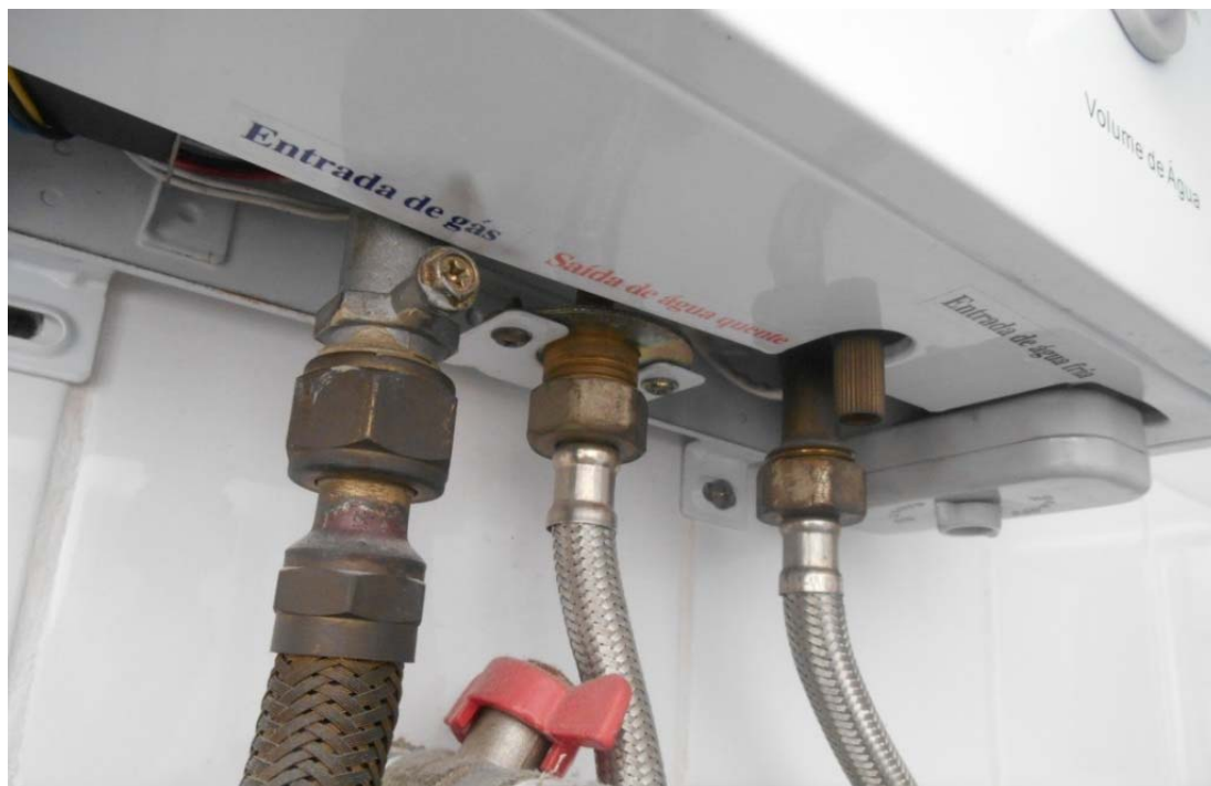
Ilustração 17 - Pontos de água e gás identificados em aquecedor (entrada de gás à esquerda).
