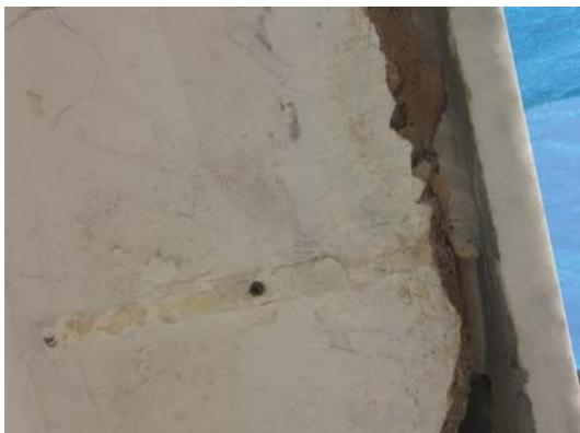
**Foto n° 3: Vista da colocação de pedras com abertura excessiva de junta.**
