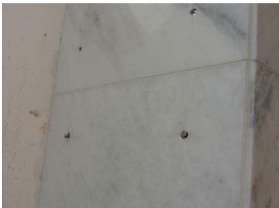
**Foto n° 2: Vista de pedras de mármore sem parafuso e alguns indevidamente colocados.**
