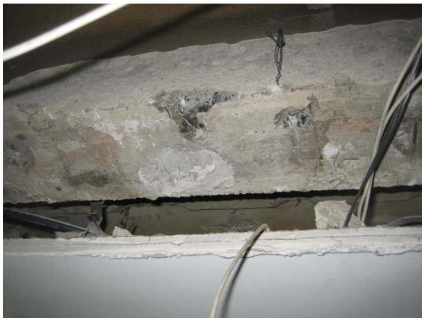
Foto nº 4: Vista da viga a ser reforçada
