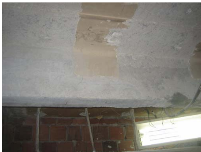
Foto nº 6: Vista da viga a ser reforçada após polimento
