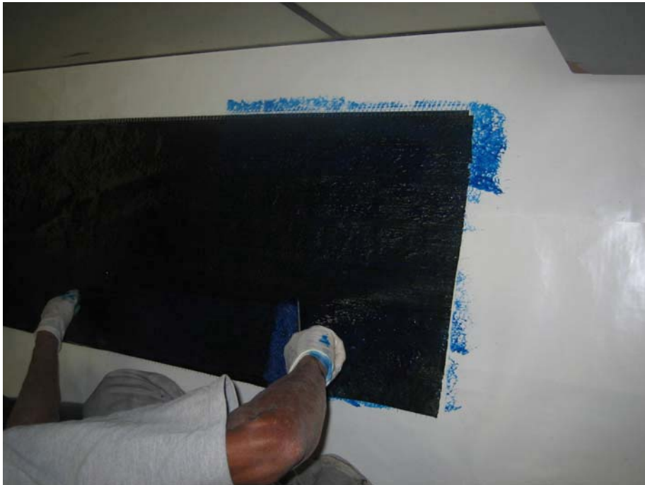
Foto nº 11: Aplicação da cola sobre a fibra
