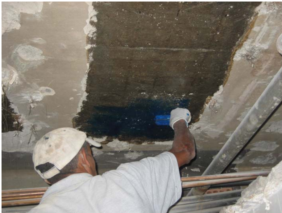
Foto nº 10: Aplicação da cola sobre o concreto polido e já com primer
