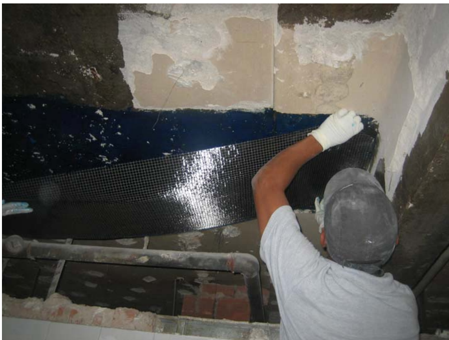
Foto nº 12: Aplicação da fibra no local
