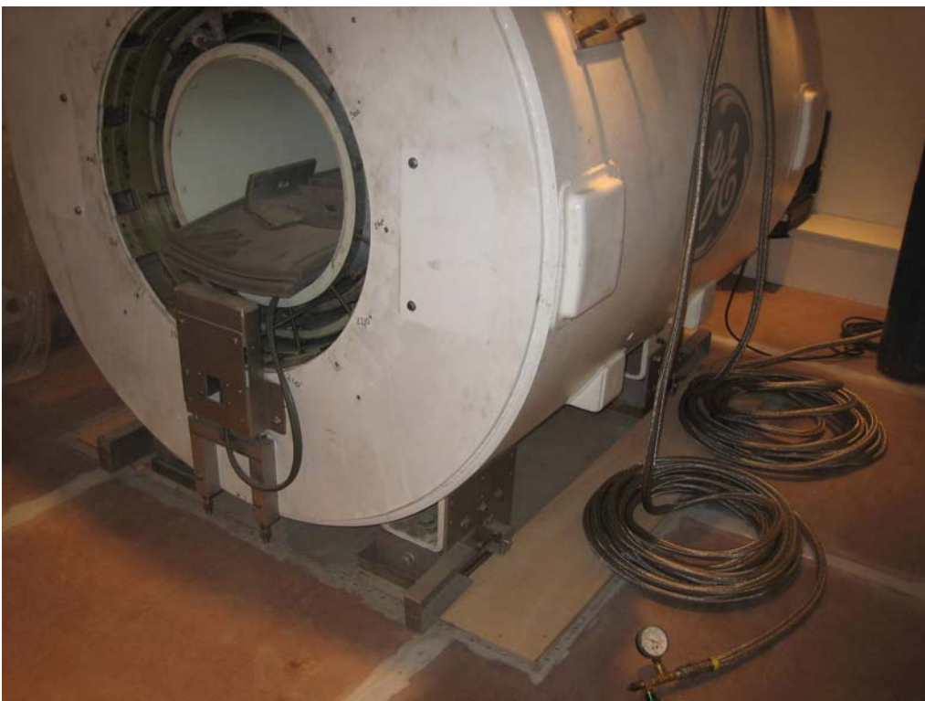
Foto nº 14: Equipamento colocado, em fase de acabamento
