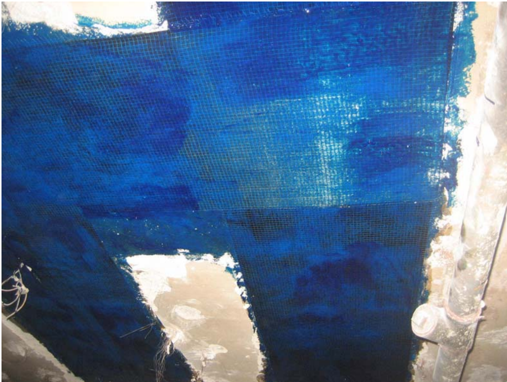
Foto nº 13: Serviço executado com capeamento da fibra de carbono por camada final de cola
