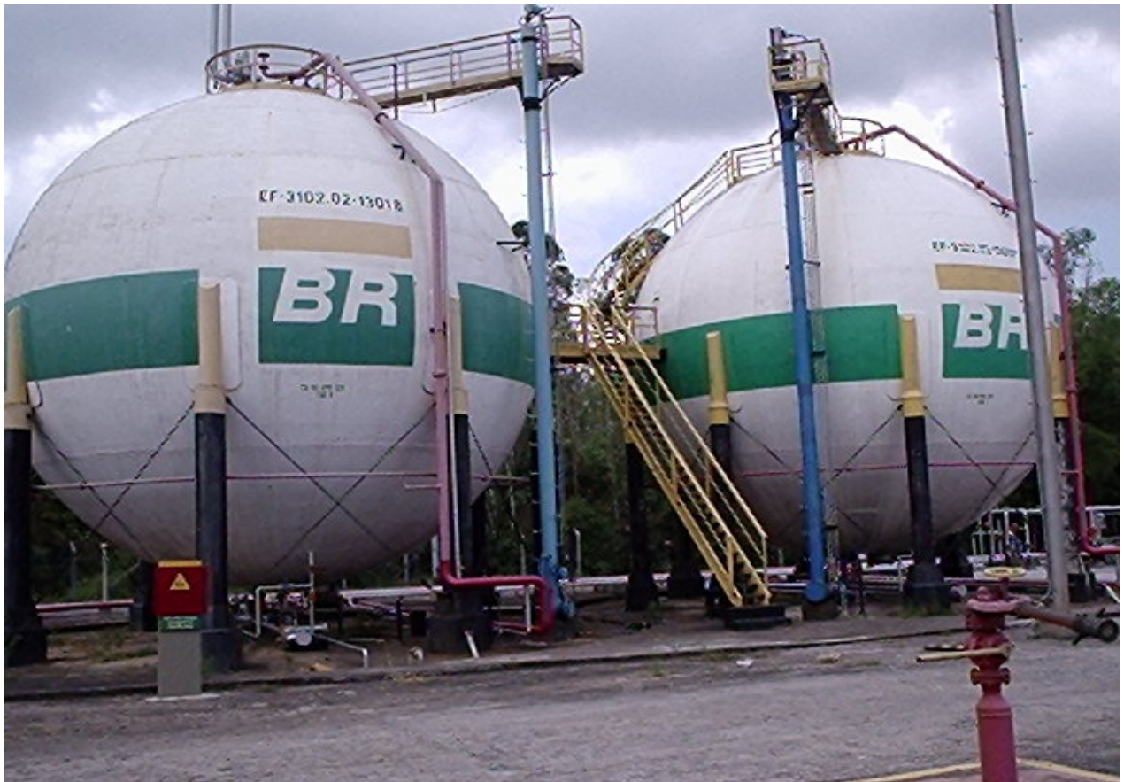
EQUIPAMENTO DE PROCESSO: ESFERAS PARA ARMAZENAMENTO DE GÁS
