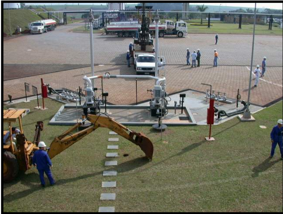
Legenda 09: Início das escavações e exposição das tubulações subterrâneas de óleo diesel.
