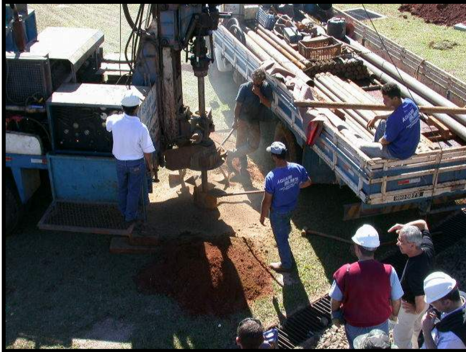
Legenda 05: Início da perfuração dos poços de monitoramento, com coleta de amostras de solo.
