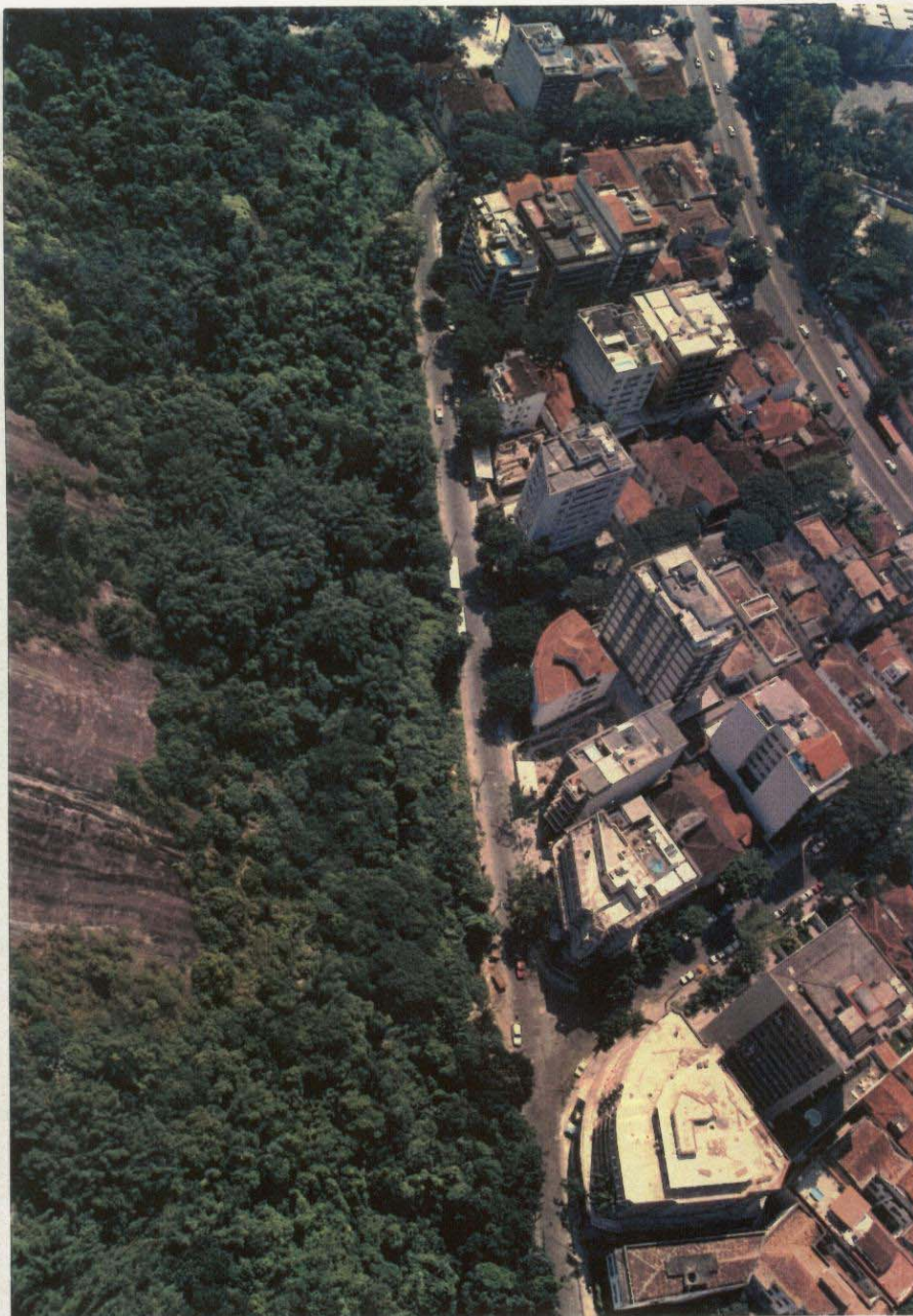
Foto n. 3 - Área de propriedade dos Autores utilizada como bacia de deposição de futuros escorregamentos
