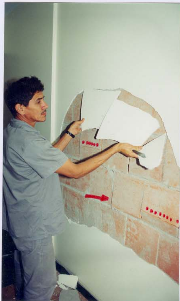
- Detalhes dos serviços iniciais de reparos na alvenaria prejudicada pela deformação estrutural, notando-se o estufamento do revestimento de gesso, bem como as trincas dos blocos cerâmicos rompidos.
