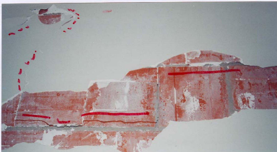
- Vista parcial interna e detalhe de trecho de alvenaria de apartamento contendo anomalias provocados pela deformação da estrutura do Edifício Torre Azul.
