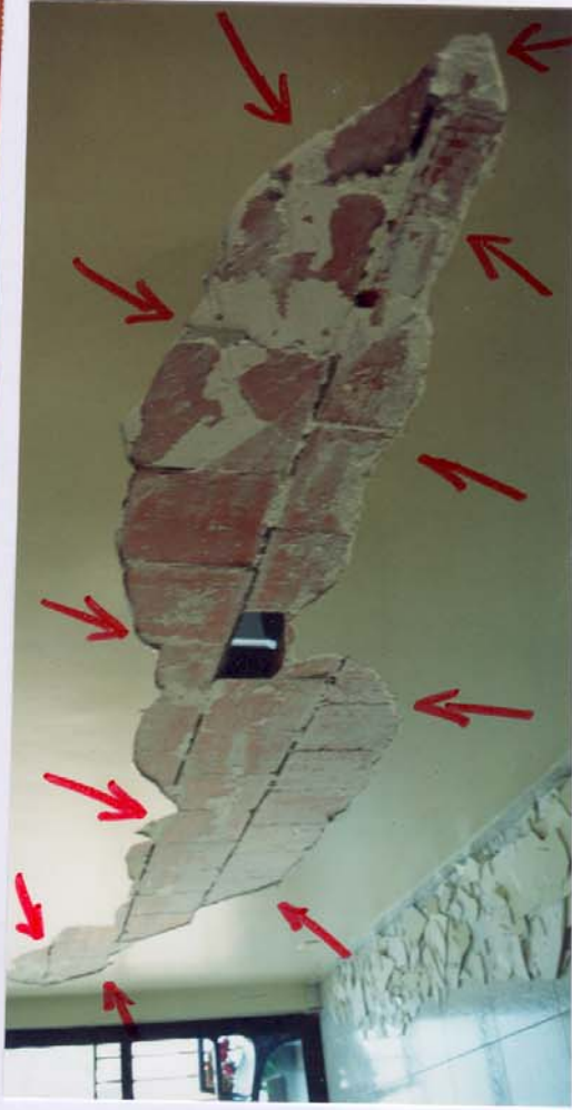
Vistas gerais de trecho de alvenaria rompida devido à deformação estrutural causada por variação térmica e deformação lenta do concreto no Edifício Ilíria.
