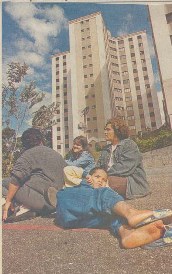
Moradores esperam em frente do prédio interditado em Taboão
