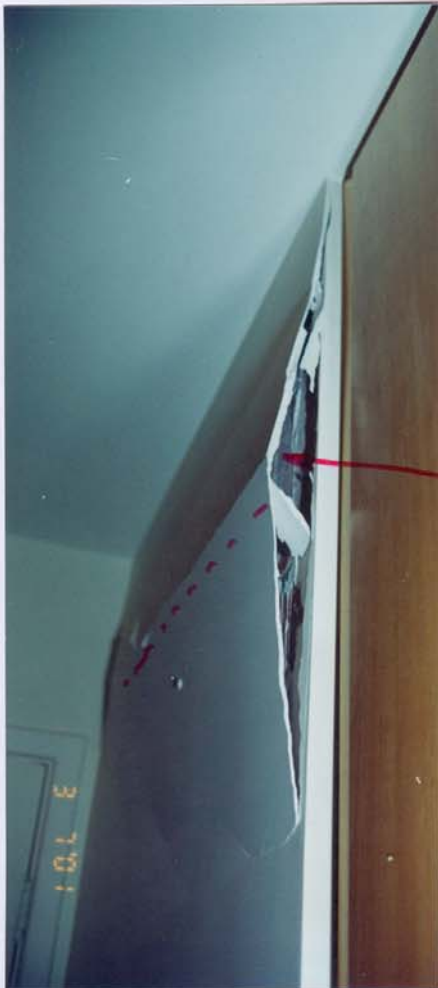
- Detalhes dos trechos danificados de alvenarias do apartamento 61 do Edifício Tulipa, notando-se a direção horizontal das anomalias, a indicar esforços de compressão pela deformação estrutural do prédio.
