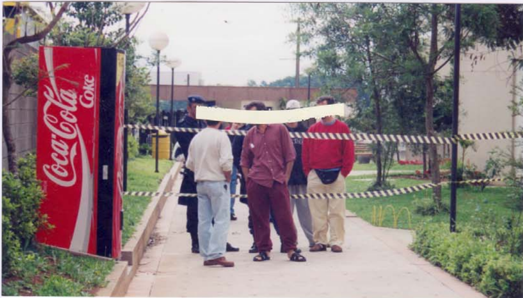
- Vistas do Edifício Torre Azul no município de Taboão da Serra - SP, notando-se faixa de interdição do prédio, no dia 14 de novembro de 1999.
