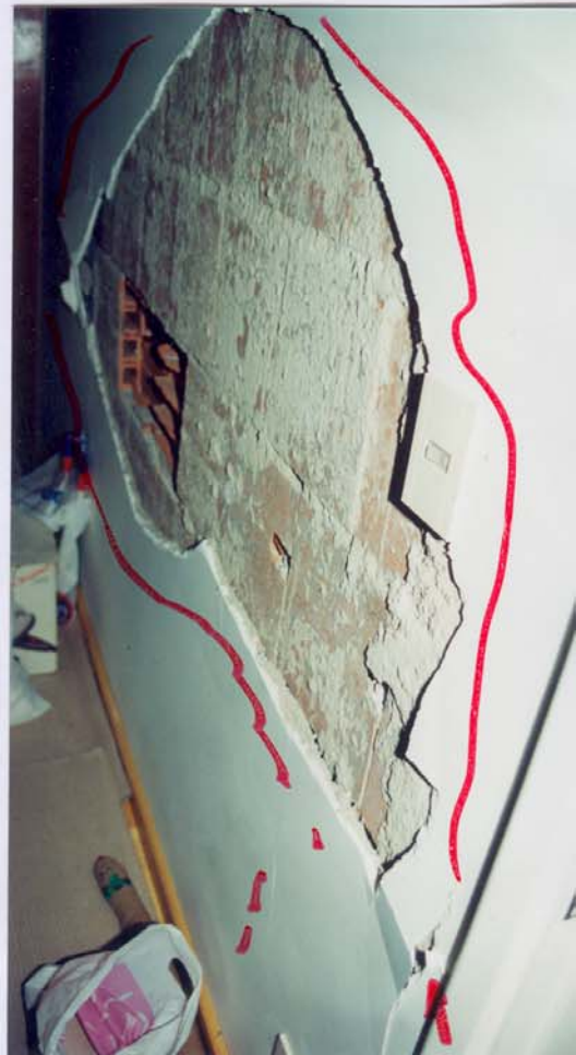
Vistas internas e detalhes de alvenarias do apartamento 61 do Edifício Tulipa, notando-se trechos com rupturas de blocos cerâmicos, estufamentos e deslocamentos do revestimento de gesso.
