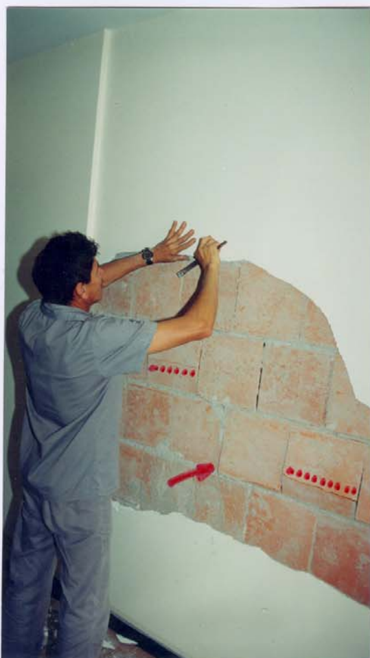
- Detalhes dos serviços iniciais de reparos na alvenaria prejudicada pela deformação estrutural, notando-se o estufamento do revestimento de gesso, bem como as trincas dos blocos cerâmicos rompidos.
