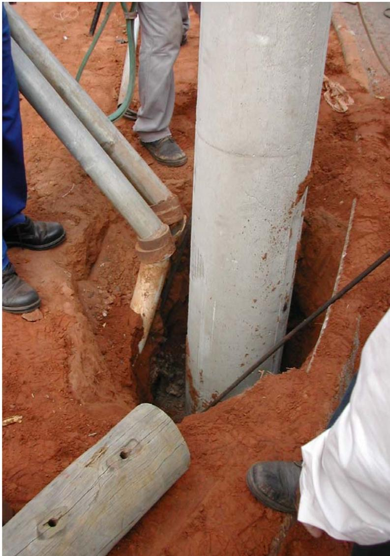
Detalhe das interferências (muflas) junto à base do novo poste instalado
