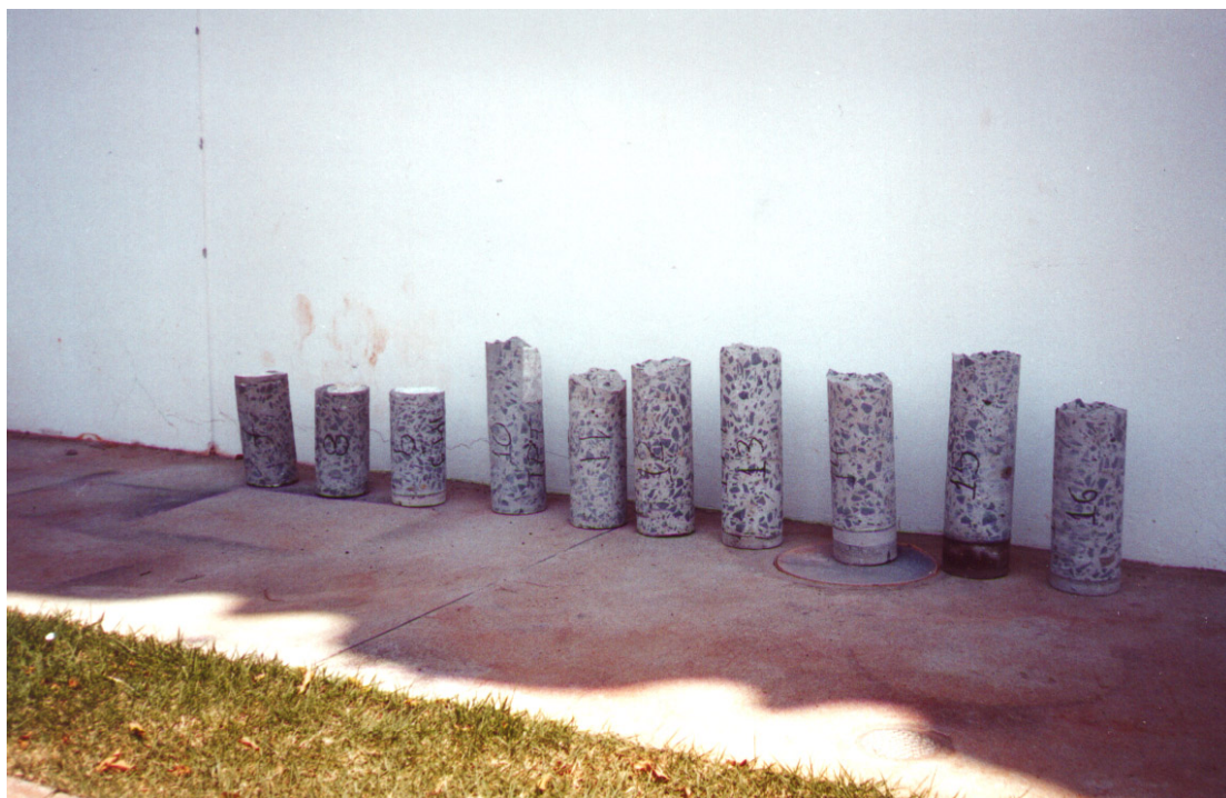
Foto no. 17: amostras extraídas em vigas, sendo visualmente constatada a homogeneidade da concretagem executada.
