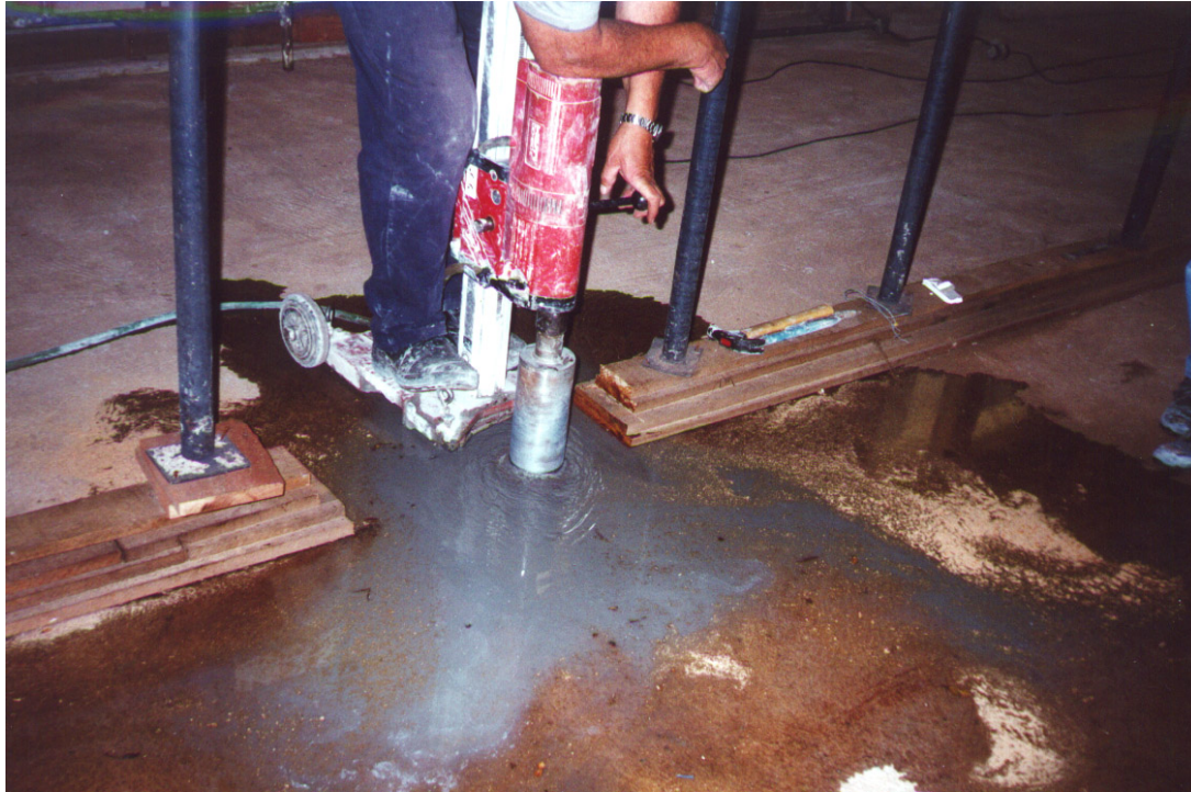
Foto no. 11: extração de corpo de prova na laje de piso do pavimento superior (laboratório 1).
