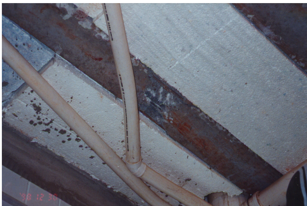
Foto no. 04: escarificação junto ao fundo de vigota treliçada, entre os elementos de EPS da laje de piso, objetivando a conferência de armadura.
