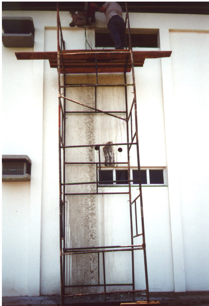
Foto no. 13: extração de corpos de prova de concreto nas vigas de borda longitudinais na cobertura e piso.
