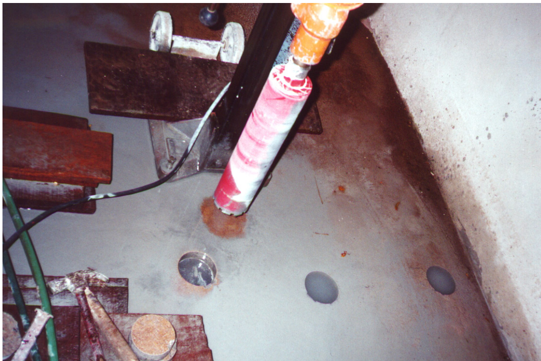
Foto no. 12: extração de corpo de prova na laje de piso do pavimento superior (laboratório 2).
