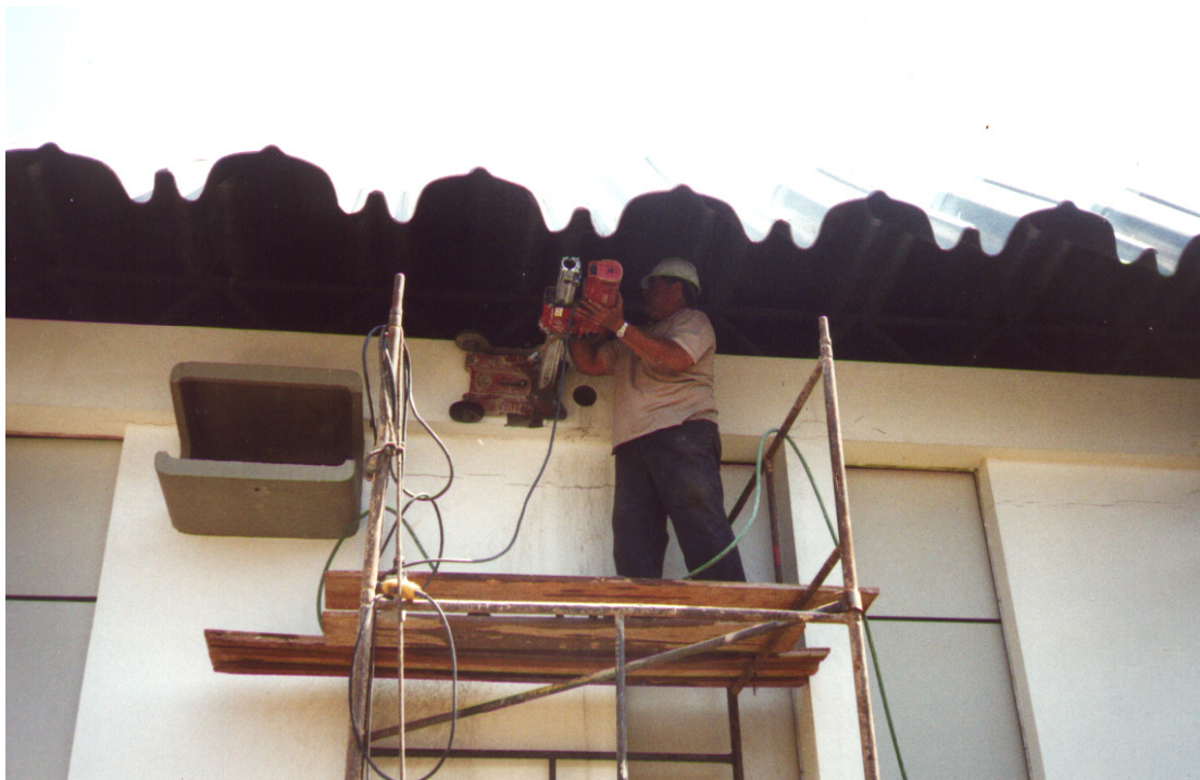
Foto no. 15 e 16: extração de corpos de prova nas vigas de borda de piso e cobertura.
