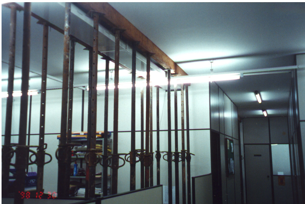
Foto no. 03: início do escoramento metálico da laje de piso no interior do pavimento térreo.
