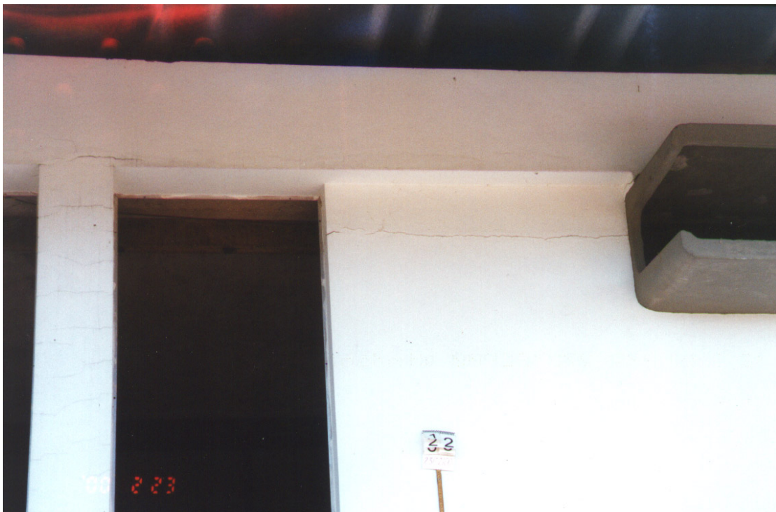
Fotos no. 05 e 06: fissuras em vigas de borda da cobertura decorrentes de esforços rotacionais bem como tracionamento nas faces externas de pilares, combinadas com o deslocamento da alvenaria de fechamento adjacente.
