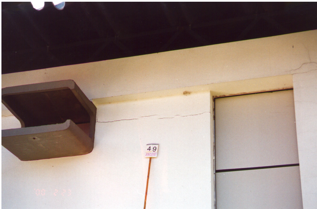
Fotos no. 07 e 08: mesmas ocorrências observadas nas fachadas externas, junto à laje de cobertura.
