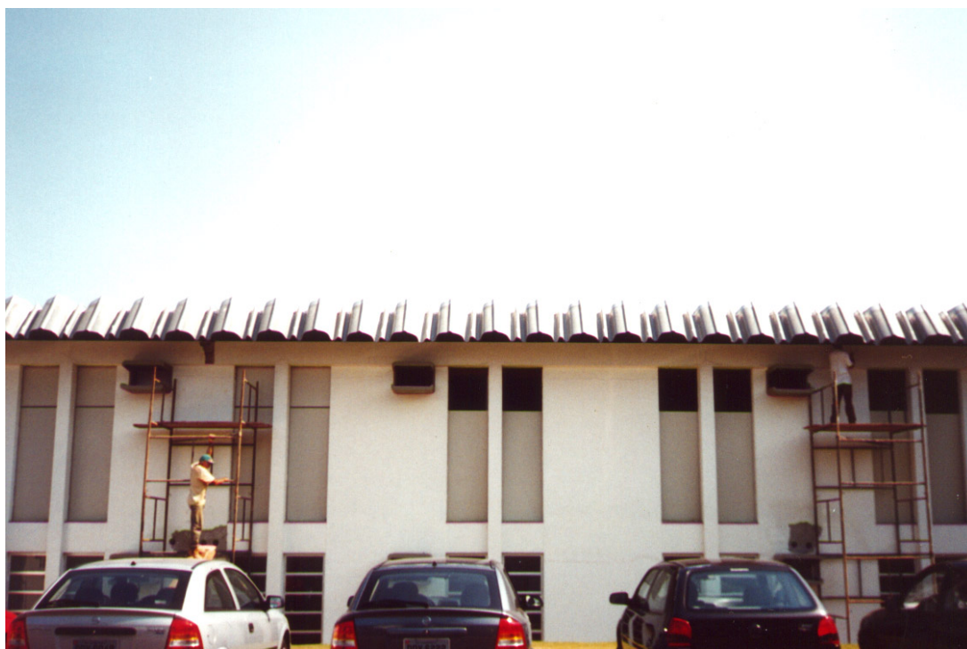
Foto no. 13: extração de corpos de prova de concreto nas vigas de borda longitudinais na cobertura e piso.
