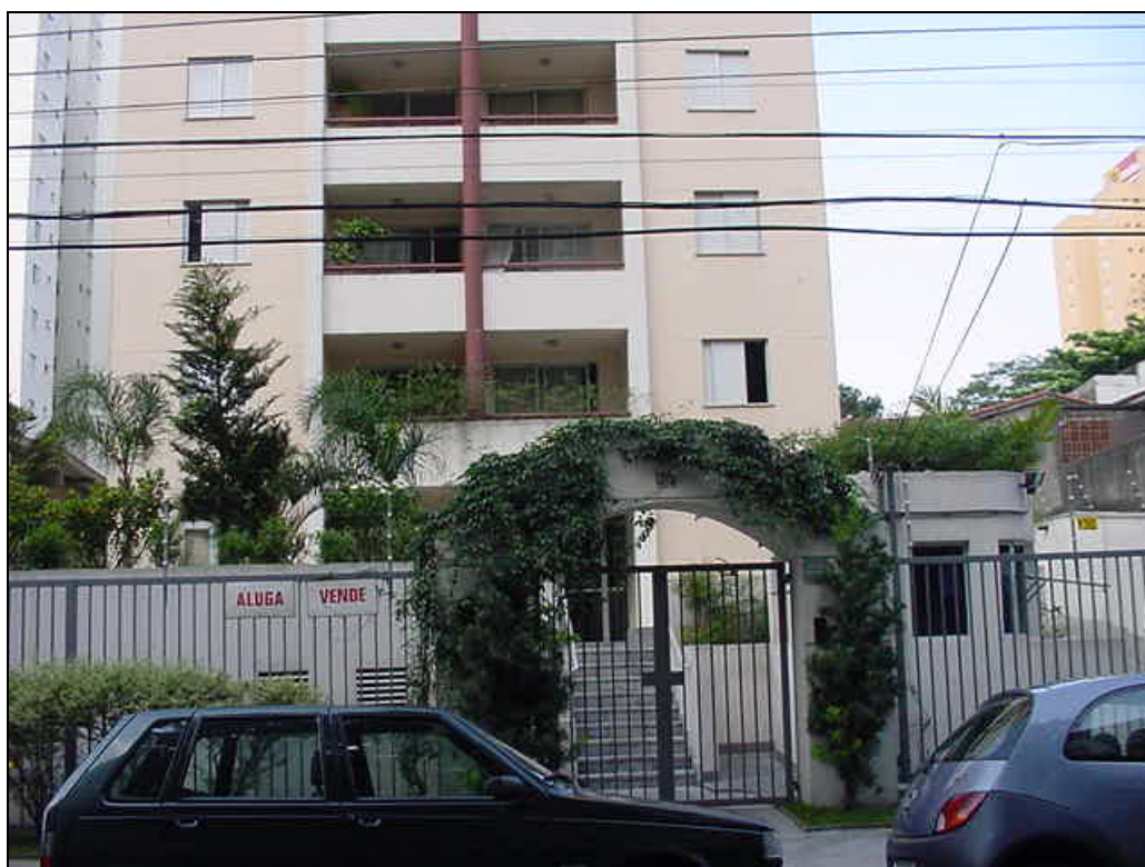
Foto 108: Vista da fachada principal.
