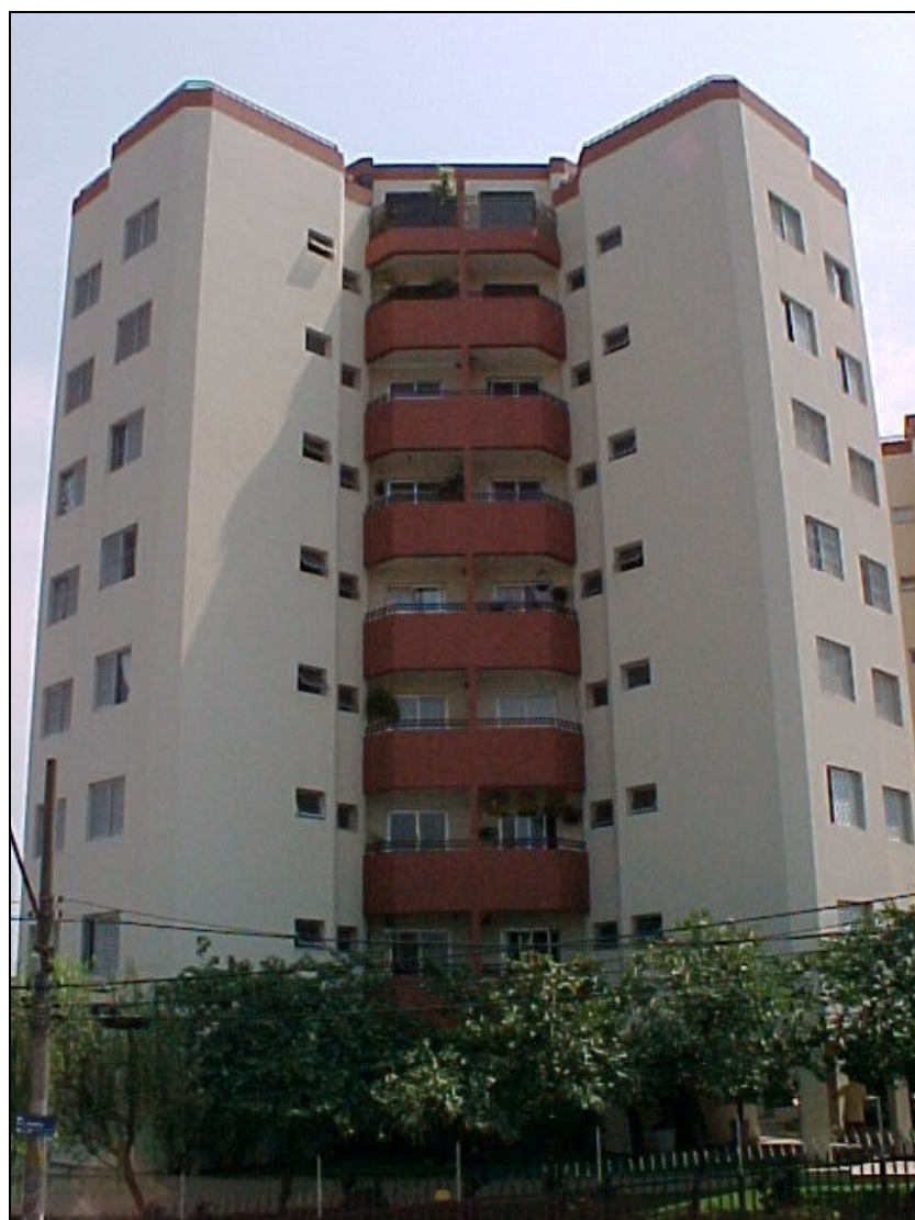
Foto 01: Vista da fachada principal.
