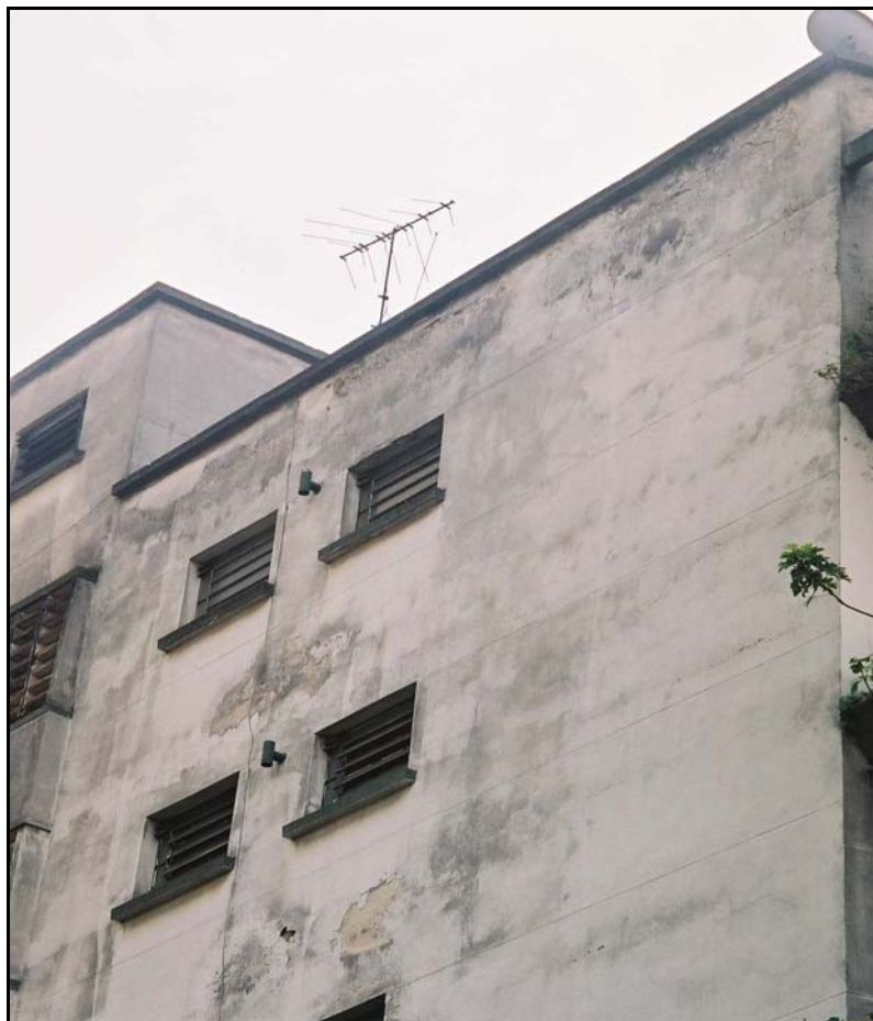
FOTO 16 – Detalhe do edifício com 41 (quarenta e um) anos de vida sem programa de manutenção, com a pintura degradada.
