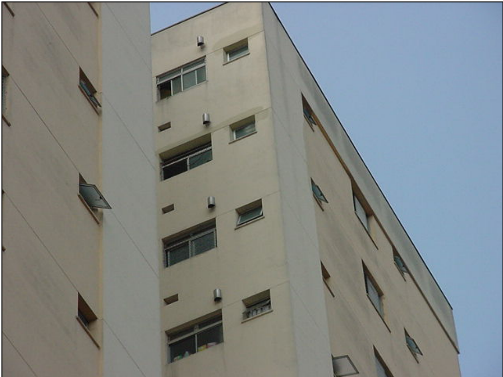
Foto 110: Detalhe da fachada principal.
