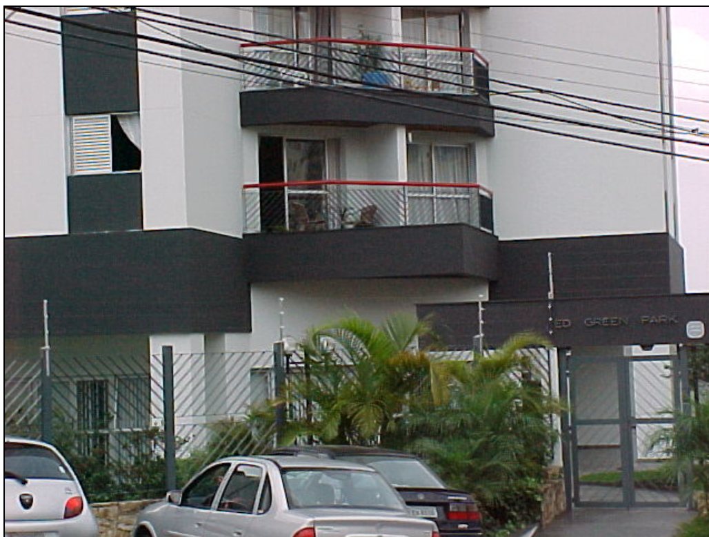
Foto 20: Vista da fachada principal.
