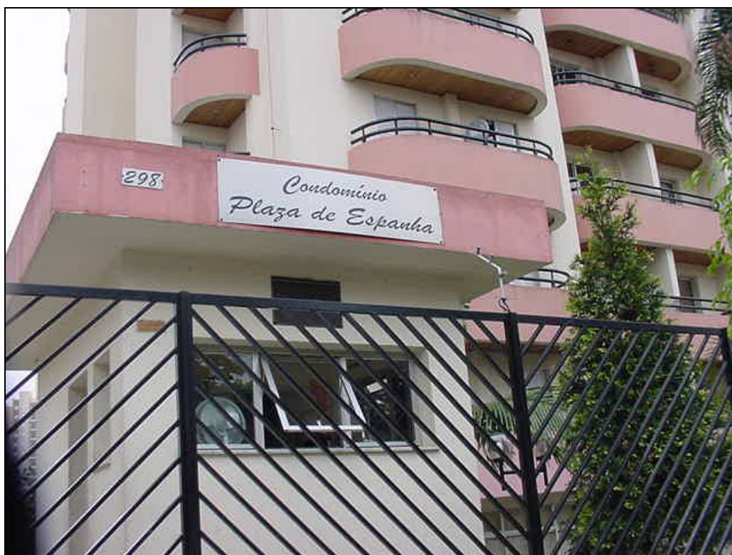
Foto 81: Vista da fachada principal.
