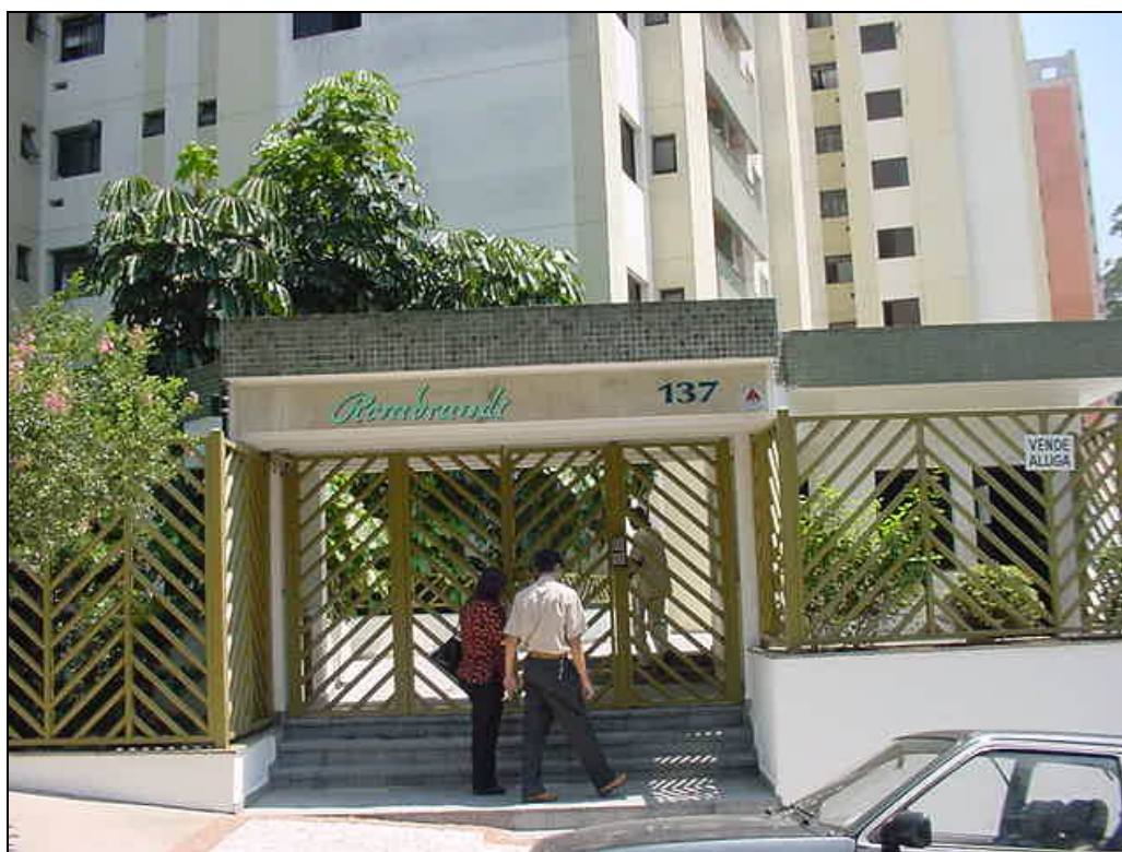
Foto 70: Vista da fachada principal.
