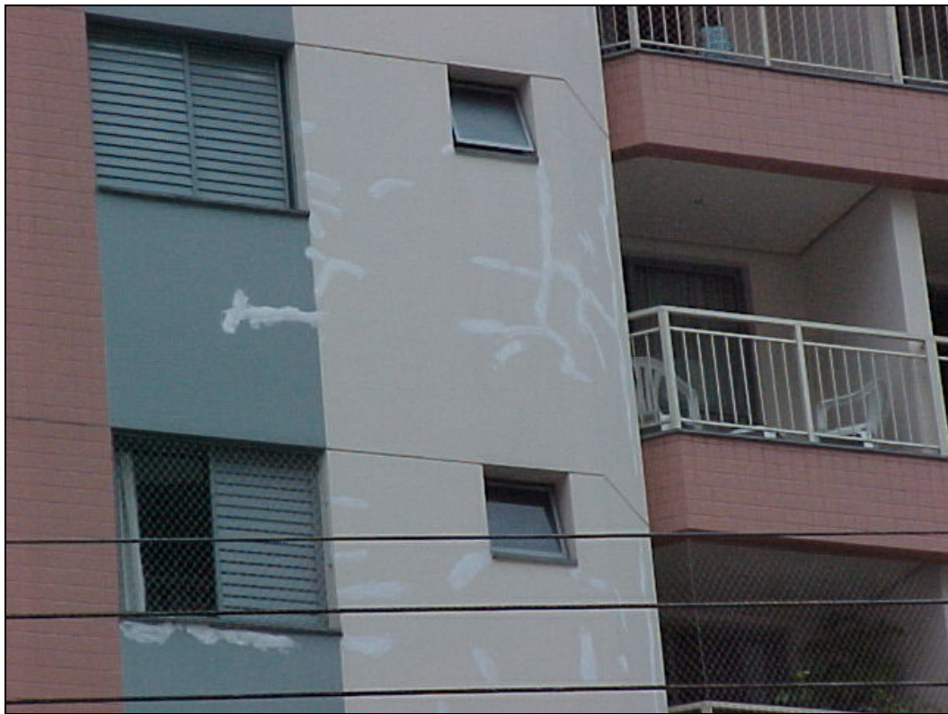
Foto 18: Vista da fachada principal.
