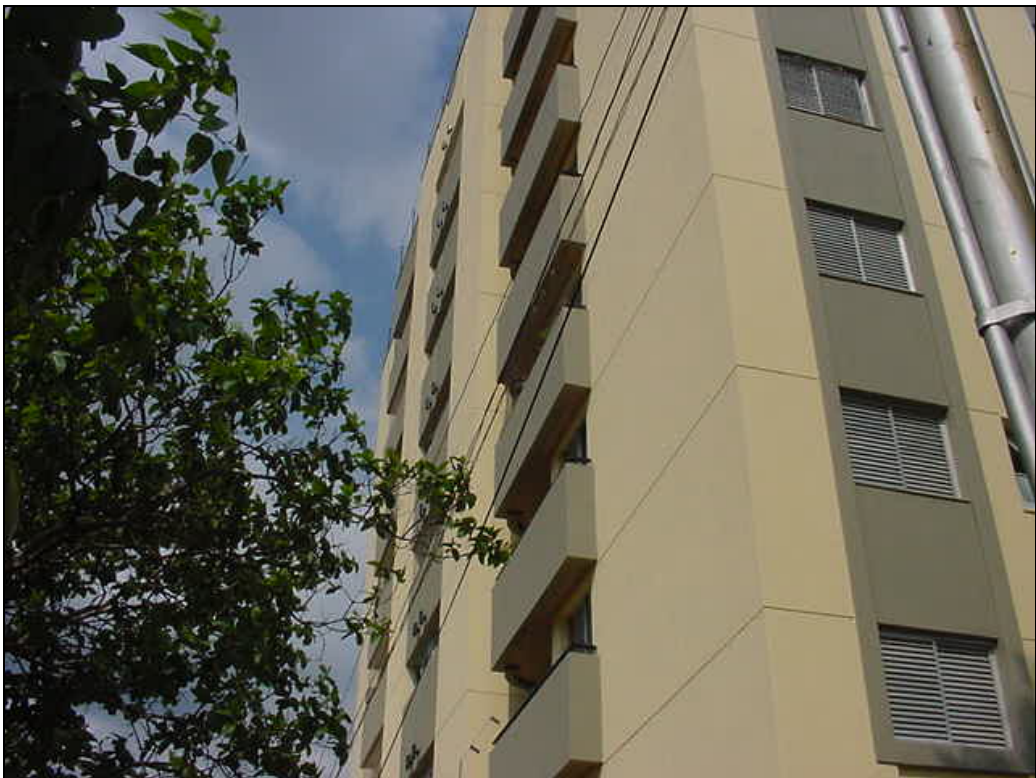
Foto 95: Detalhe da fachada de outro ângulo.
