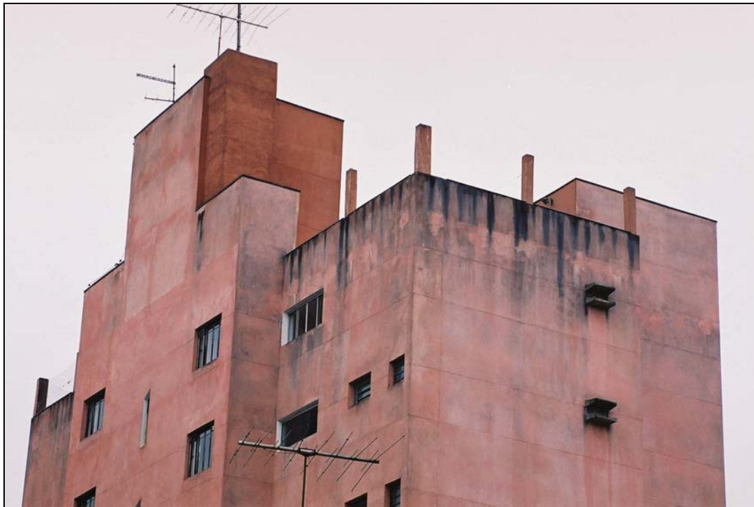
FOTO 14 – Detalhe de um edifício com 09 (nove) anos de vida sem programa de manutenção, com a pintura em processo de degradação.
