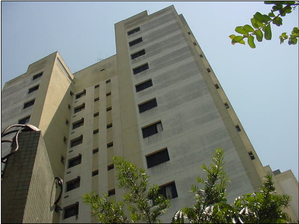
Foto 71: Detalhe da fachada principal.
