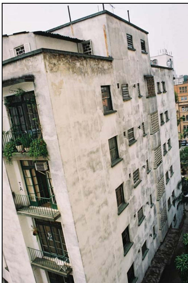
FOTO 09 – Vista de um edifício com 41 (quarenta e um) anos de vida sem programa de manutenção de pintura, onde as necessidades dos usuários não são consideradas satisfeitas.
