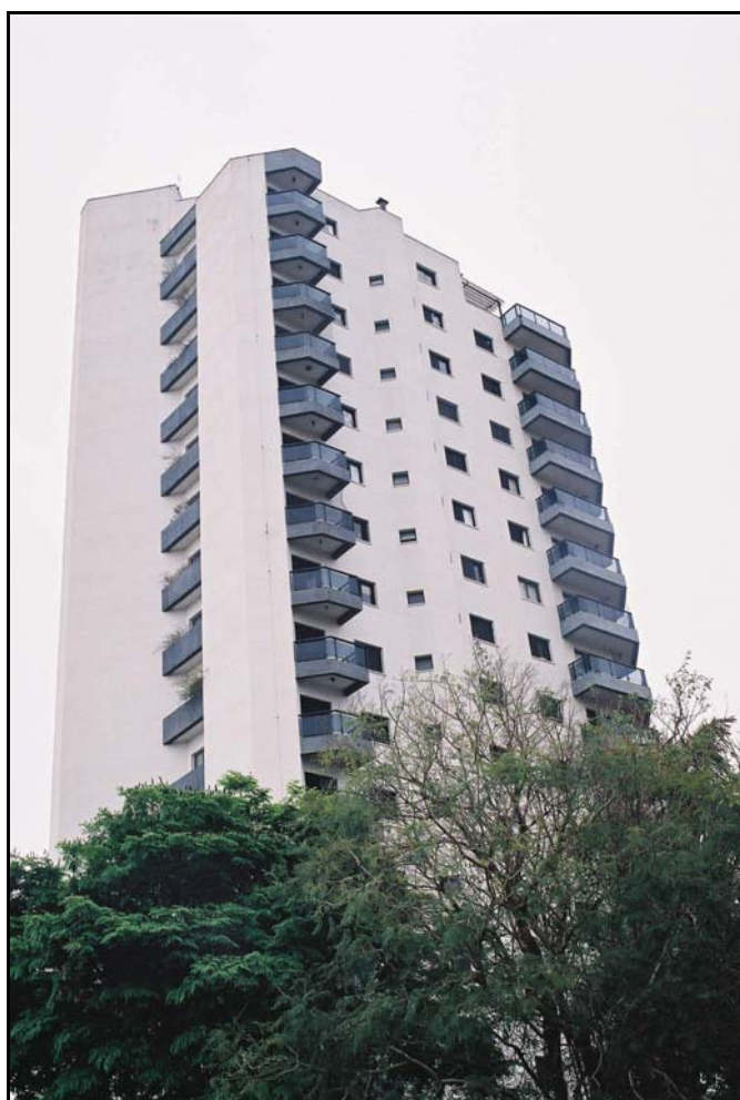
FOTO 11 – Vista de um edifício de 15 (quinze) anos de vida com 01 (uma) repintura realizada aos 07 (sete) anos e programa de manutenção periódica ou preventiva.
