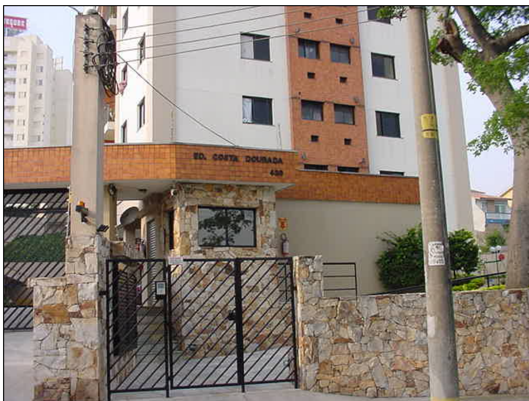
Foto 61: Vista da fachada principal.
