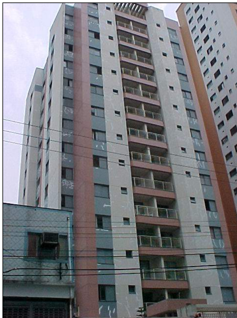
Foto 17: Vista da fachada principal.
