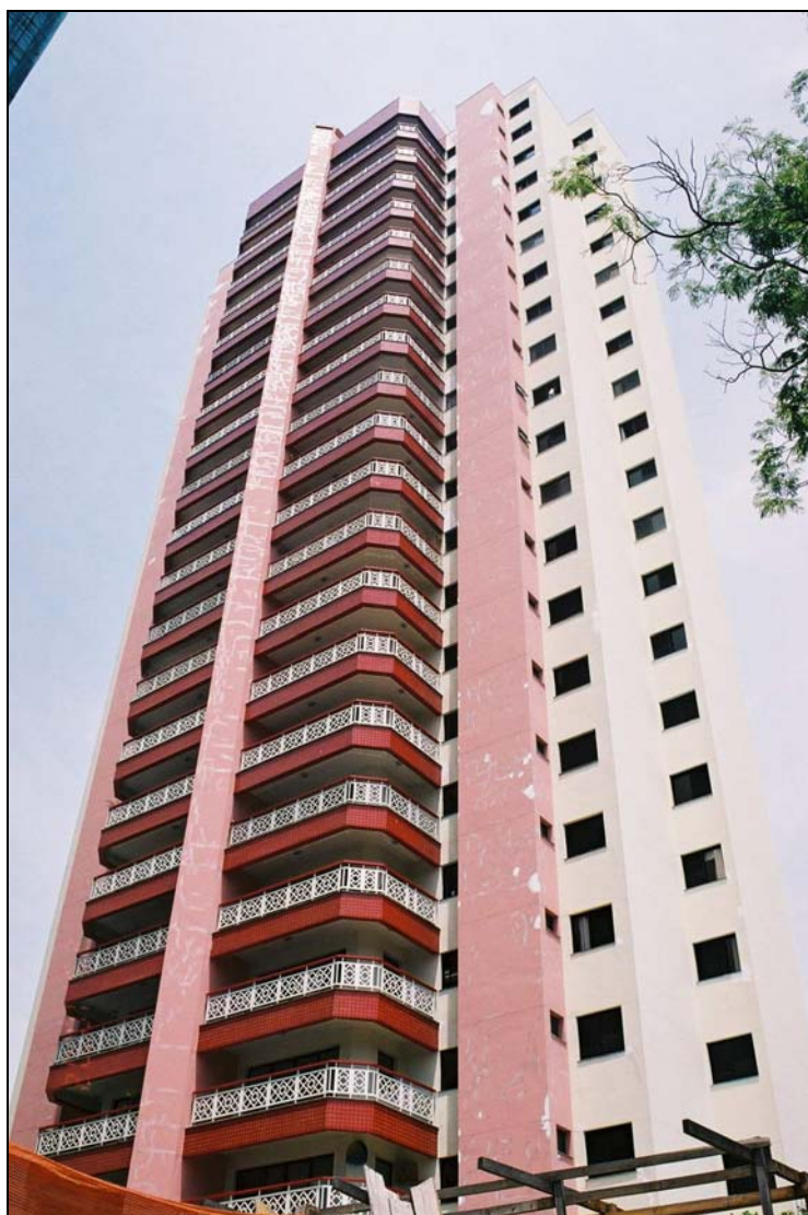
Foto 45: Vista da fachada principal.
