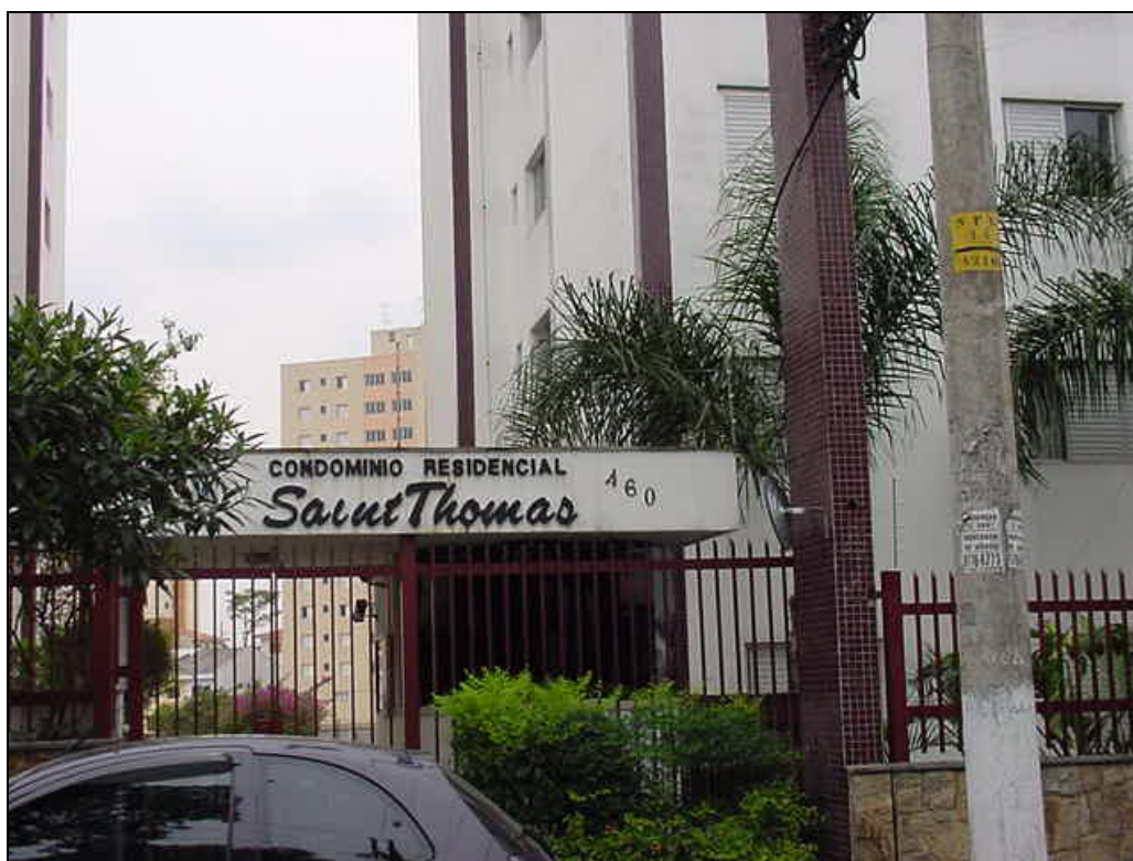
Foto 84: Vista da fachada principal.
