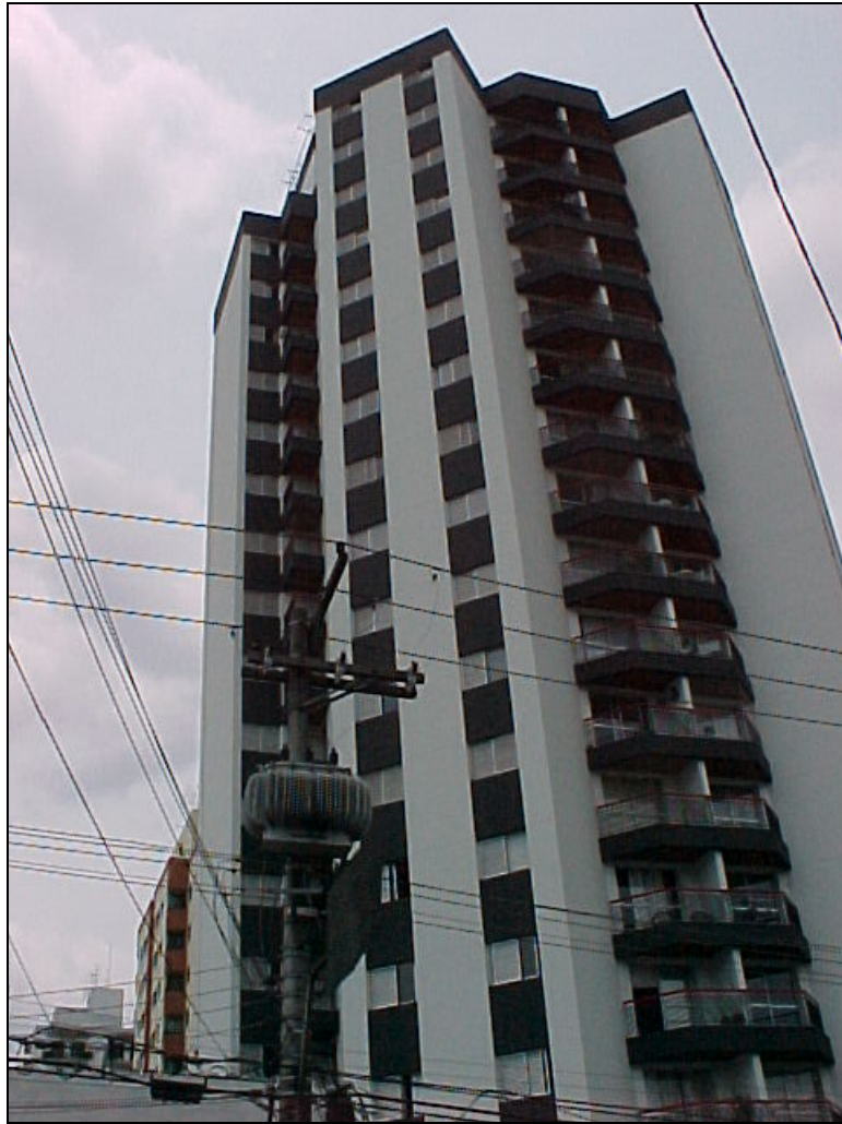
Foto 21: Vista da fachada principal.
