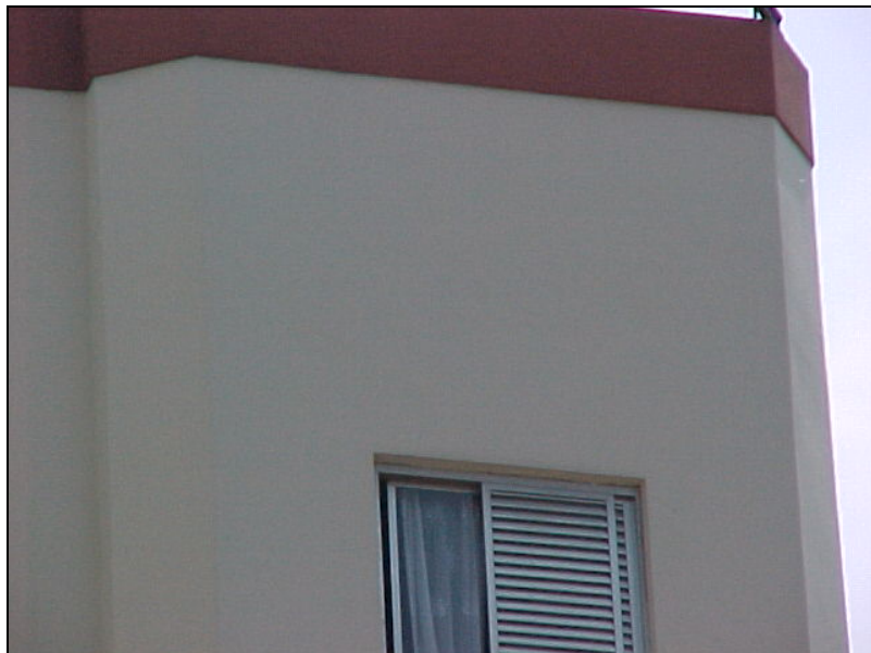
Foto 03: Detalhe da fachada de outro ângulo.
