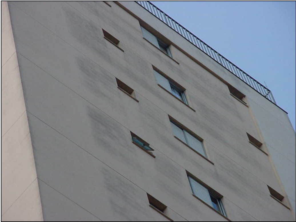
Foto 109: Detalhe da fachada principal.
