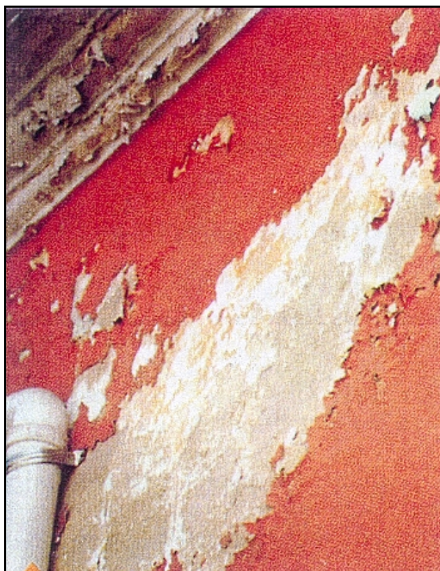
FOTO 03 - ocorrência: Descascamento
