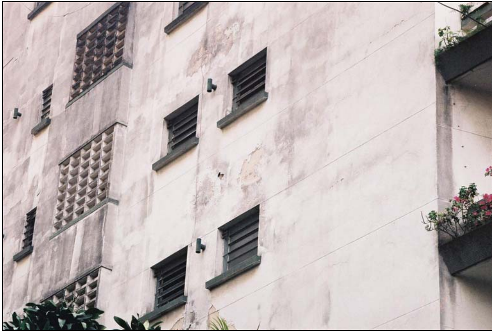
FOTO 15 – Vista de um edifício com 41 (quarenta e um) anos de vida sem programa de manutenção, com a pintura degradada.
