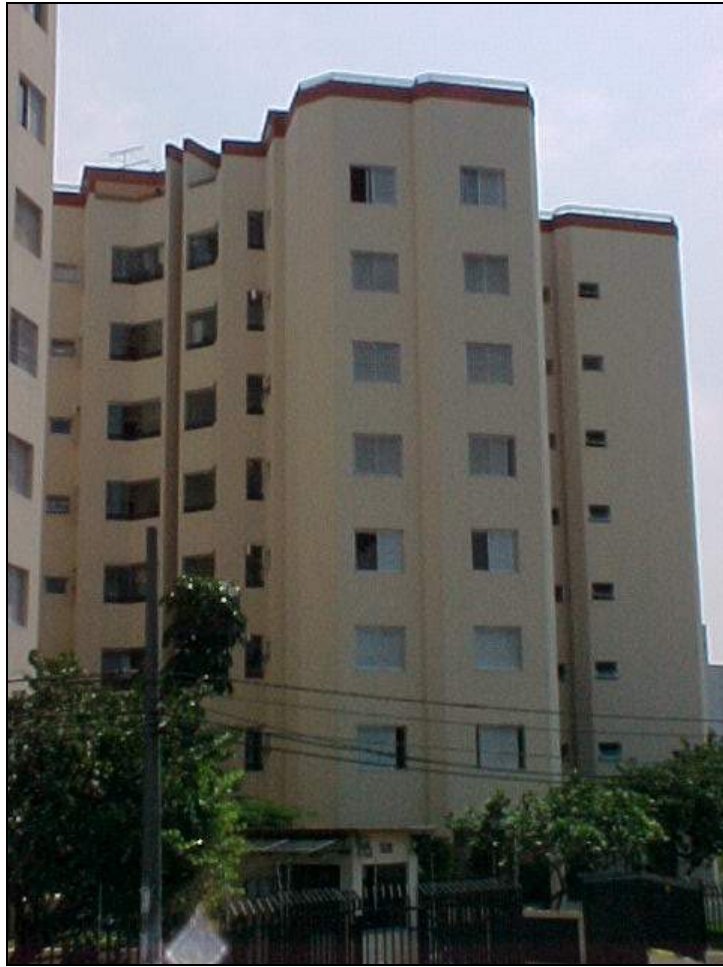
Foto 02: Detalhe da fachada principal.
