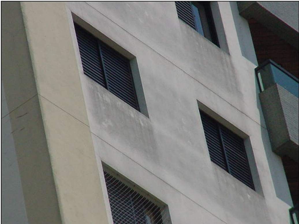
Foto 72: Detalhe da fachada principal.
