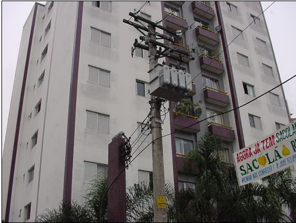
Foto 85: Detalhe da fachada principal.
