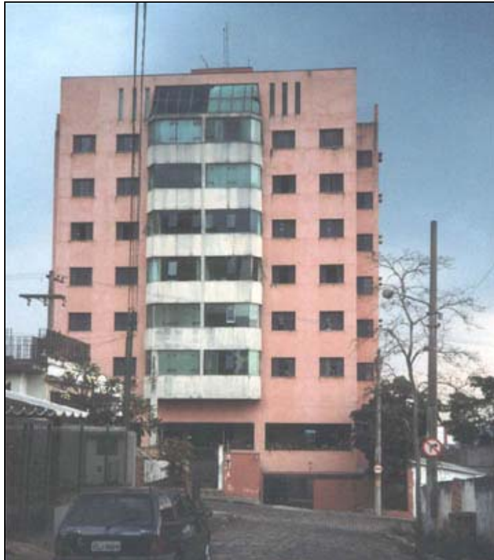
Foto 27: Vista da fachada principal.
