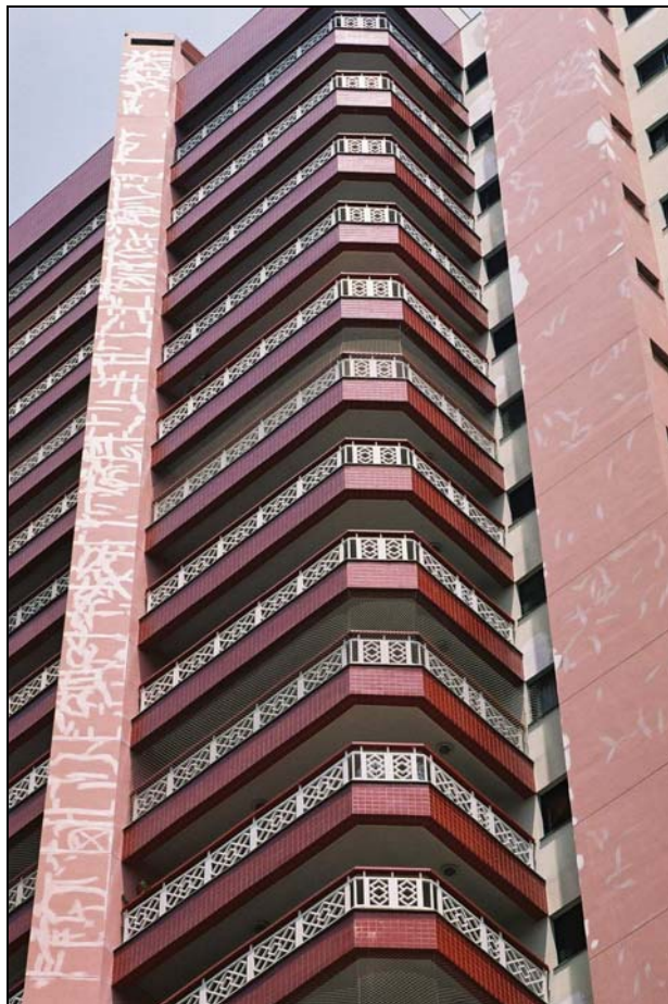
Foto 47: Vista da fachada principal.
