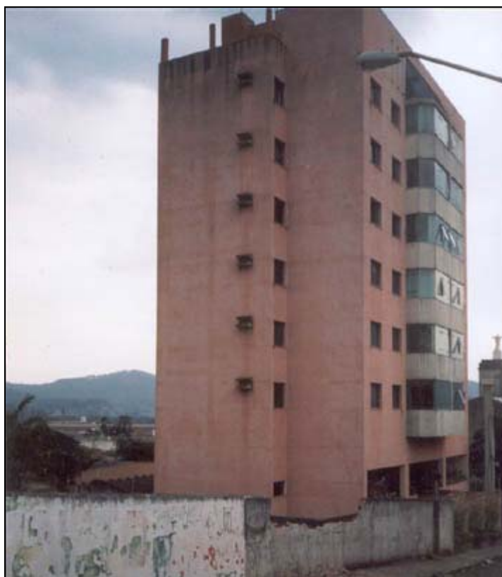
Foto 26: Vista da fachada principal.
