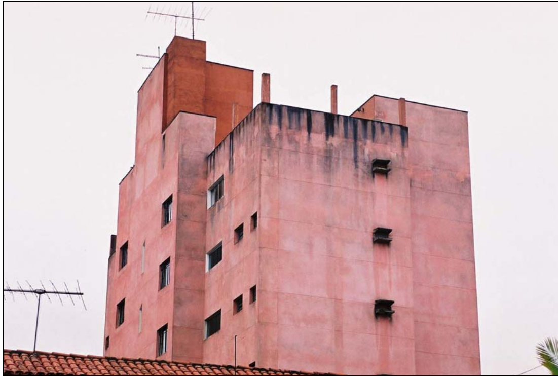
FOTO 13 – Vista de um edifício com 09 (nove) anos de vida sem programa de manutenção com a pintura em processo de degradação
