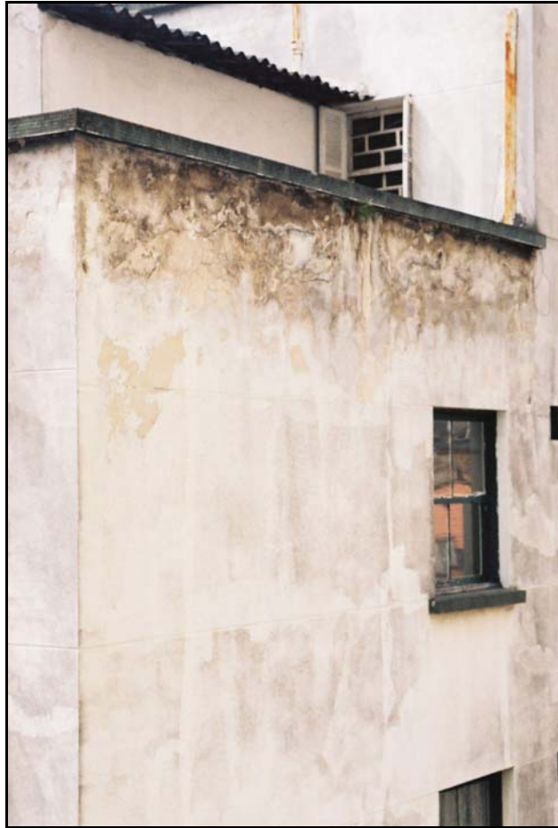
FOTO 10 – Detalhe do edifício com 41 (quarenta e um) anos de vida sem programa de manutenção de pintura, onde as necessidades dos usuários não são consideradas satisfeitas.
