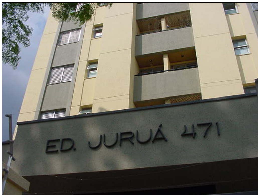
Foto 93: Vista da fachada principal.
