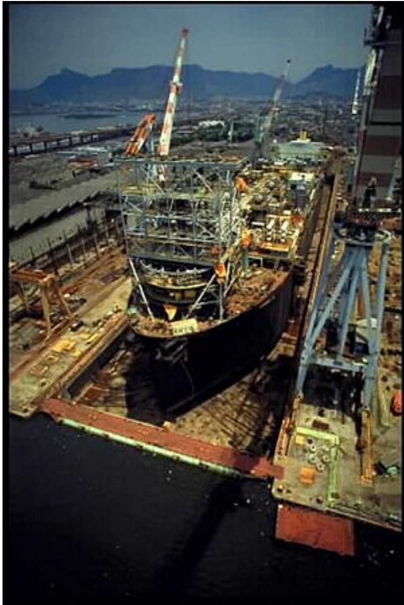
Obra de adaptação de um navio petroleiro usado e antigo para plataforma do tipo FPSO
