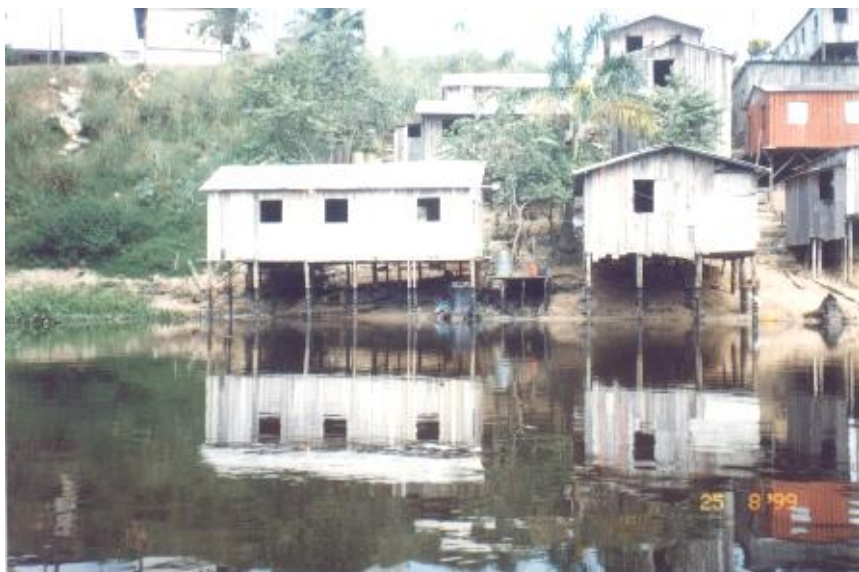
Ilustração 3 - Vista frontal da Vila da Felicidade com destaque na marca de óleo das colunas de sustentação das palafitas.
