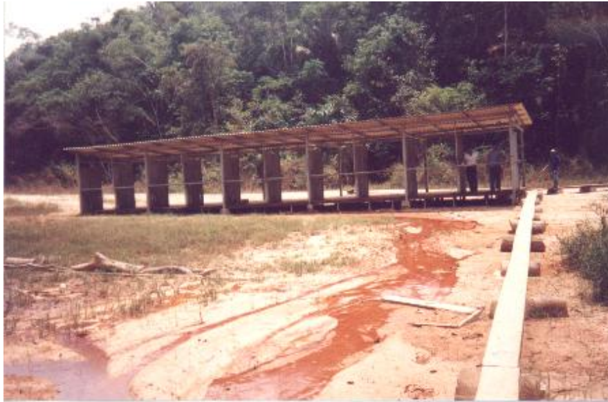
Ilustração 4 - Nascente do Igarapé, próximo ao estande de tiro da Marinha. Processo de assoreamento.
