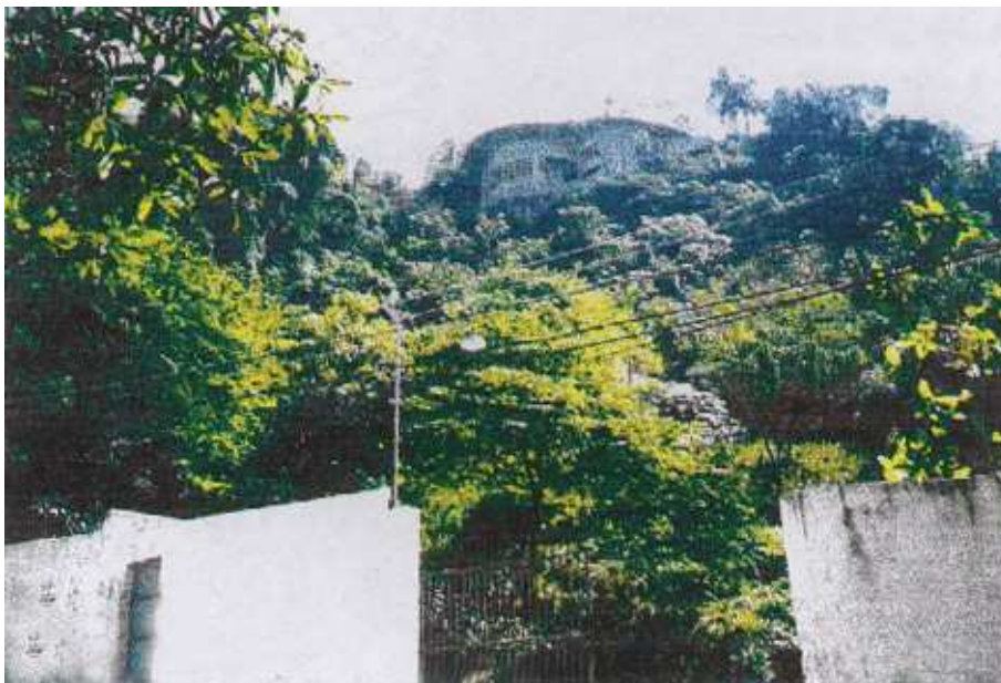
FOTO 1 – Situação local mais recente constatada na vistoria da Ação principal, 12 anos após o colapso; observar encosta natural replantada obstruindo a visibilidade das obras de contenção refeitas e/ou reforçadas.
