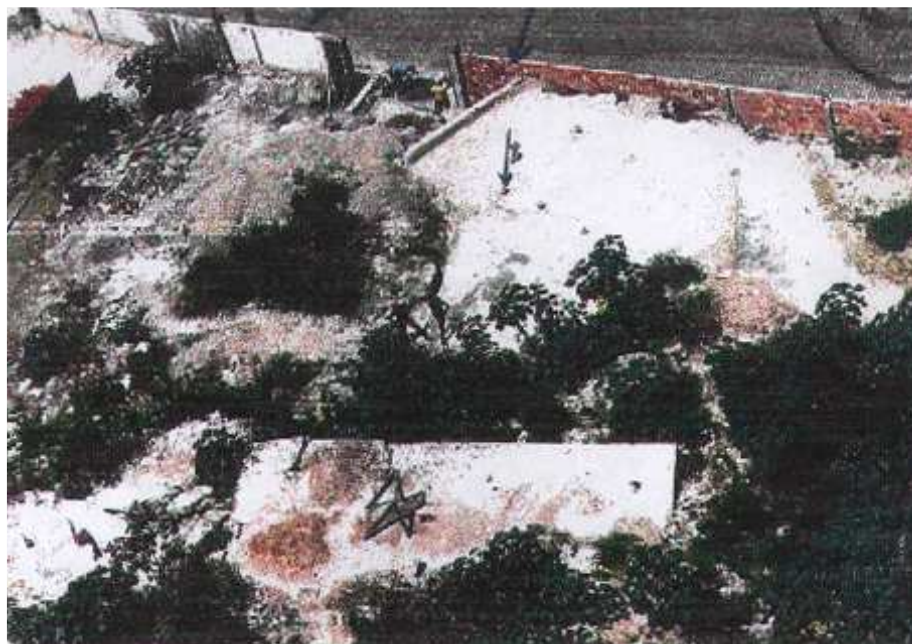
FOTO 7 – Foto da vistoria cautelar primária, tomada 10 meses após o acidente, mostrando posicionamento de partes dos painéis da Cortina 1 (primeiro plano) que ficou aparente na ruína (vide Foto 3) e da Cortina 2 (segundo plano) que ruiu primeiro, tombadas com as faces exteriores voltadas para cima; notar muro de tijolos da testada já recomposto, bem como o desentulhamento do local, expondo a Cortina 2.
