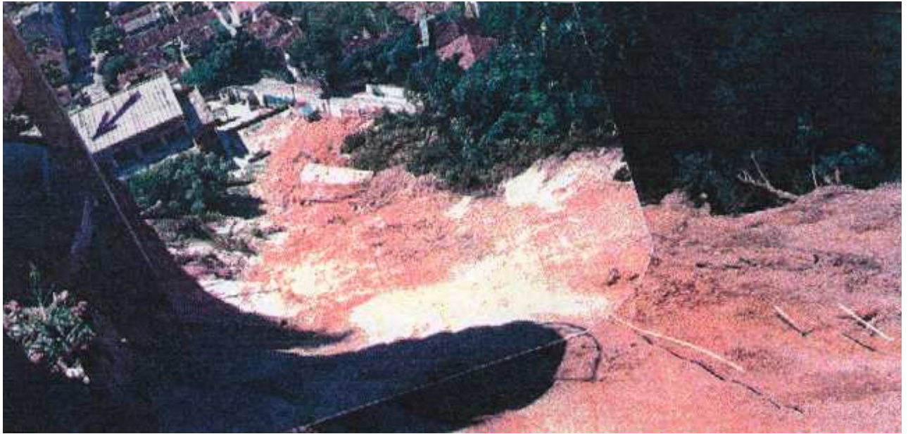
FOTO 3 – Aspecto geral do colapso, observado do topo do platô desabado; observar trecho de vários tirantes chumbados na encosta escoados na rotura; notar na massa desabada a Cortina 1 aparente na ruína, que foi atingida pela Cortina 2, que ruiu primeiro; veja-se danos no pilar da estrutura das piscinas.
