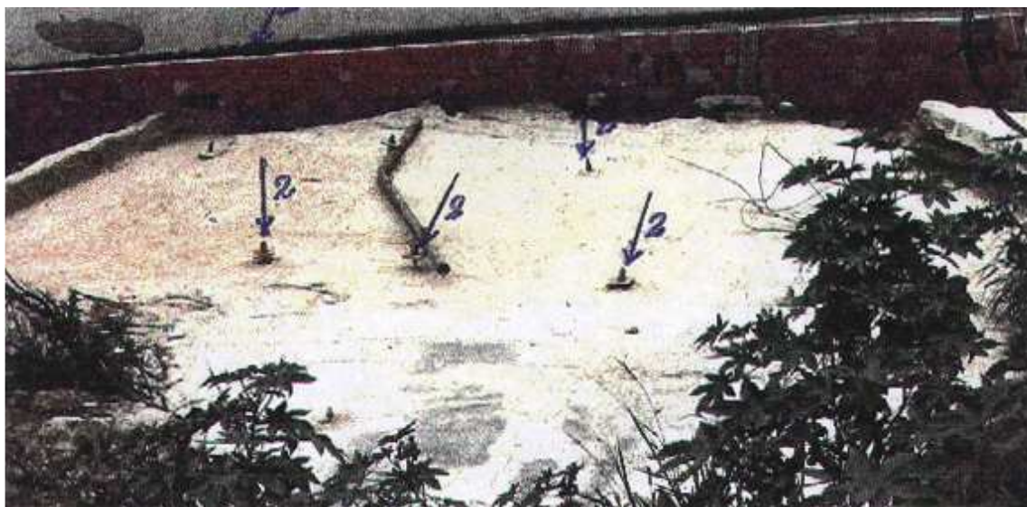
FOTO 8 – Detalhe da Cortina 2 (vide foto anterior) mostrando inúmeras cabeças de tirantes intactas, corroborando com a tese pericial de rotura generalizada da obra, de que houve escoamento coletivo dos tirantes, devido à minimização dos parâmetros de resistência ao cisalhamento do terrapleno, saturado e erodido pelas chuvas intensas que precederam o colapso.
