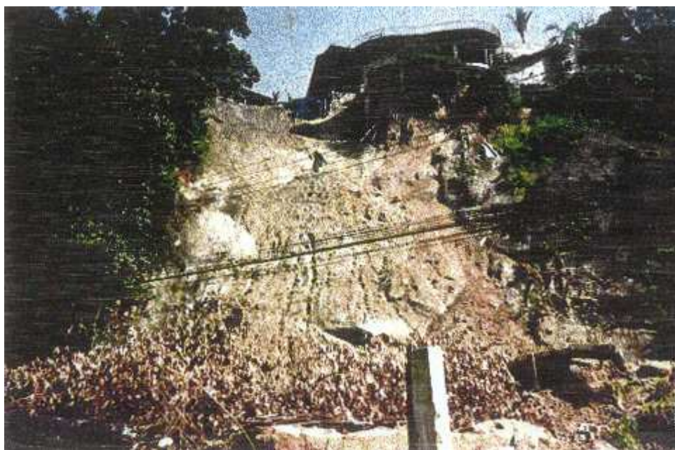
FOTO 2 – Situação local logo após o acidente, tomada do mesmo posicionamento relativo da foto anterior, constatada na vistoria de emergência do órgão municipal controlador; observar a superfície planar de ruptura e a estrutura das piscinas exposta pela ausência das cortinas desabadas
