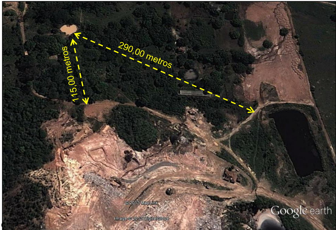
Figura 03: foto aérea da região com destaque para o imóvel objeto de estudo e lagoa de chorume (Fonte: Google Earth).
