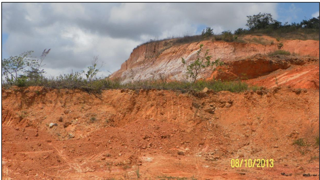
Foto 18: Vista do local onde houve escavação do talude para retirada de terra com o objetivo de aterrar o lixão, nas proximidades do imóvel em questão.
