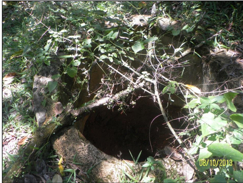
Foto 04: vista do poço existente no local.
