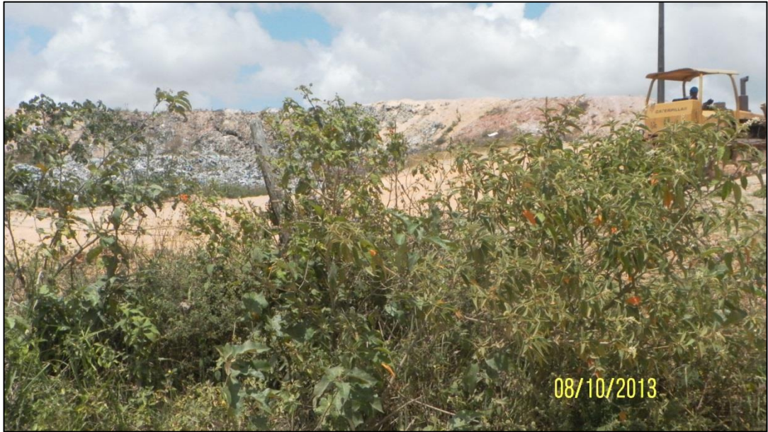
Foto 15: Vista de trator fazendo o aterro do lixo existente no local.
