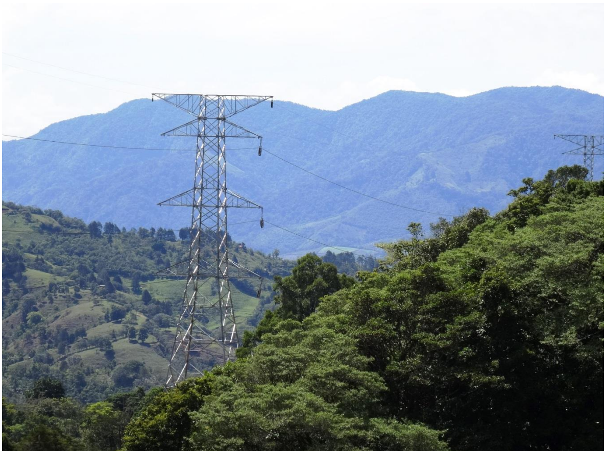
FOTOGRAFIA No. 1. Línea de Transmisión Eléctrica.
