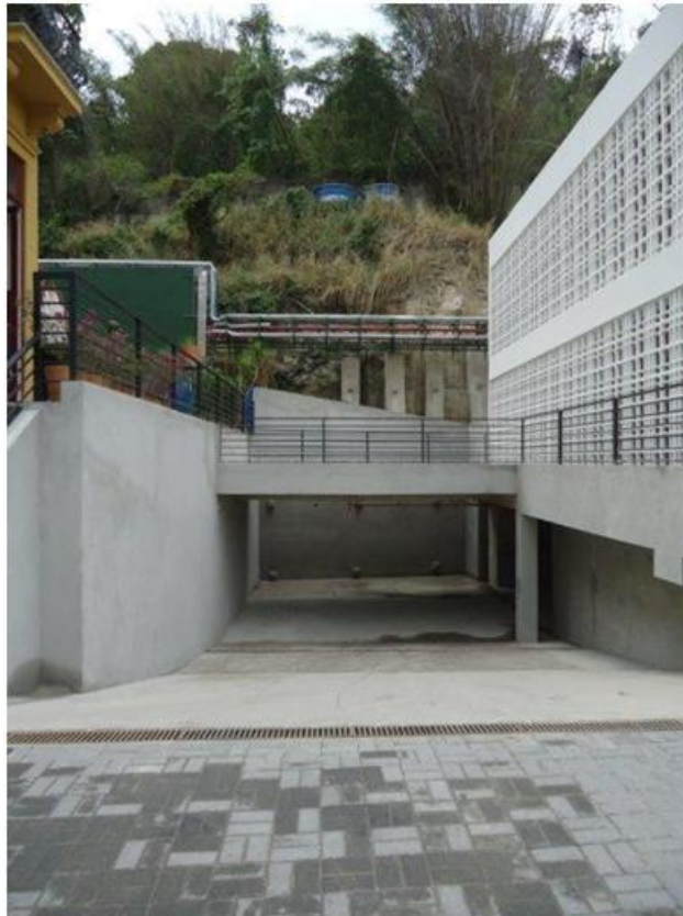
Edifício Baronesa e Rampa de acesso ao 1º subsolo - estacionamento Fonte: Autores
