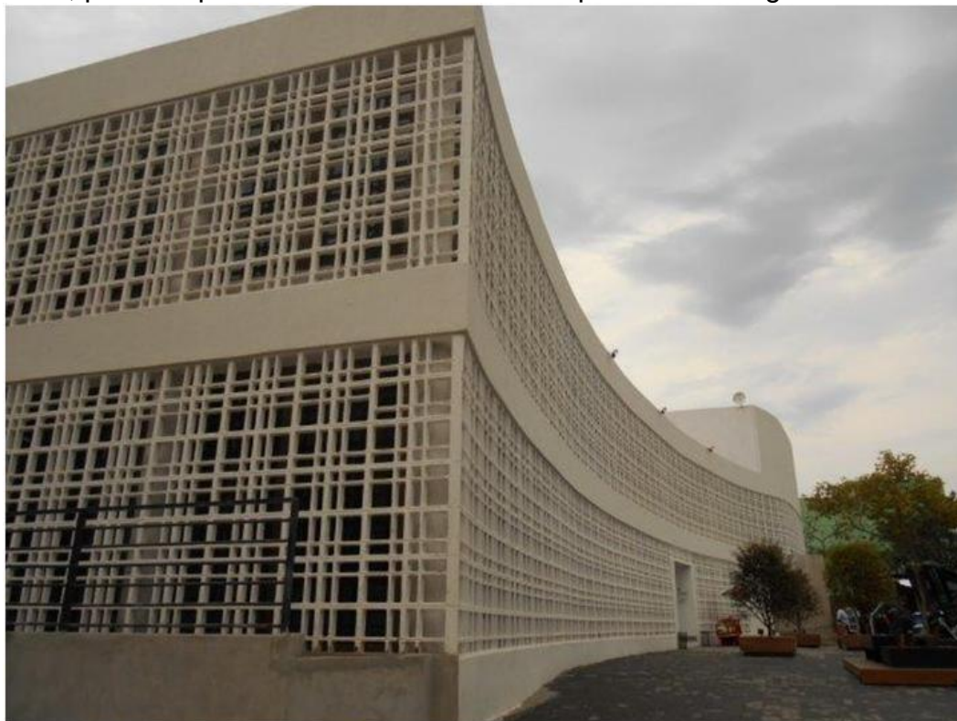
Edifício Baronesa e Rampa de acesso ao 1º subsolo - estacionamento Fonte: Autores
