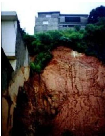
Uma conseqüência desastrosa da exposição das fundações e muros de contenção é o comprometimento da estabilidade do prédio como um todo, tendo em vista que tal exposição poderá tirar o apoio de tais elementos de sustentação, provocando uma situação de instabilidade, bem como poderá ocorrer a exposição da armadura de ferragem, provocando sua oxidação.
