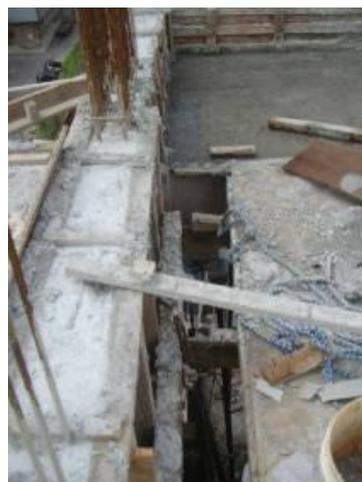
Tal como as fôrmas, as ferragens são empregadas ao longo de toda execução das obras de concreto armado, com uma peculiaridade, que no caso em tela se torna um agravante, o fato que na construção de pilares, muros de arrimo e algumas lajes, torna-se necessário deixar “esperas” de ferragens para a continuação da concretagem que acontece em fases.
