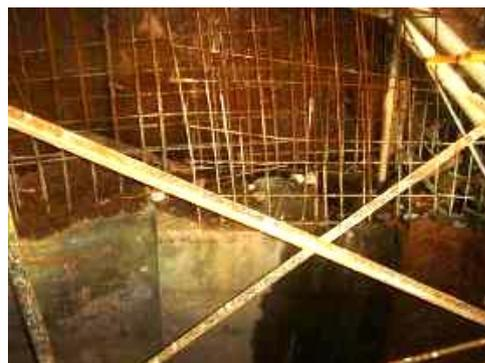
Com a paralisação das obras, estas esperas ficam diretamente expostas a ação das águas, podendo vir a ocasionar problemas dentro da peça de concreto, tendo em vista que estas esperas servem para receber as outras barras necessárias para continuação da concretagem.
