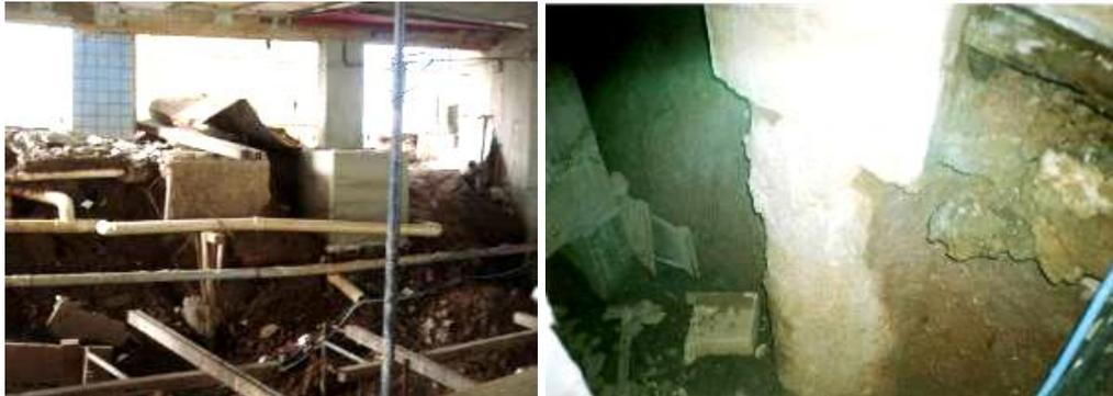
Com a manutenção do embargo à obra tais instalações provisórias poderão sofrer vazamentos, comprometendo a funcionalidade do escoamento de água e esgoto e, principalmente, ocasionando o carreamento dos solos que sustentam as fundações e muros de contenção, localizadas nos subsolos, expondo tais elementos de sustentação à intempéries, que poderá contribuir na aceleração da depreciação da obra.
