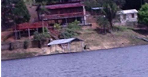
Fig 01 – Uso de materiais típicos de construções urbanas, telhas de fibrocimento e blocos de concreto.
