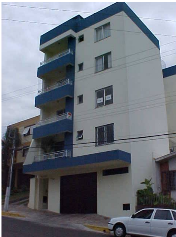
Figura 2 – Foto do edifício de 4 andares em estudo em Passo Fundo, RS
