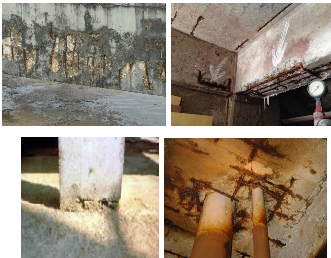
Figura 3 Fotos de estruturas com armaduras em processo de corrosão intensa
