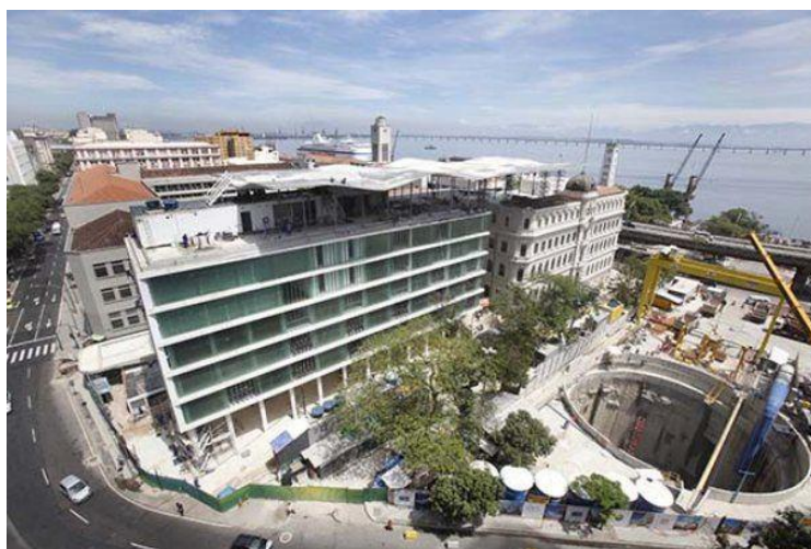
Figura 23 Fase construtiva do Museu do MAR
