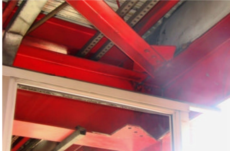
Figura 23: Cobertura metálica – Contraventamento - Vista geral
