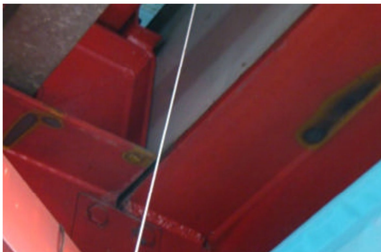
Figura 22: Cobertura metálica - Corrosão de elementos
