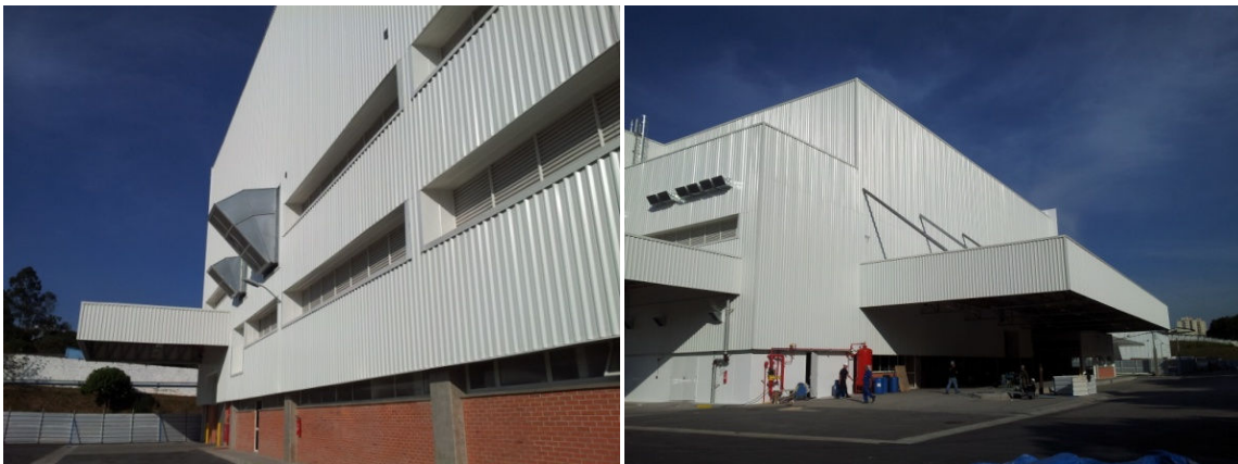
Figura 10: Fechamento lateral com telha
