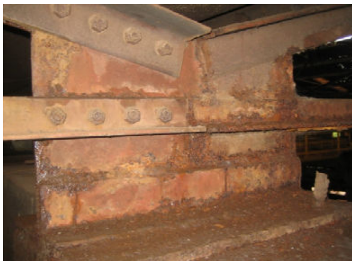
Figura 17: Detalhe de fixação de estrutura em pilar de alvenaria Fonte: ANDRADE, 2009
