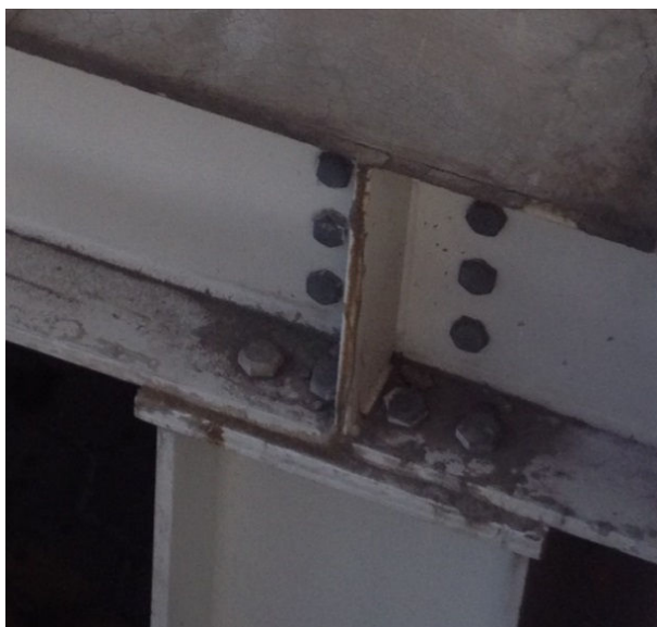
Figura 6 Exemplo de emenda parafusada
