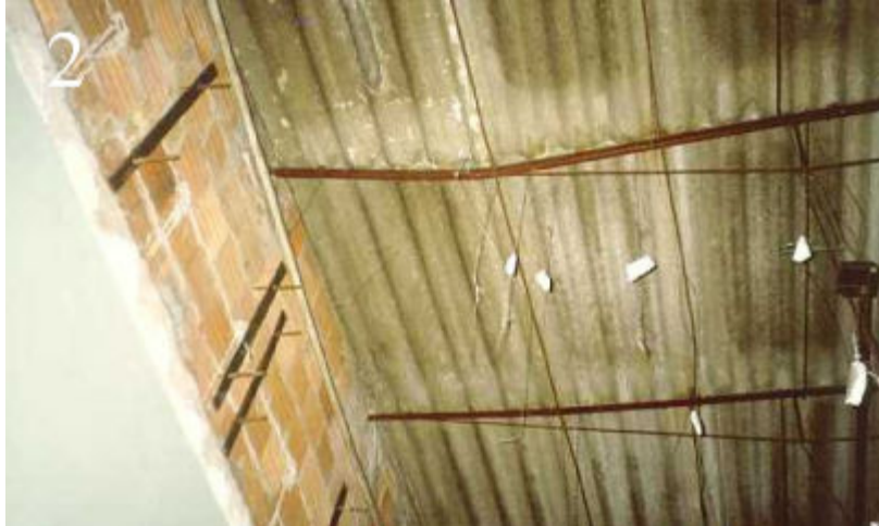
Figura 12: Deficiência de geometria Fonte: ANDRADE, 2009
