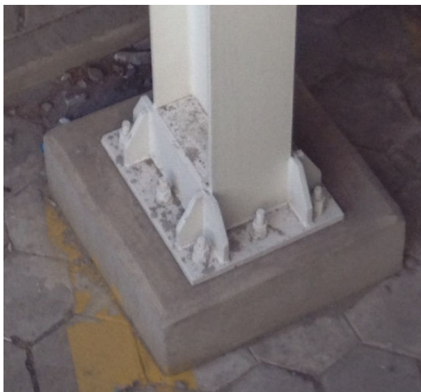
Figura 11: Fixação de base de pilar metálico
