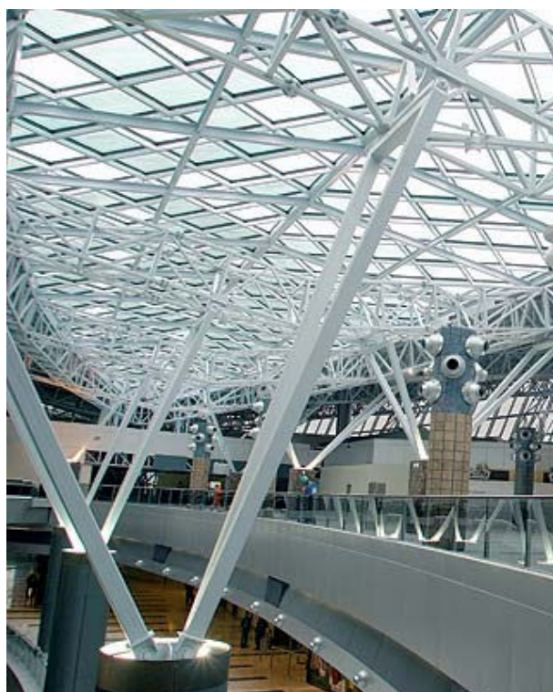
Figura 5: Exemplo de estrutura metálica de cobertura Fonte: AMNBRASIL, 2015
