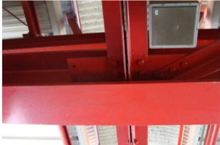
Figura 19: Cobertura metálica - Contraventamento- Defeito de geometria
