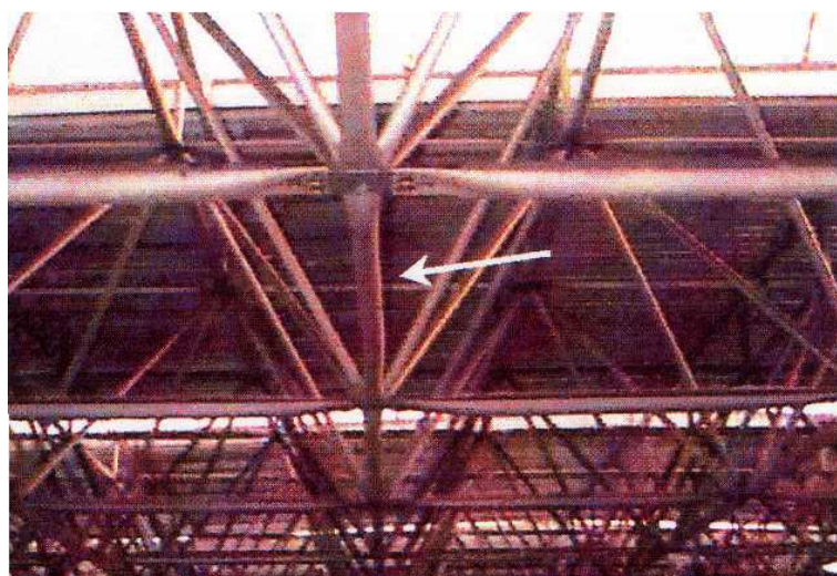
Figura 13: Deformação por flexão de peça do banzo inferior
