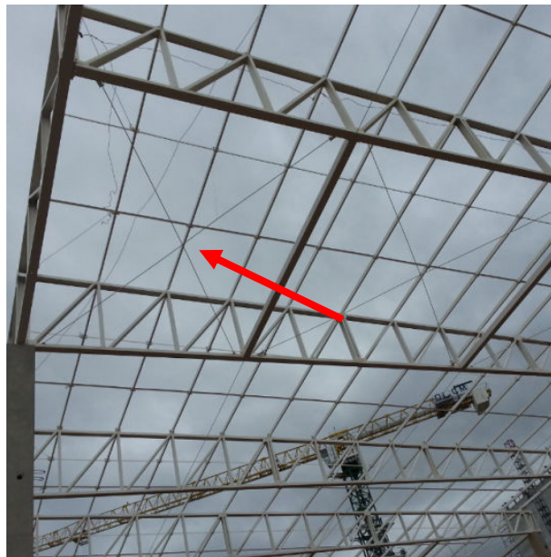
Figura 8: Contraventamento em estrutura de cobertura
