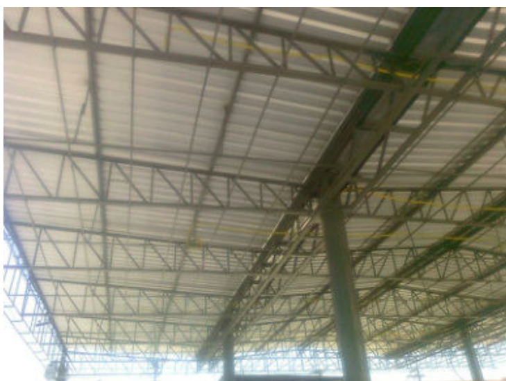
Figura 18: Exemplo de deficiência de contraventamento em coberturas Fonte: DUARTE, 2014
