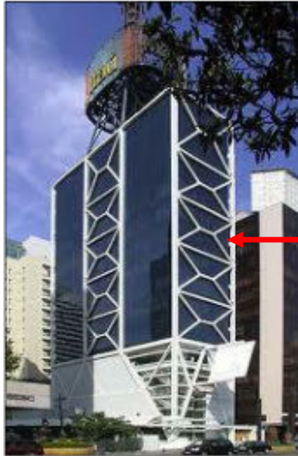
Figura 9: Contraventamento em estrutura de edifício Fonte: DUARTE, 2014
