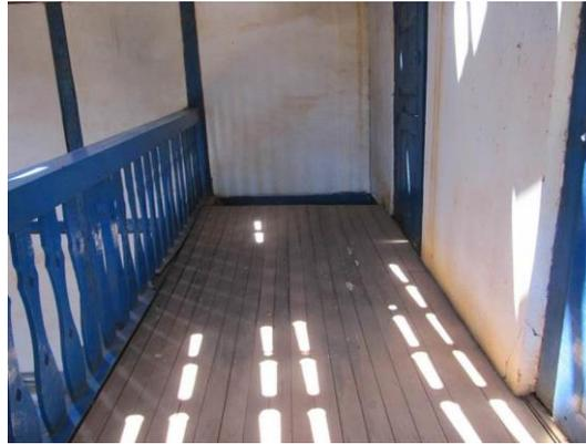
*Figura 21: Vista do coro, com piso em tabuado de madeira, guarda corpo revestido com pintura na cor azul. (Nunes, 2014).*
