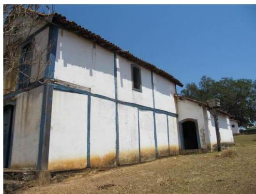
*Figura 7: Fachada lateral direita da Capela. Percebe-se a presença dos enquadramentos na fachada, com ritmo regular entre as divisões (Nunes, 2014)*
