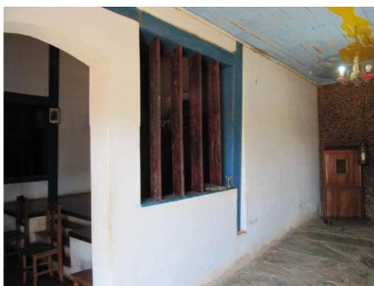
*Figura 20: Vista do vão de ligação entre o altar lateral esquerdo e o altar principal. O vão da porta possui acabamento em pintura, diferente dos outros vãos, que possuem acabamento em madeira e pintura azul. (Nunes, 2014).*
