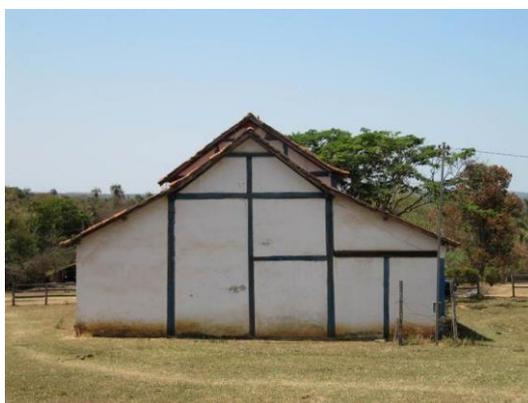
*Figura 9: Fachada posterior da Capela. Nota-se a presença de dois pés direitos diferentes na edificação, percebidos externamente pelas diferenças entre as alturas das cumeeiras. (Nunes, 2014).*
