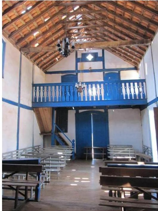
*Figura 16: Vista da nave, com o coro ao fundo. Não há forro neste ambiente. O piso é em tabuado liso. O guarda corpo do coro se assemelha ao existente na porção da nave mais próxima ao altar. (Nunes, 2014).*
