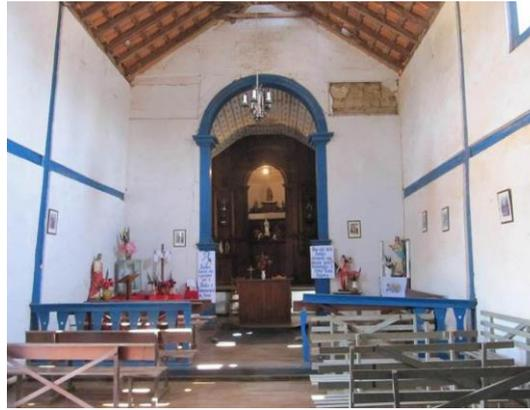
*Figura 12: Vista da nave principal da Capela. Nota-se uma separação entre o altar e a nave. A nave não possui forro: a estrutura do telhado fica aparente. O enquadramento encontra-se visível, também, na face interna das paredes. (Nunes, 2014).*
