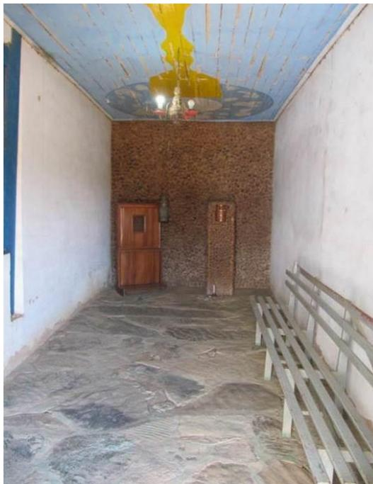
*Figura 19: Vista do altar lateral esquerdo. Este ambiente possui piso em pedras, uma parede revestida com pequenas pedras e forro em madeira pintado na cor azul e com o desenho de um cálice e uma óstia (Nunes, 2014).*
