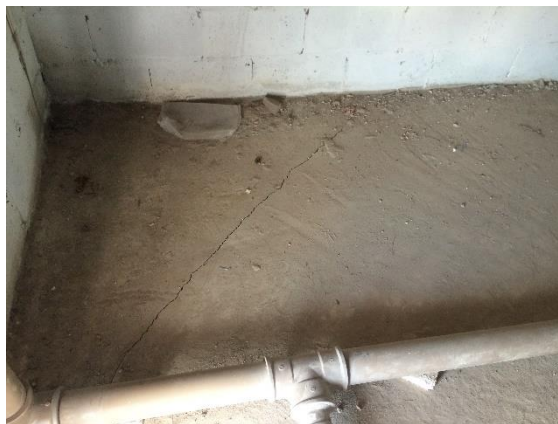
FIGURA 15 – Trinca no canto da laje
