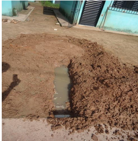
FIGURA 10 – Ausência da ligação entre o filtro e o coletor público
