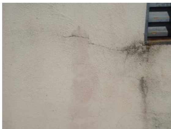
Figura 3 – Fissura no canto inferior da esquadria
