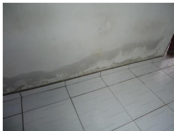
Figura 7 – Infiltração por capilaridade
