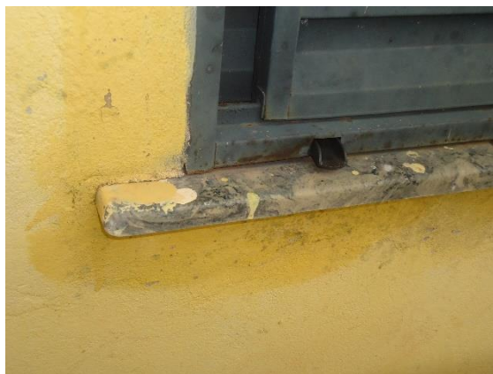
Figura 4 - Umidade em torno da esquadria
