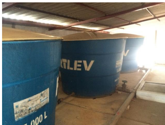
FIGURA 13 – Reservatórios de água sobre a laje com trincas
