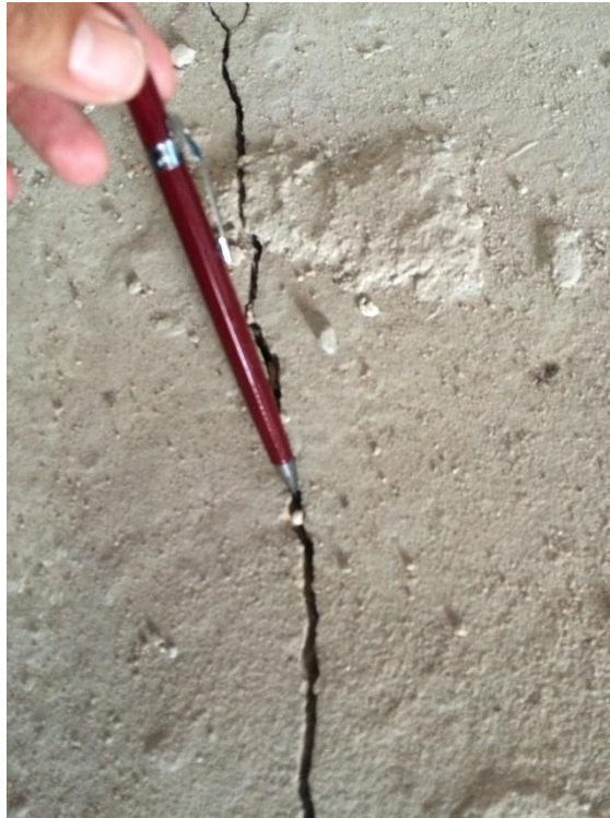
FIGURA 14 – Trinca na parte superior da laje
