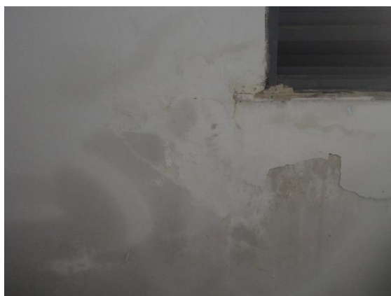
Figura 5 – Manchas no interior da casa
