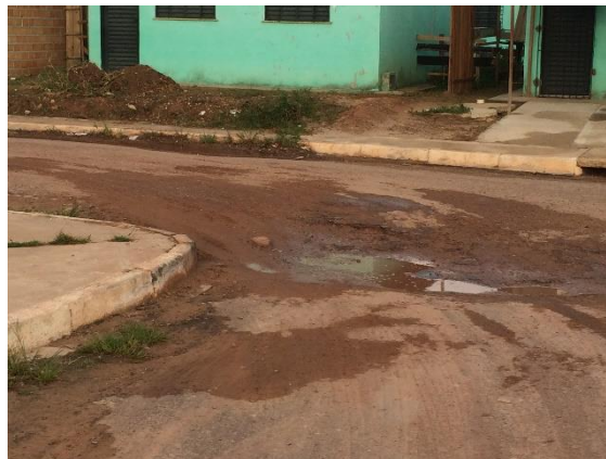
FIGURA 12 – Pavimentação asfáltica em péssimas condições
