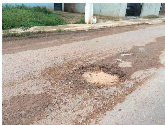
FIGURA 11 – Problemas na pavimentação asfáltica
