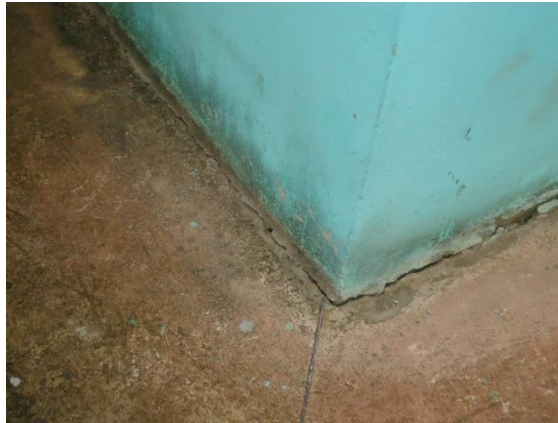
Figura 8 – Recalque diferencial
