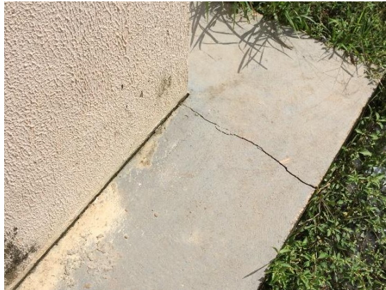
Figura 9 – Recalque diferencial na calçada periférica
