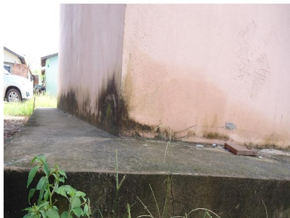
Figura 6 – Umidade e manchas na parte inferior das paredes externas
