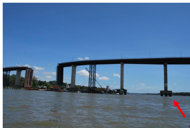
Figura 7 –Vista geral dos trechos da ponte, envolvidos nos acidentes em 2014, no mês de março (desabamento de parte do tabuleiro) e novembro com dano em estaca (seta).
