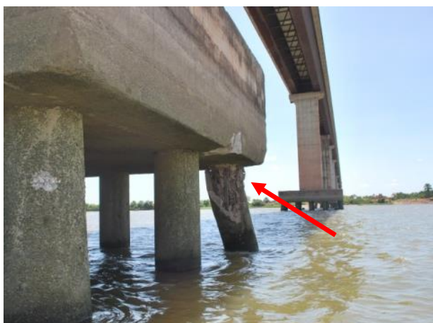
Figura 6 –Vista da estaca danificada (seta) no acidente de novembro/2014.
