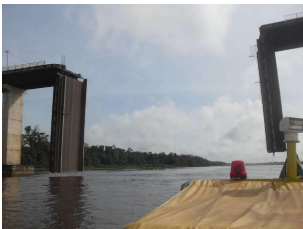
Figura 4 – Vista do dano no tabuleiro no acidente de março/2014.
