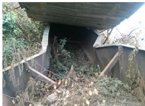
Figura 9: Flambagem lateral da longarina.
