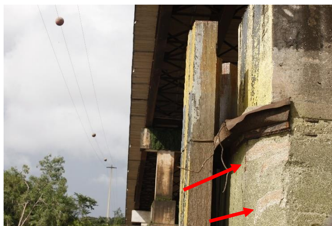
Figura 3 – Vista do dano nas defensas e bloco, no acidente de 2014.
