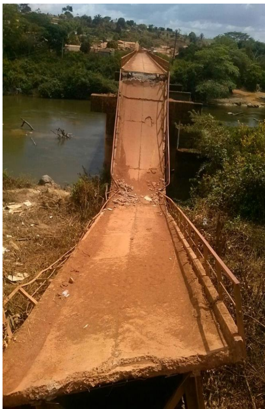
Figura 8: Tabuleiro da ponte colapsada
