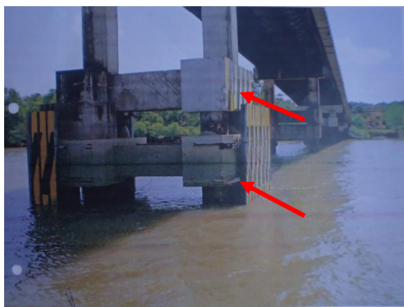
Figura 2 – Vista do dano no bloco, no acidente de 2007.
