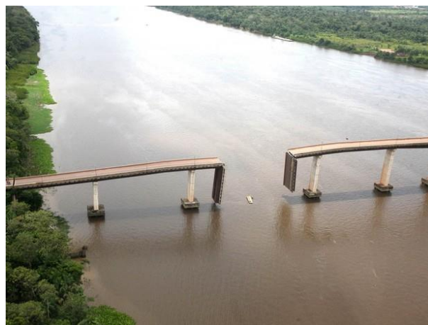
Figura 5 – Vista aérea da ponte sobre o Rio Moju em março de 2014.
