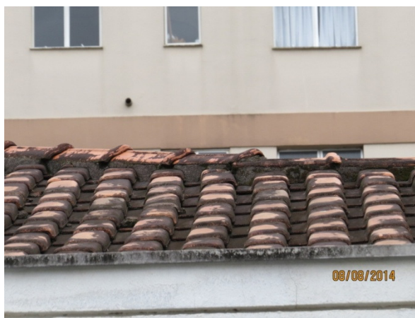
Fotografia 02 – INSPEÇÃO DETALHADA. Notar desalinhamento das telhas cerâmicas.
