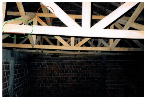
Fotografia 28 – TRELIÇAS ORIGINAIS. Notar ligação frágil à tração (círculo verde) e aplicação indevida de carga, fora do 'nó' (círculo vermelho).
