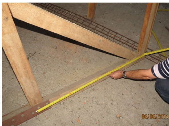
Fotografia 07 – INSPEÇÃO DETALHADA. No detalhe, aferição de medidas de uma das treliças remanescentes.
