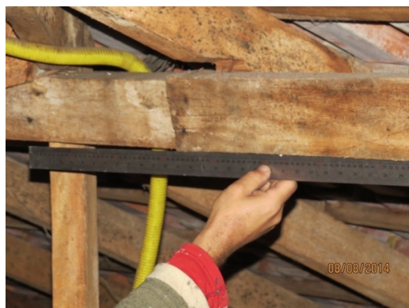
Fotografia 16 – INSPEÇÃO DETALHADA. No detalhe, observar no sistema de cobertura atual o uso de peças de madeira com diferentes bitolas, unidas de maneira inadequada.
