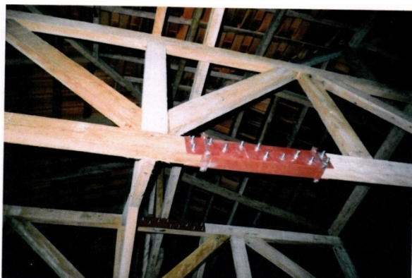
Fotografia 19 – TRELIÇAS ORIGINAIS. Observar ligação composta por chapa metálica e parafusos. Fonte: Laudo de Vistoria elaborado por engenheiro independente.
