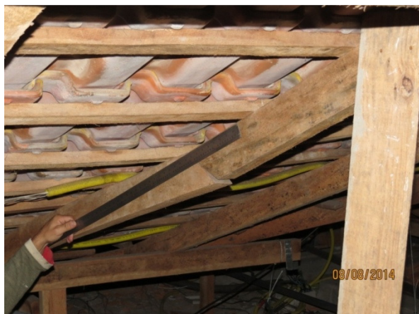
Fotografia 13 – INSPEÇÃO DETALHADA. No detalhe, observar deslocamento e desalinhamento em caibro do sistema de cobertura atual.
