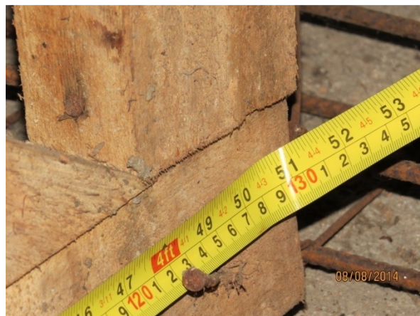
Fotografia 36 – TRELIÇAS REMANESCENTES. Notar ligação típica, por uso de pregos em pequeno número.
