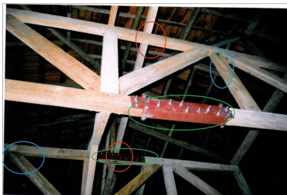
Fotografia 32 – TRELIÇAS ORIGINAIS. Notar ligação em chapa metálica e parafusos (círculo verde), apoios indevidos fora dos 'nós' (círculos vermelhos) e manchamento indicativo de umidade elevada (círculos azuis).
