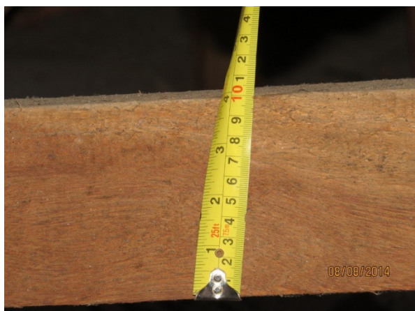
Fotografia 25 – TRELIXA. No detalhe, verificação da bitola das peças (altura de 10cm).
