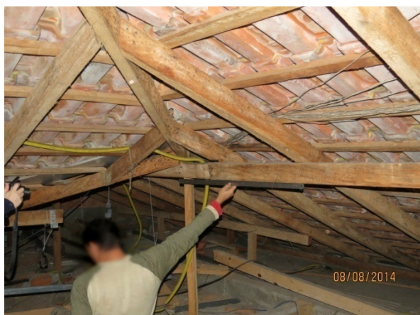
Fotografia 15 – INSPEÇÃO DETALHADA. Vista parcial do madeiramento que compõe o sistema de cobertura atual.
