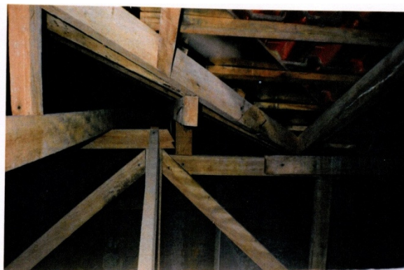
Fotografia 22 – TRELIÇAS ORIGINAIS. Notar manchamento generalizado, indicativo de umidade excessiva. Fonte: Laudo de Vistoria elaborado por engenheiro independente.
