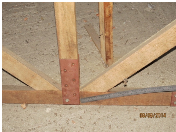
Fotografia 35 – TRELIÇAS REMANESCENTES. No detalhe, ligação por uso de chapa metálica e parafuso único. Notar ausência de diversos outros parafusos e o fato da chapa não abranger todas as barras do ‘nó’.
