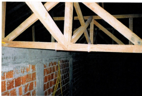
Fotografia 18 – TRELIÇAS ORIGINAIS. Vista parcial. Notar existência de ligação por braçadeiras metálicas, junto ao banzo inferior. Fonte: Laudo de Vistoria elaborado por engenheiro independente.
