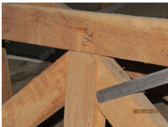
Fotografia 37 – TRELIÇAS REMANESCENTES. No detalhe ligação típica, executada somente por uso de alguns poucos pregos.
