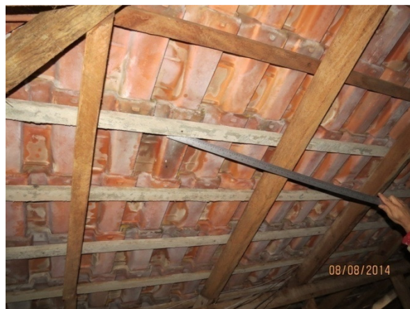
Fotografia 14 – INSPEÇÃO DETALHADA. Vista parcial do sistema de cobertura atual mostrando as telhas cerâmicas, ripas e caibros.
