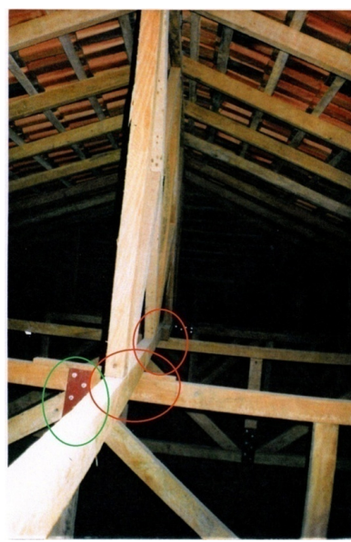
Fotografia 30 – TRELIÇAS ORIGINAIS. Notar ligação em chapa metálica e parafusos (círculo verde) e apoios indevidos fora dos 'nós' (círculos vermelhos).
