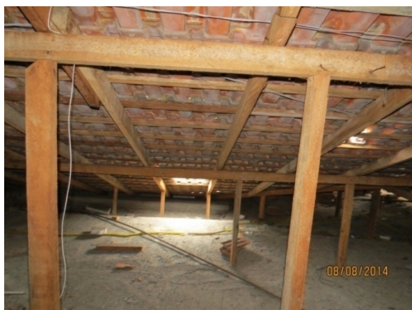
Fotografia 11 – INSPEÇÃO DETALHADA. Notar que o sistema de cobertura atual utiliza-se de pontaltes apoiados diretamente sobre a laje.
