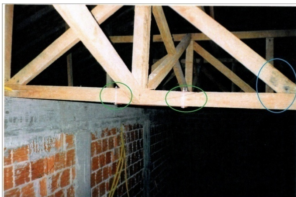
Fotografia 31 – TRELIÇAS ORIGINAIS. Notar ligação frágil à tração, por uso de abraçadeiras (círculos verdes) e manchamento indicativo de umidade excessiva (círculo azul).
