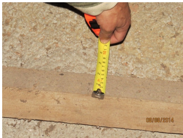
Fotografia 24 – TRELIXA. No detalhe, verificação da bitola das peças (largura de 5cm).
