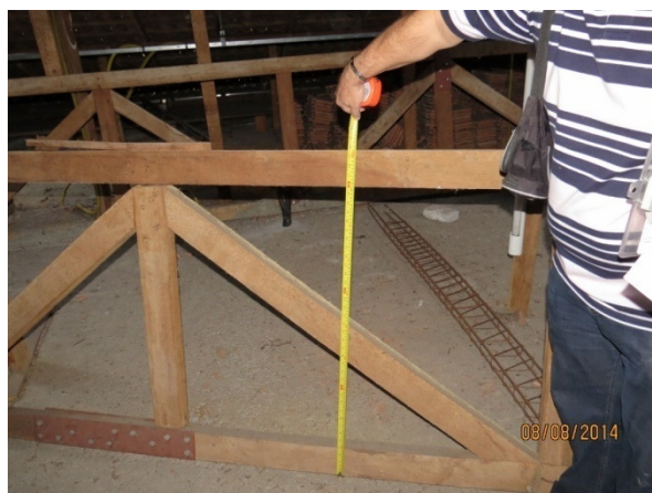
Fotografia 26 – TRELIXA. Notar tipologia construtiva adotada.
