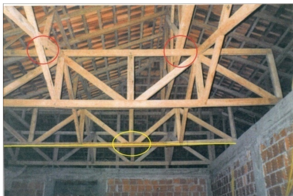
Fotografia 27 – TRELIÇAS ORIGINAIS. Notar deformação expressiva, no centro do vão, com ordem de grandeza de aprox. 5cm (linha/círculo amarelo). Observar ainda a aplicação indevida de cargas, fora dos 'nós' (círculos vermelhos).
