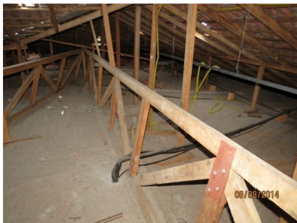
Fotografia 23 – VISTA PARCIAL. Notar a presença das treliças.
