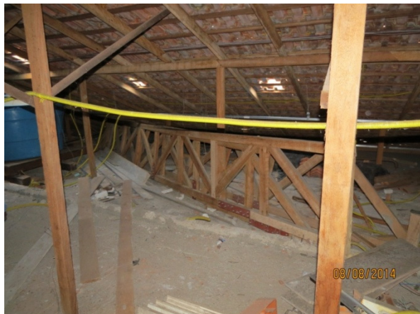
Fotografia 05 – INSPEÇÃO DETALHADA. Observar a preservação das treliças originais, sob o sistema de cobertura atual.
