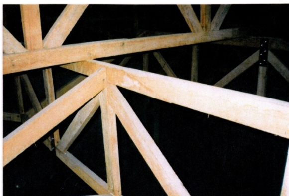
Fotografia 20 – TRELIÇAS ORIGINAIS. Observar que o apoio da treliça de cumeeira ocorre fora do 'nó'. Fonte: Laudo de Vistoria elaborado por engenheiro independente.
