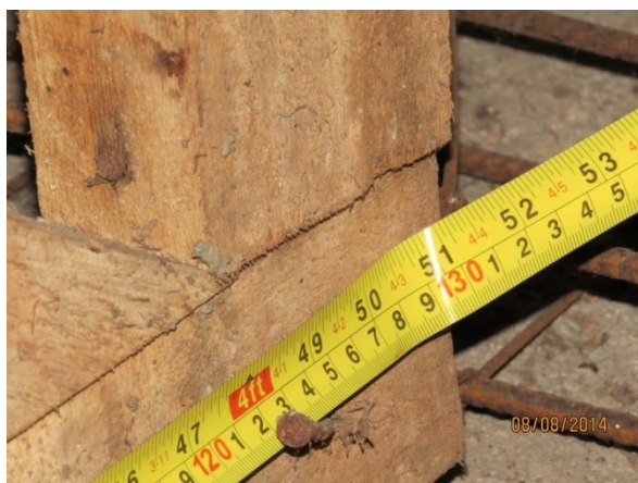
Fotografia 08 – INSPEÇÃO DETALHADA. Na treliça, observar ligação típica, executada por uso de pregos.
