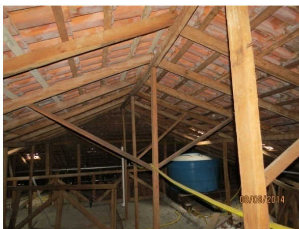
Fotografia 04 – INSPEÇÃO DETALHADA. Vista interna geral do sistema de cobertura atual.
