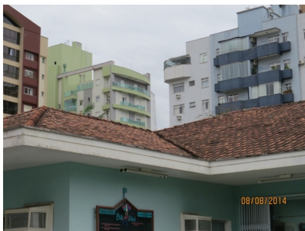
Fotografia 01 – INSPEÇÃO DETALHADA. Vista externa parcial do sistema de cobertura atualmente existente.
