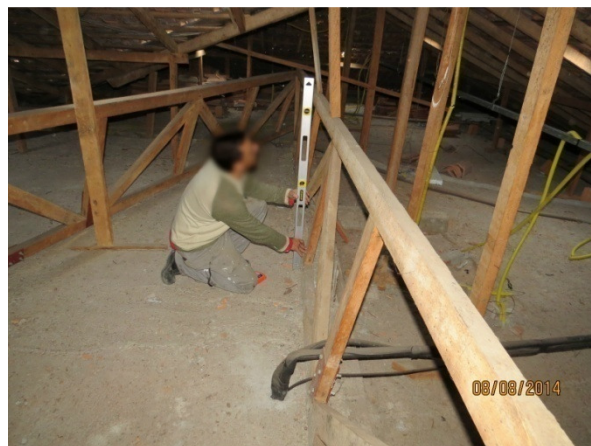
Fotografia 10 – INSPEÇÃO DETALHADA. No detalhe, a utilização indevida de uma das treliças como elemento de apoio aos pontaltes do sistema de cobertura atual.
