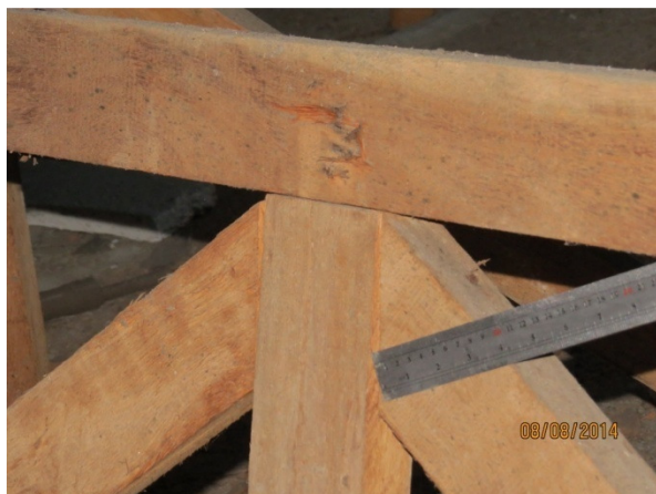
Fotografia 09 – INSPEÇÃO DETALHADA. No detalhe, treliça comum de suas ligações típicas, executada por uso de pregos.
