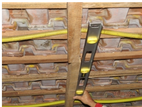
Fotografia 12 – INSPEÇÃO DETALHADA. No detalhe, caibro do sistema de cobertura atual apresentando desalinhamento/deslocamento importante.
