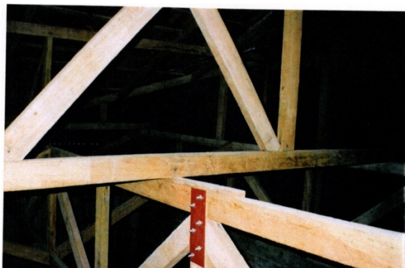
Fotografia 21 – TRELIÇAS ORIGINAIS. Notar presença de ligação por chapas metálicas e parafusos, uso de 'calço' de madeira e apoio indevido da treliça superior, fora do 'nó'. Fonte: Laudo de Vistoria elaborado por engenheiro independente.
