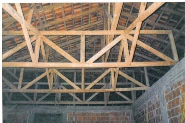
Fotografia 17 – TRELIÇAS ORIGINAIS. Vista geral. Fonte: Laudo de Vistoria elaborado por engenheiro independente.
