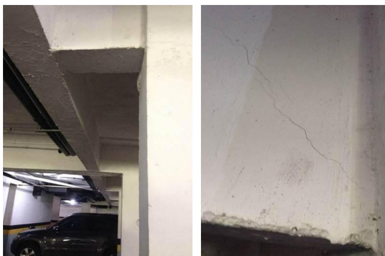
Fissuras em trecho de balanço de viga: vista da posição da viga na estrutura e detalhe da fissura
