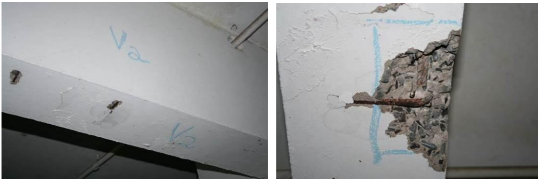
Demarcação da zona de escarificação da viga para o ensaio, local com ocorrência de desprendimento do concreto de cobrimento
