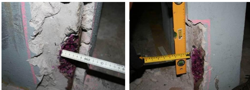
Marcação da superfície não carbonatada do concreto, numa profundidade média de dois a três milímetros
