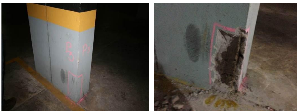
Demarcação, extração e aspersão do reagente na superfície do concreto e na borda do revestimento de reboco
