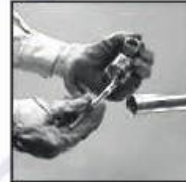
Figura 29 – Aplicação de fluxo na bolsa
