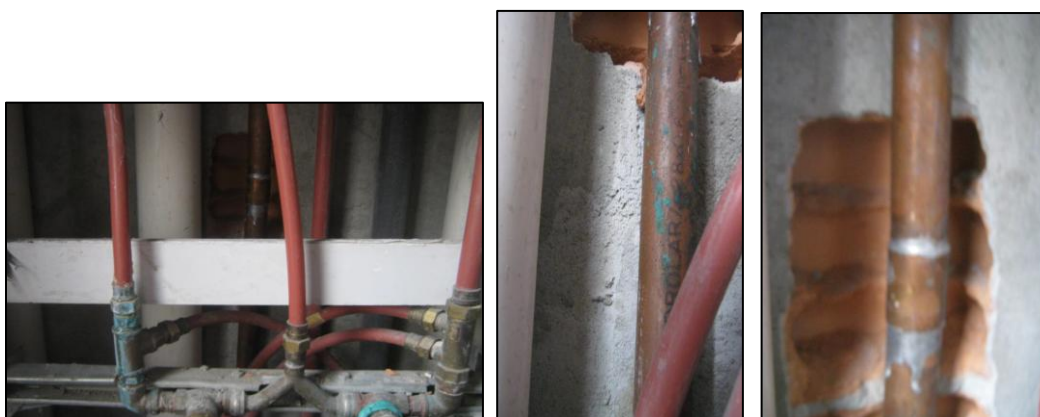
Tubulação em cobre sem problemas de vazamentos.
