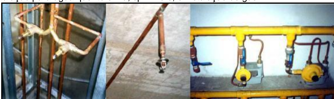
Fotos da aplicação de tubos de cobre
