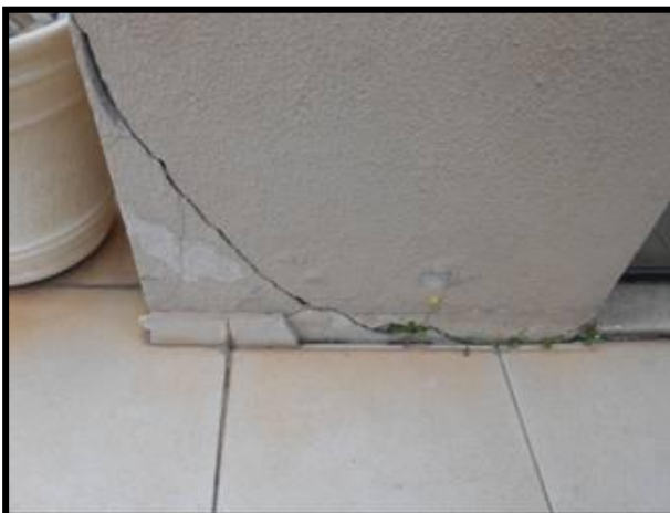
Brotamento de vegetação na fachada, com fissuração e desprendimento do revestimento
