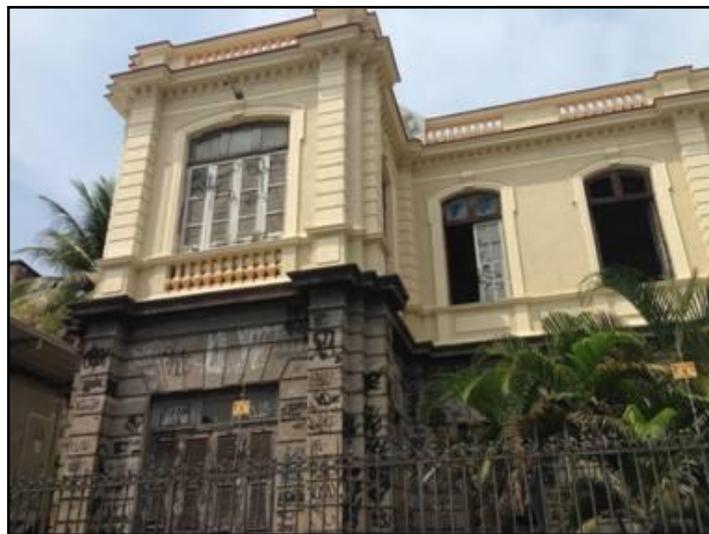
Edificação neoclássica com início de processo de revitalização, com pintura do segundo pavimento, cantaria com pichações e esquadrias danificadas.
