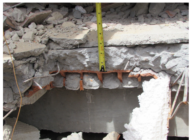
Figura 7- Lajes pré-moldadas executada com blocos cerâmicos e excesso de concreto no capeamento com duas camadas perfazendo 12 cm aproximadamente (CREA 2014)
