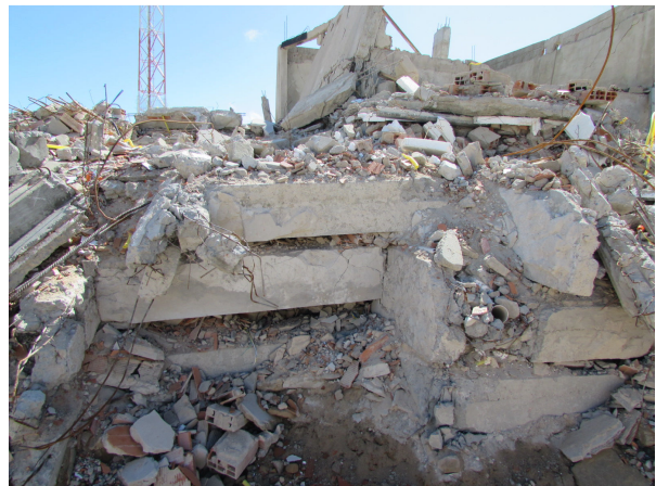
Figura 5 – Grande compactidade dos escombros (CREA 2014)
