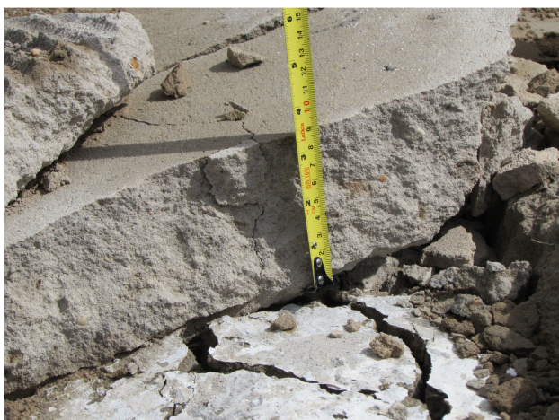
Figura 6 - Espessura da camada de proteção mecânica da cobertura com 9 cm (CREA 2014)
