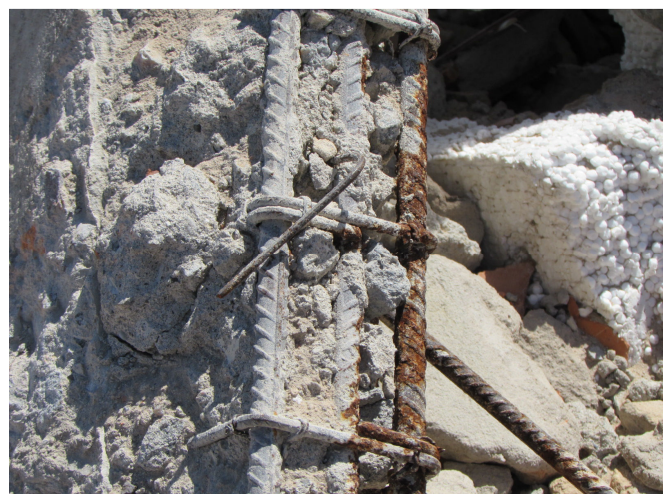
Figura 13 – Conc. poroso e desagregado (CREA 2014)
