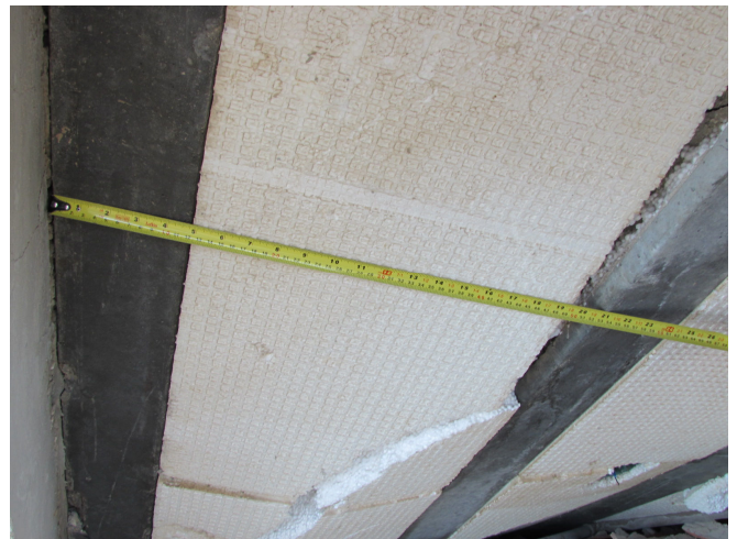
Figura 11 – Enchimento de laje (CREA 2014)
