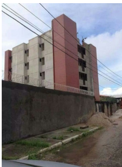
Figura 3 – Vista da fachada posterior da obra antes do colapso em maio/2014 (fCREA, 2014)
