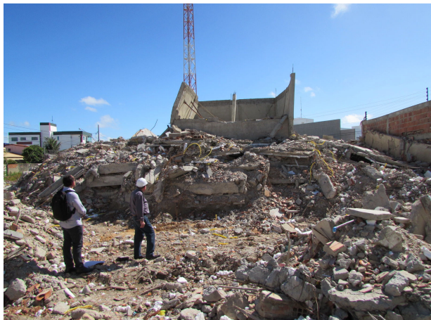
Figura 4 - Visita geral dos escombros (CREA 2014)
