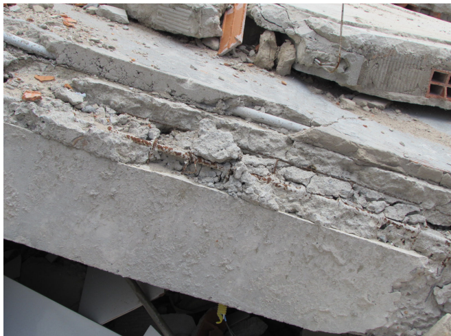
Figura 10 - Desagregação do concreto (CREA 2014)
