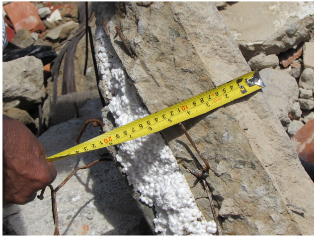
Figura 8 - Problema idêntico ao anterior em lajes com material inerte em isopor (CREA 2014)
