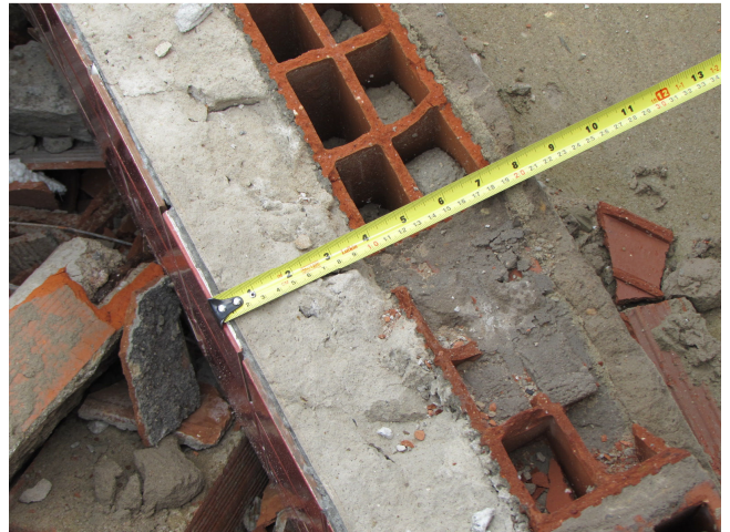
Figura 9 - Alvenarias com excesso de revestimento. Emboço com 10cm de espessura (CREA 2014)
