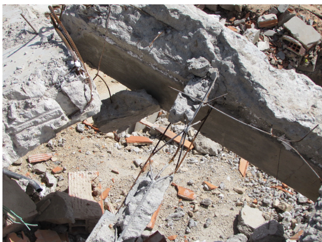
Figura 12 - Armadura das nervuras (CREA 2014)
