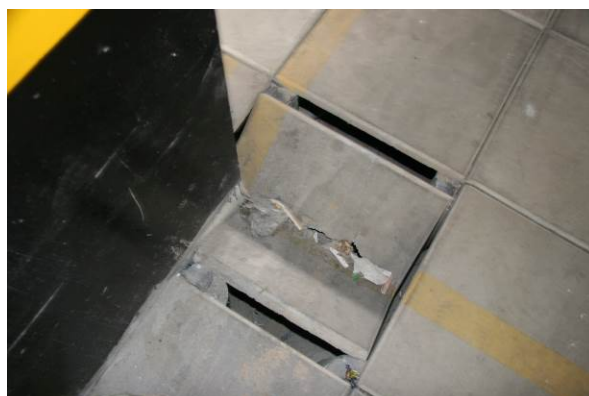
Fotos 5 e 6 : Modo típico de ruptura das placas
