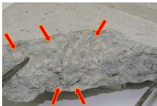
Figura 5 - Regiões com evidências de desidratação do concreto
